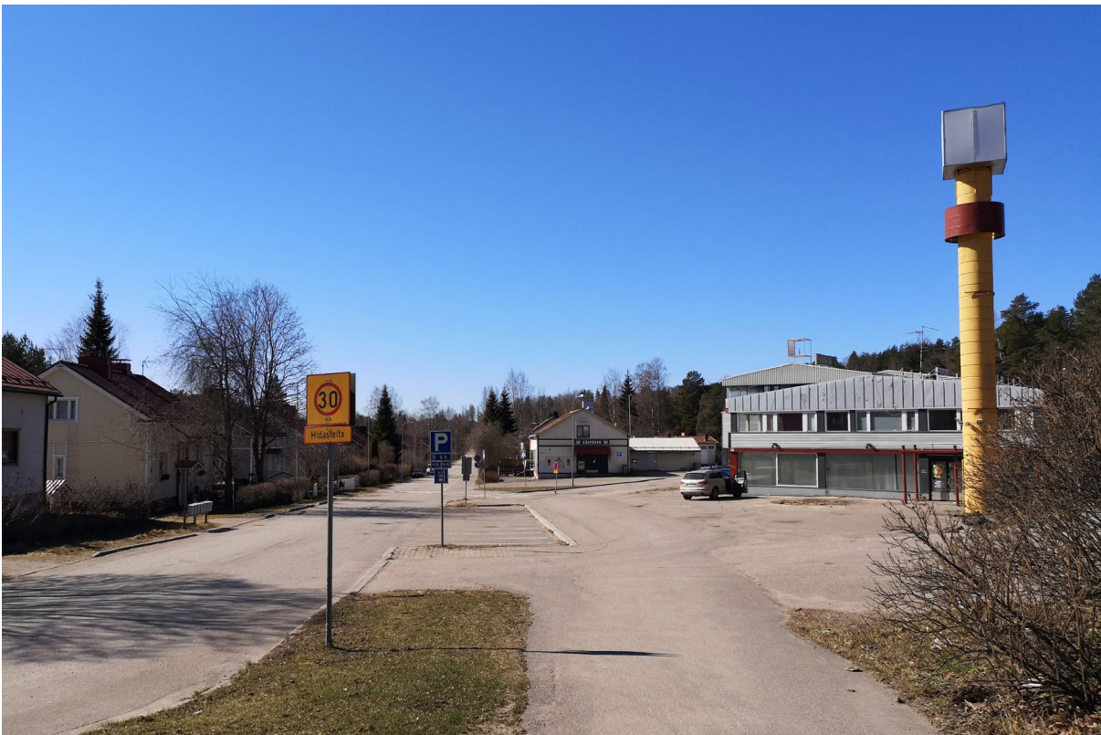
Kuva 6. Katunäkymä Okeroistentieltä. Katu, pysäköintikampa, jalkakäytävä ja piha-alue muodostavat epämääräisen laajan asfaltoidun alueen.
