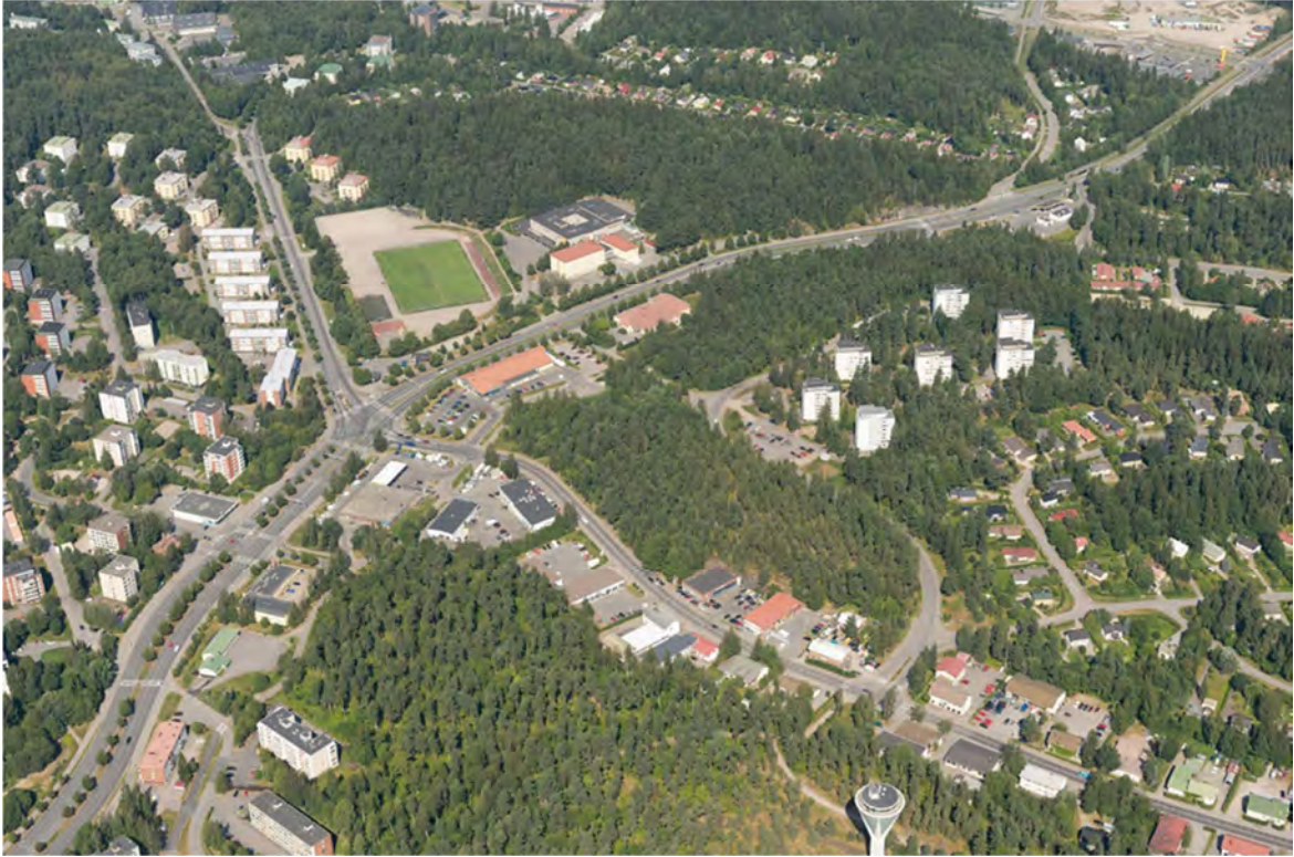
Viistoilmakuva asemakaava-alueesta ja ympäristöstä kohti pohjoista.
