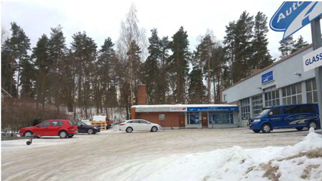
Kuva. Ylin pihatalo on jo korkeammalla kuin katu ja liittyy korkeusasemansa puolesta Kivistönmäen puistoon.
