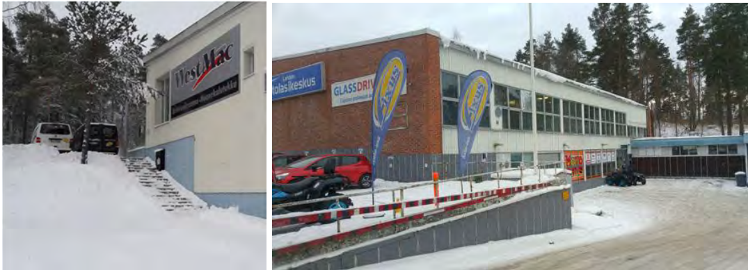
Kuvapari. Hirsimetsäntien sijainti pihatasoja korkeammalla on johtanut erilaisten portaiden, luiskien ja tasanteiden rakentamiseen.
