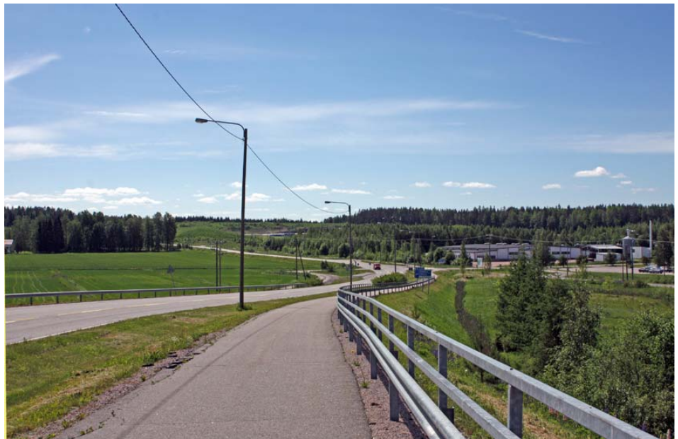
Kuva 22. Näkymä Heinämaantieltä rautatien ylittävältä sillalta etelään. Oikealla teollisuutta
