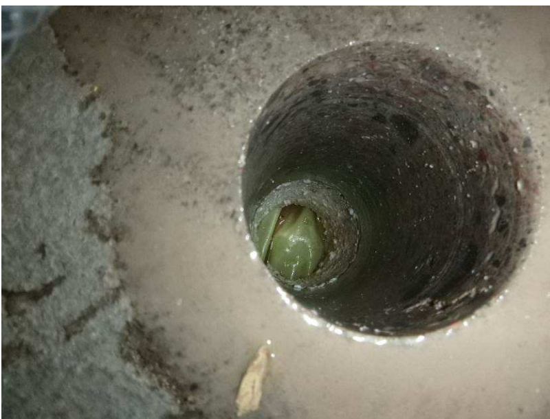
Kuva 5. Alapohjan vedeneristeenä on muovikalvo
