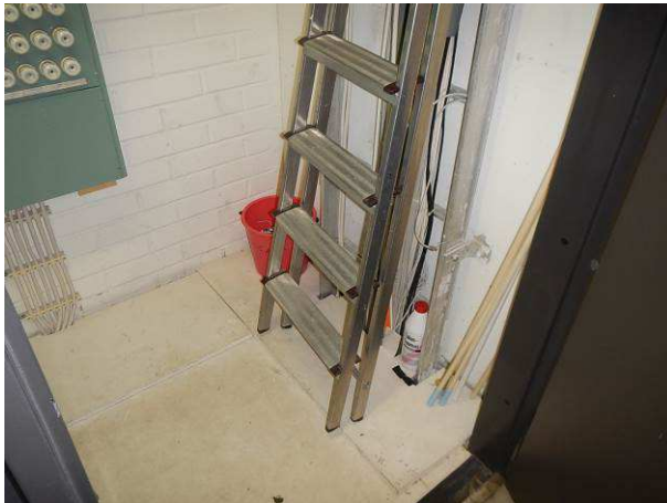
Kuvat 1 ja 2. Asbestia sisältäviä seinä-, katto- ja lattialevytyksiä on sähköjakokeskuksissa.
