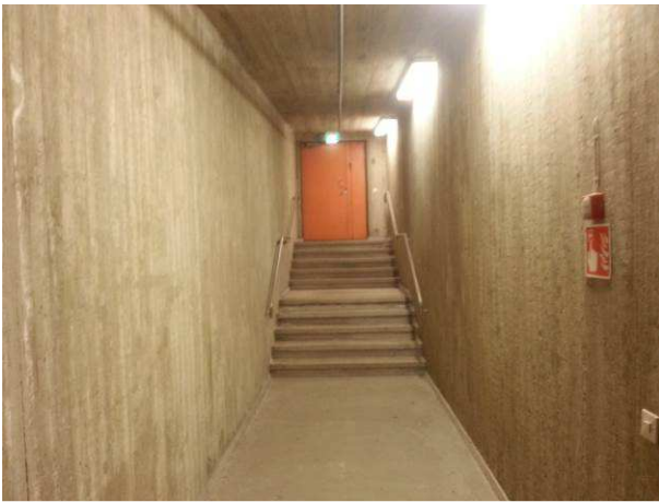
Kuva 1. Palo-ovet sisältävät todennäköisesti asbestia Kuva 2. LVI-laitteiden tiivisteet voivat sisältää asbestia
