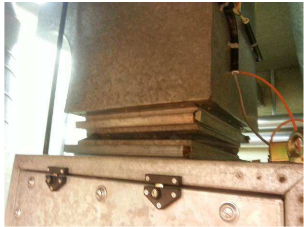
Kuva 1. Palo-ovet sisältävät todennäköisesti asbestia Kuva 2. LVI-laitteiden tiivisteet voivat sisältää asbestia
