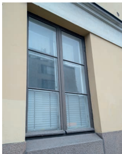
KUVA 200 ▲ Millerin talon alkuperäiset ikkunat ovat kohtuullisessa kunnossa.
