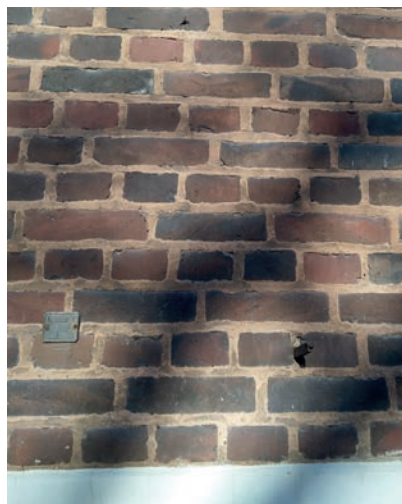
KUVA 188 ▲ Tytökoulun julkisivumuurausta, johon on asennettu villiviinin nousuvaijereiden kiinnikkeet.
