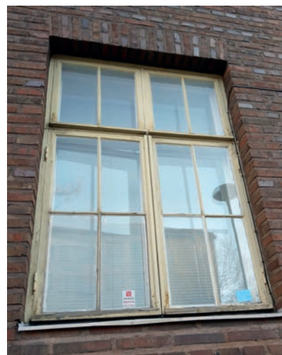
KUVA 201 ▲ Janhusen talon alkuperäisikkunat ovat kunnostettavia
