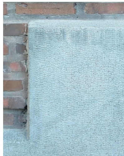
KUVA 192 ▲ Millerin talon sileää rappausta ja graniittisokkeliä.
