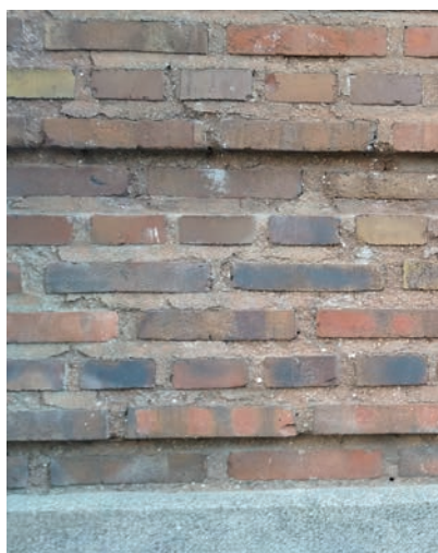
KUVA 190 ▲ Janhusen talon horisontaalinen muuraus poikkeaa muista rakennuksista.
