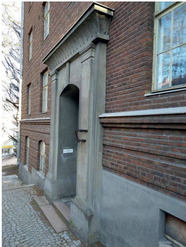
KUVA 175 ▲ Terastirapattu portiikki klassistine aiheineen.
