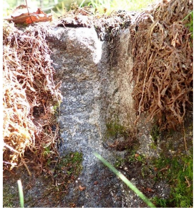
Kallioleikkauksessa on nähtävissä poran jälkiä.
