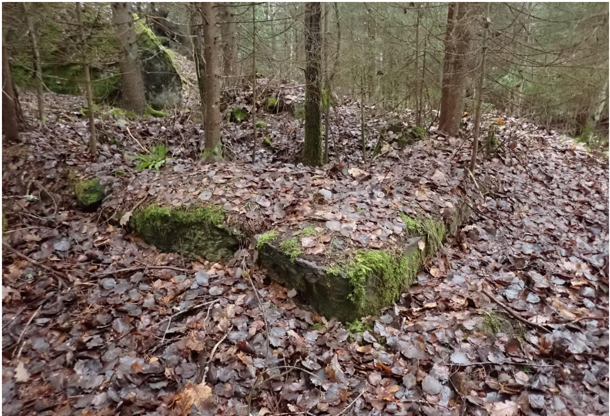
Lohkokivistä tehdyn rakennuksen perustuksen jäännös.
