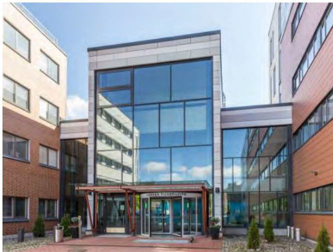
Kuvassa on Tiedepuiston pääsisäänkäynti Niemenkatu 73:ssa. Tiedepuistna on laajennettu uudisosilla viime vuosina.
