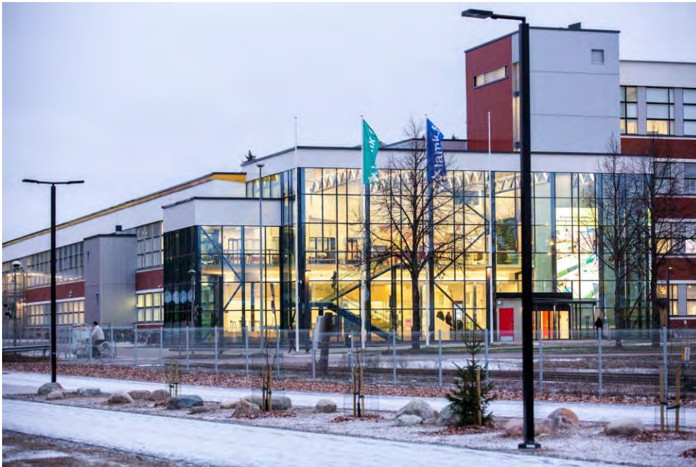
Kuvassa on LAB-LUT kampuksen pääsisäänkäynti Mukkulankatu 19.
