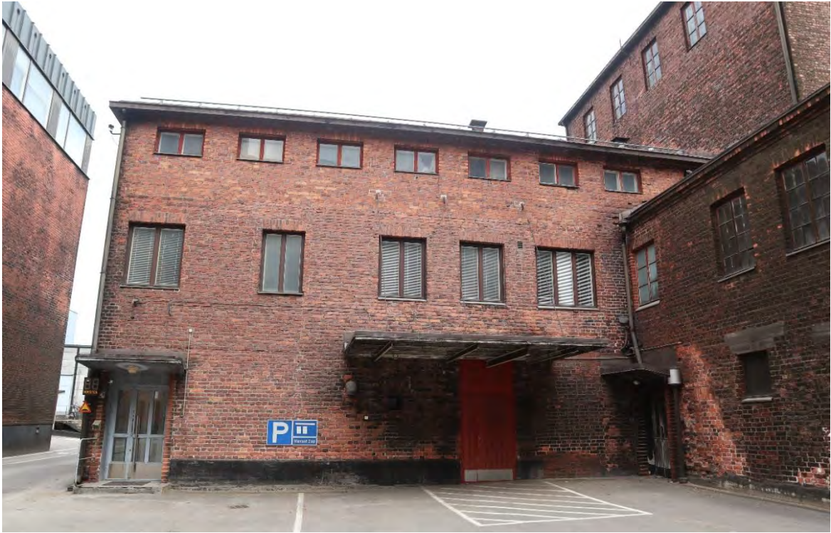
Kuva 97. Hiivatehtaan matalamman osan eteläjulkisivu. Vasemmalla näkyvä ovi johtaa konttorikäytössä olevaan osaan ja oikeanpuolinen, punainen ovi johtaa tekniseen työtilaan.
