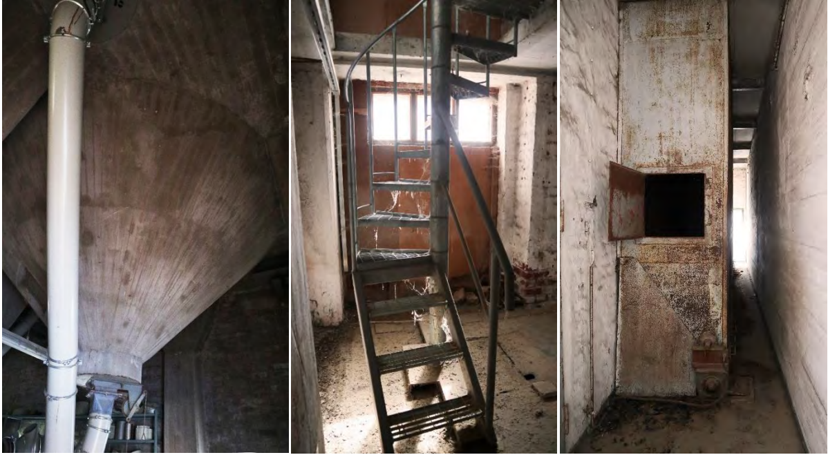
Kuva 142. (oikealla) S2:n alimmassa kerroksessa on näkyvissä silloston alapuoliset betonirakenteet, joissa näkyy lautamuotin valupinta.
