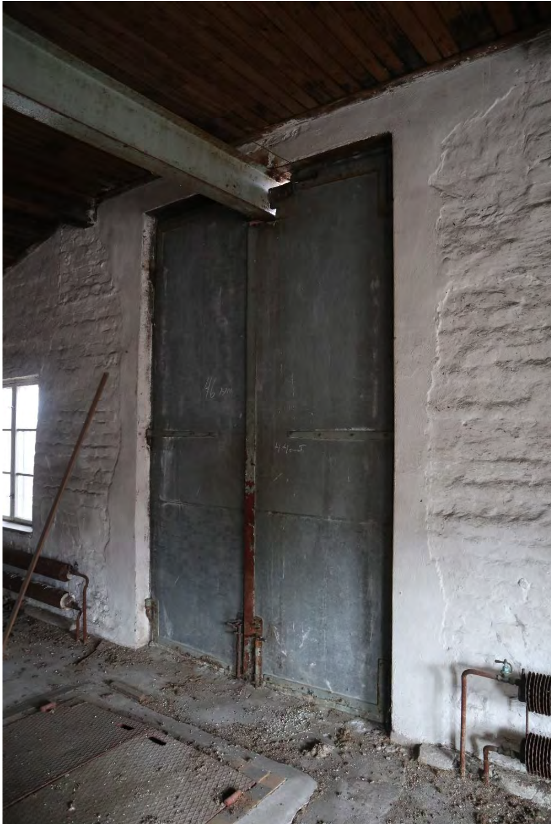
Kuva 123. Vanhan hiivätehtaan pohjoispäädyn ylimmän kerroksen ovi ja nostolaite, jolla on nostettu viljasäkkejä ja kemikaaleja.
