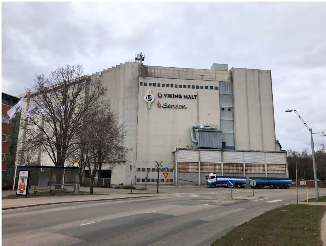
Kuva 28. Tehdasalue hallitsee näkymää Niemenkadulla etelästä saavuttaessa.
