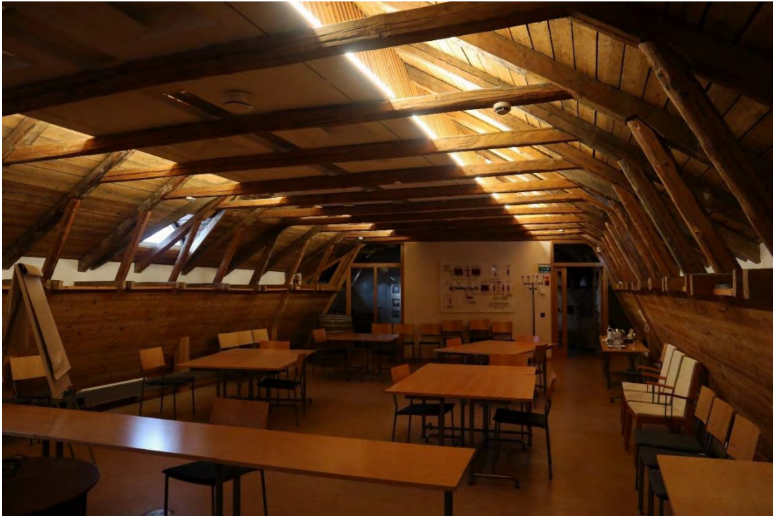
Kuva 77. Ullakolle on toteutettu neuvottelutila, jolle tilallisen karaktäärin antaa näkyville jätetyt kattotuolit sekä luonnonvärinen puupanelointi. Harjan suuntaisesti rakennuksen keskelle sijoitettu kotelointi piilottaa talotekniikan.
