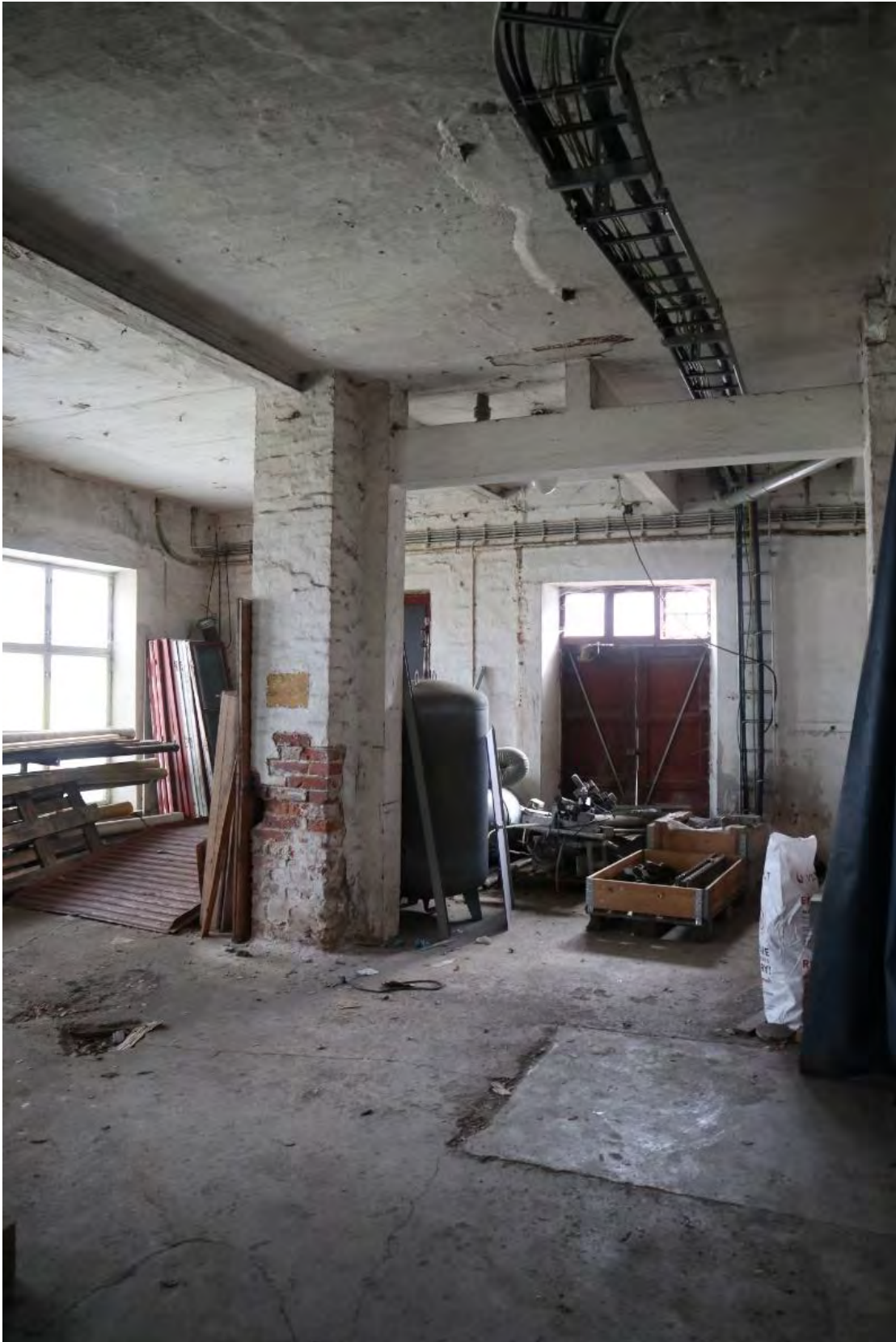
Kuva 106. Vanhan hiivatehtaan alin kerros rakennuksen pohjoispäädystä. Pilarit on toteutettu tiillisinä ja rapattu valkoisiksi, kuten rakennuksen seinäpinnatkin.
