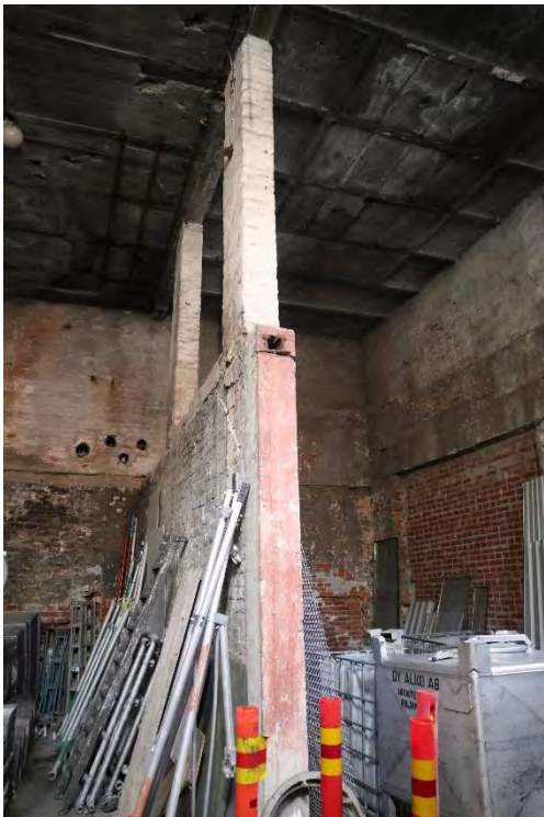
Kuva 101. Kattilahuoneen sisätila. Kuvassa vasemmalla näkyy eteläjulkisivun umpeen muurattu aukko. Tilassa on ilmeisesti ollut kaksi lämpökattilaa, jotka on erotettu toisistaan muuratulla seinällä.
