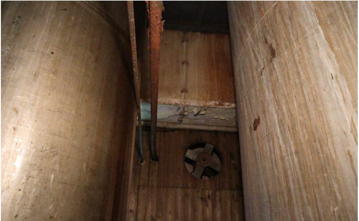
Kuva 115. Toisessa kerroksessa sijaitsevia säiliöitä.
