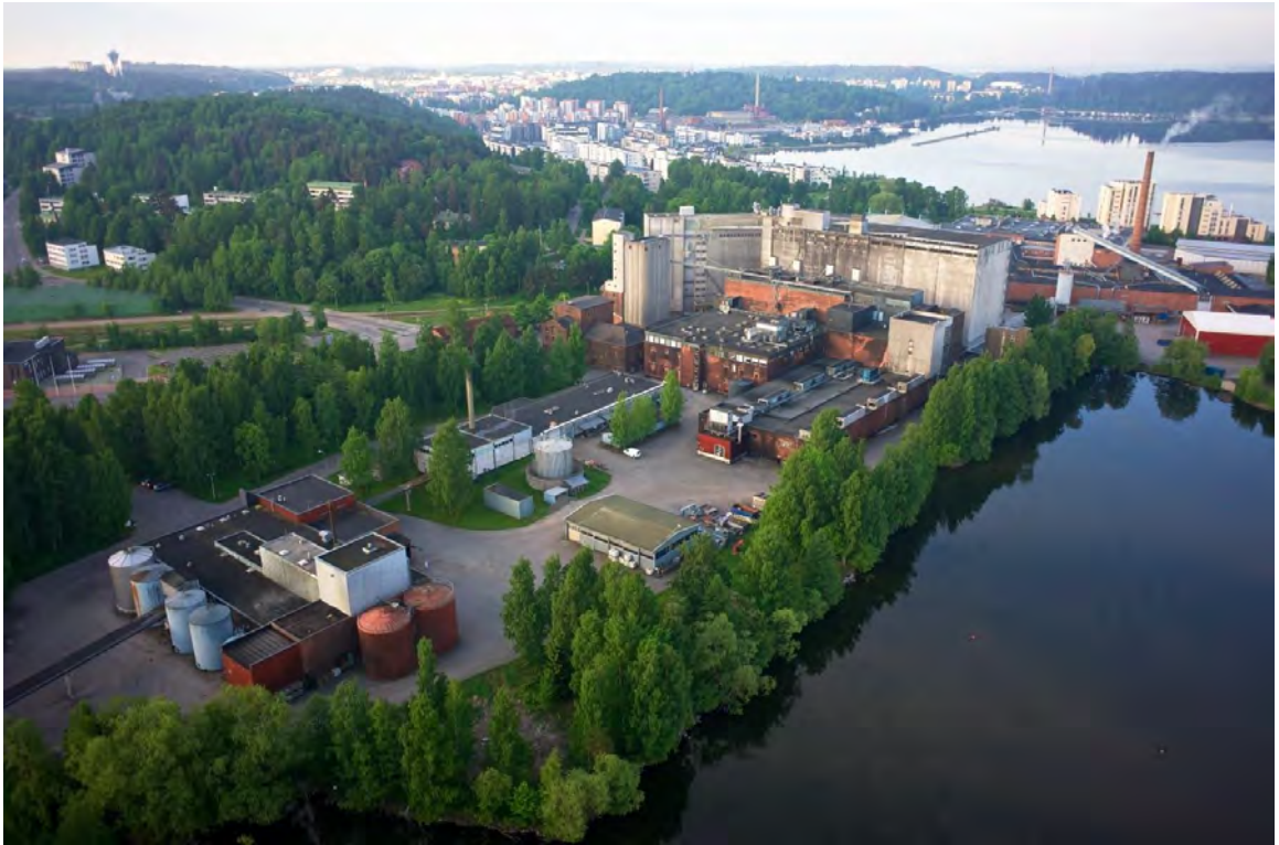
Kuva 14. Ilmakuva luoteesta. Etualalla näkyy hiivatehdas, keskellä taaempänä korjaamorakennus, tiiliset mallastamot rannan tuntumassa ja betoninen, korkea siilokokonaisuus taaimpana. Energialaitoksen rakennuksia ei ole vielä rakennettu. Tarkemmin inventoitavat kohtaat sijoittuvat Niemenkadun varrelle: sylinterimallisista siloista tunnistettava S2 ja sen edustalla tiilinen vanha hiivatehdas. Lähde: Tehtaan arkisto.
