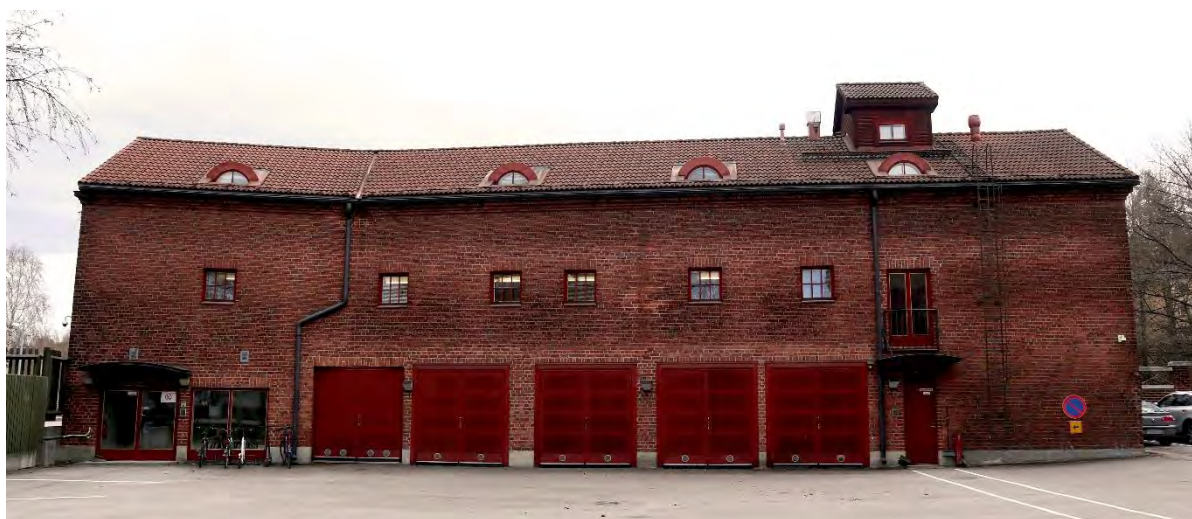
Kuva 68. Makasiinirakennuksen länsijulkisivussa on suuret oviaukot autotalleihin. Rakennuksen pääsisäänkäynti uusine ovi- ja ikkuna-aukkoineen näkyvät kuvassa vasemmalla. Lisäksi rakennuksessa on ranskalainen parveke, joka on luultavasti toteutettu alkuperäistä ikkuna-aukkoa suurentamalla. Rakennuksen kattolyhty on ulkovuoraukseltaan puuta. Katolle on asennettu huoltoa palvelevia tikkaita sekä ilmanvaihdon hormeja.
