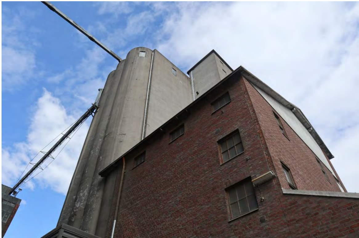
Kuva 137. Edustalla S1 ja sen takana oikealla S2:n siilosto. Vanhempi S1 on tiilipintainen, joskin sen itäpään yläosa on pintamateriaaliltaan valkoista aaltopeltiä.
