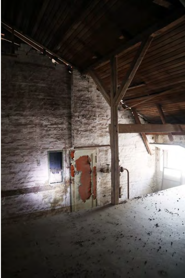
Kuva 147. (vasemmalla) Kuvassa S1:n ylimmän kerroksen kaakkoiskulmaus, jossa on kaksi tasoa, joiden korkeusero on noin metri. Rakennuksessa on puinen kattoristikko ja aluslaudoitus vesikaton alla. Ovi on sijoitettu ikkuna-aukon eteen.
