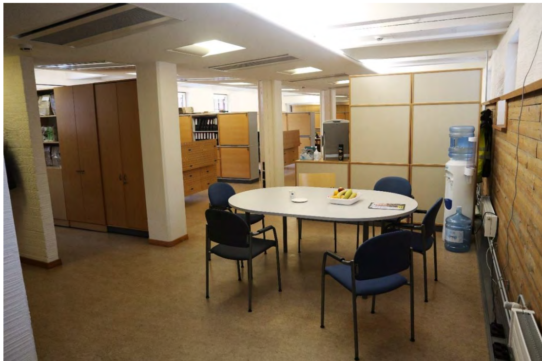
Kuva 76. Toisen kerroksen avokonttoritila. Rakennuksen tiiliseinä on sisältä rapattu ja puupaneloitu. Välipohjan alle sijoitetun tekniikan vuoksi tilan keskellä olevaa alakattoa on laskettu. Tilan betonipilaristo on osittain maalattu ja osin pinnoitettu laudoituksella. Lattiamateriaalina on käytetty vaaleanruskeaa muovimattoa.
