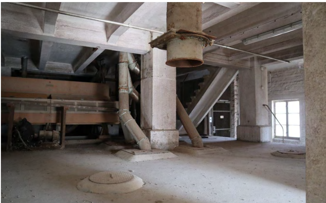
Kuva 150. S1:n ylin taso. Kuvassa näkyy pohjoisjulkisivun ikkuna, S2:een johtavat portaat sekä käytöstä poistettu hissi.
