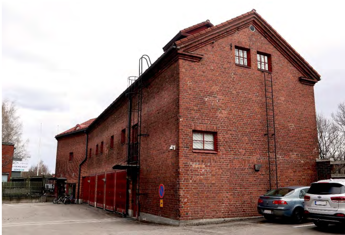
Kuva 73. Makasiinirakennuksen etelä- ja länsijulkisivut tehdasalueelta nähtynä. Rakennuksen päädyssä on kaksi ullakkoikkunaa. Lisäksi julkisivusta on luettavissa mahdollisia aukotusmuutoksia. Rakennuksen länsijulkisivussa näkyy autotallitiloja palvelleet punaiset ovet sekä myöhemmin lisätyt tikkaat.
