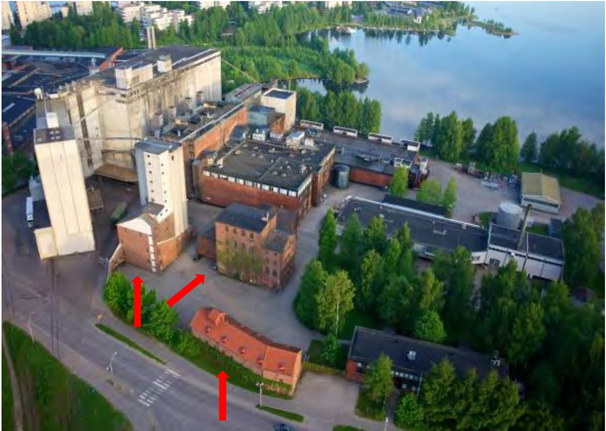
Kuva 9. Polttimon alue ilmakuvassa. Inventointialueelle sijoittuvat, yleiskaavaehdotuksessa paikallisesti merkittäviksi osoitetut (LaRY) rakennukset merkitty punaisella nuolella: Suomen Hiivan vanha tehdasrakennus (keskellä), vanhat siilot/varastorakennus sekä makasiini/toimistorakennus.
