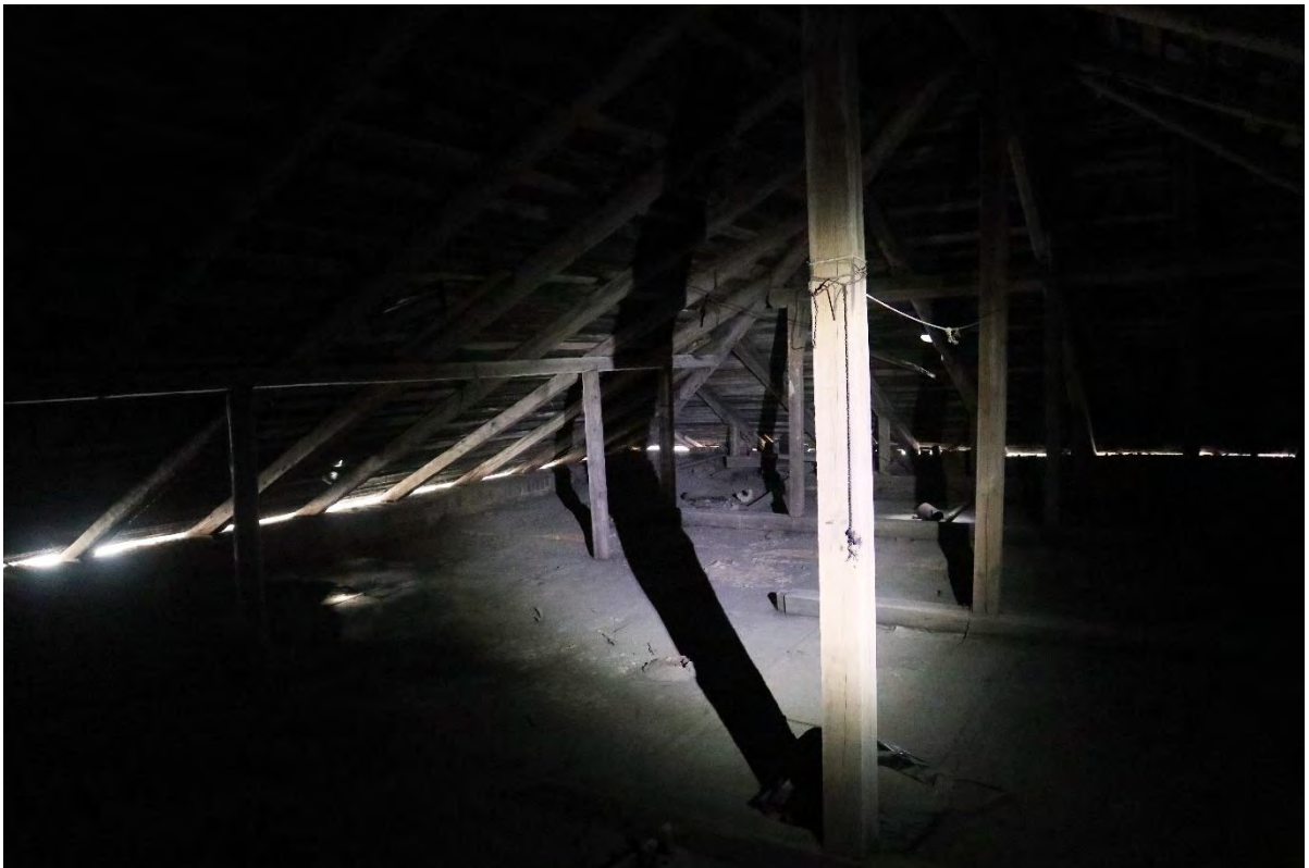
Kuva 103. Kattilahuoneen yläpohja ja kattoristikkorakenne.
