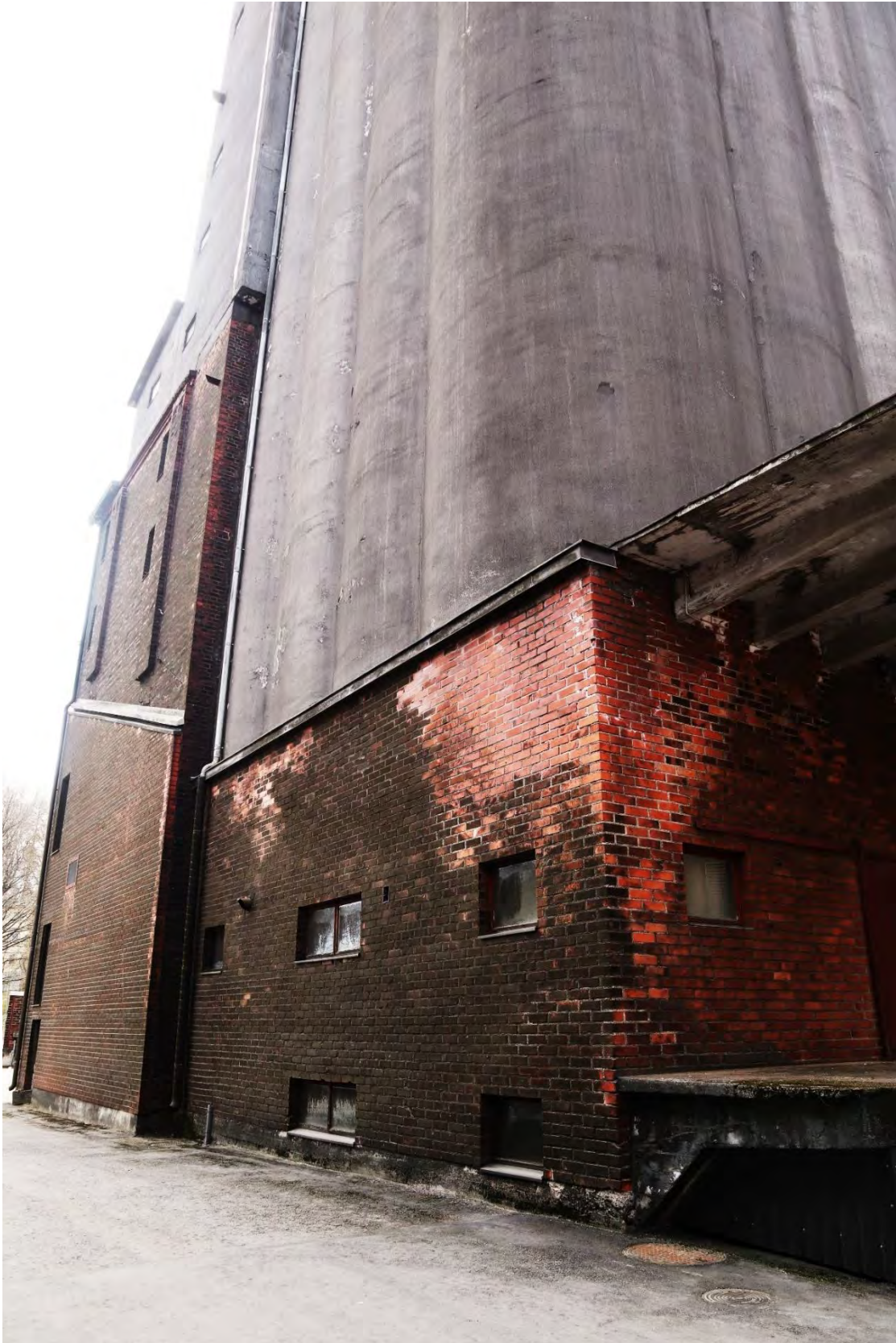
Kuva 139. S1:n ja S2:n pohjoisjulkisivu. Julkisivussa näkyy viitteitä vanhasta mallastamosta, joka on yhdistänyt siilon vanhaan hiivatehtaaseen.
