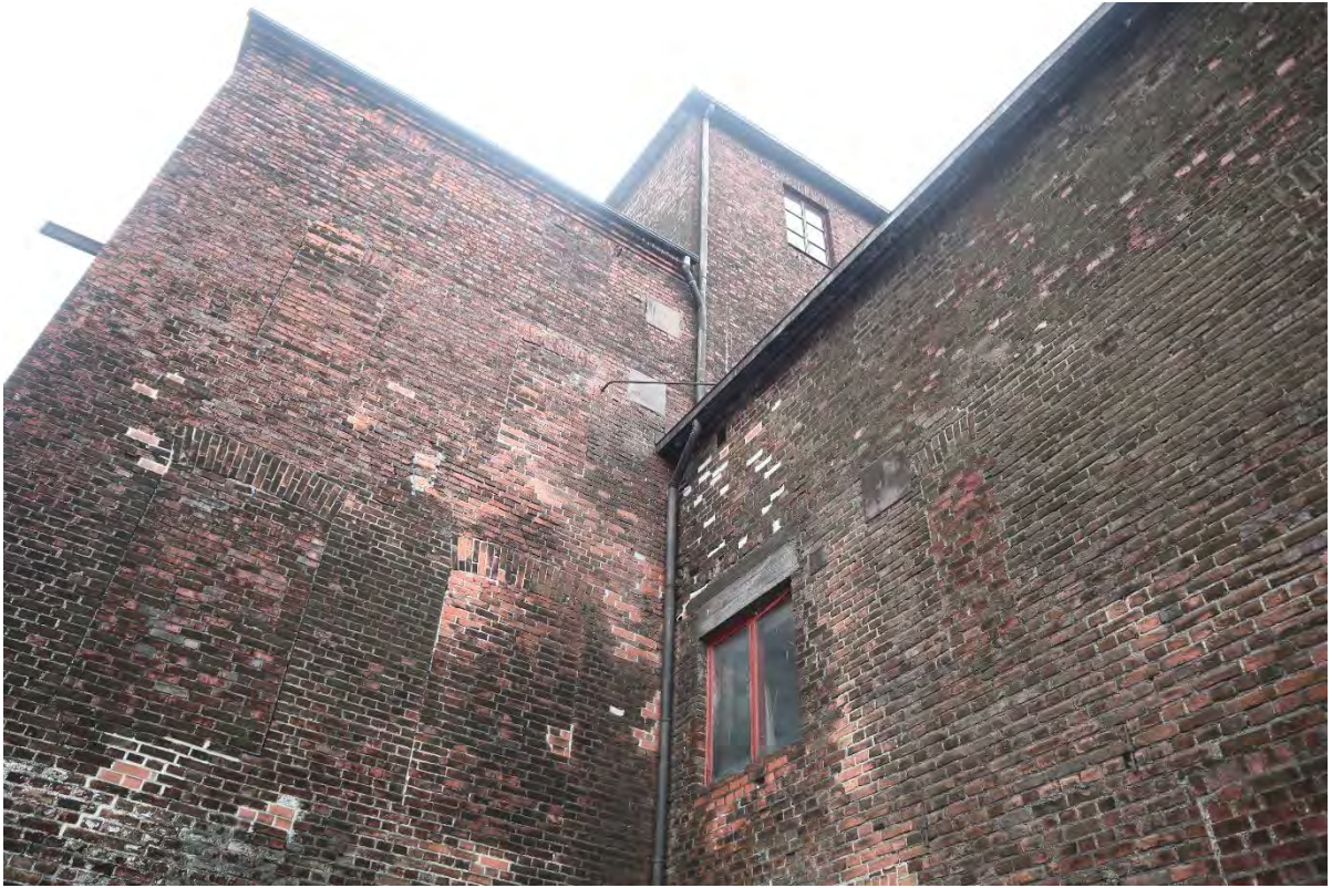
Kuva 100. Vanhan hiivastehtaan pohjois- ja länsijulkisivuja. Massa porrastuu kolmeen osaan. Pohjoisimman osan länsijulkisivun ikkuna-aukot on muurattu umpeen. Samoin muutoksia näkyy matalamman osan pohjoisjulkisivulla.
