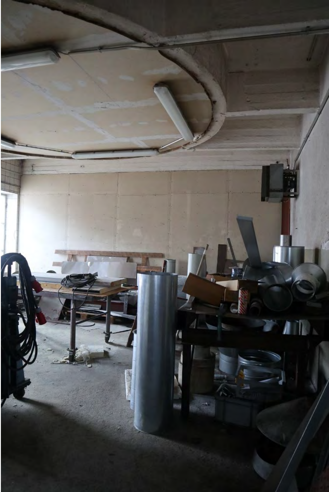
Kuva 107. Rakennuksen alimmassa kerroksessa länsisivustalla oleva tila on varastoinnin ja teknisen työskentelyn tilana. Välipohjassa näkyy pyöreä aukko, joka on laitettu umpeen.
