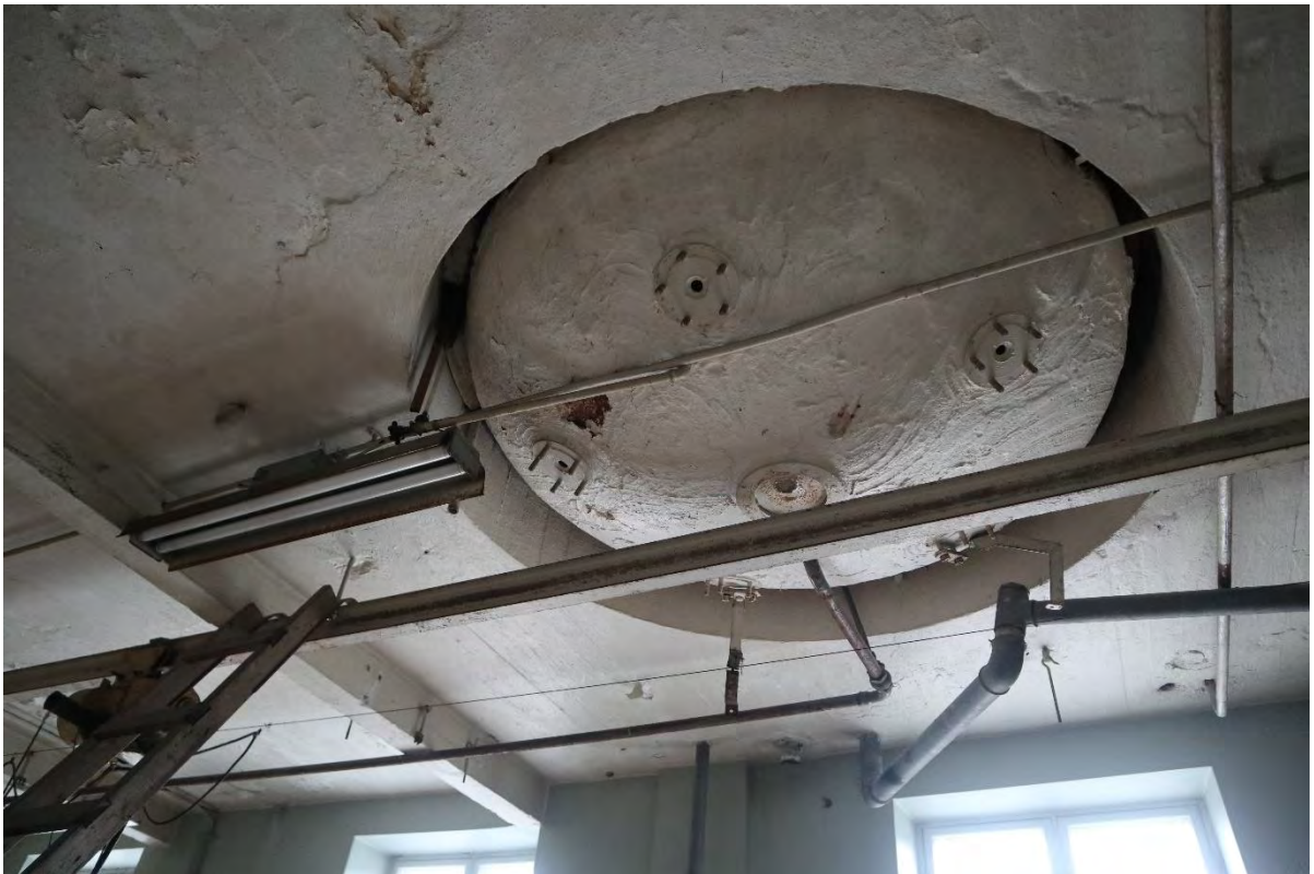
Kuva 121. Hiivatehtaan kolmannen kerroksen yläpuolinen välipohja.
