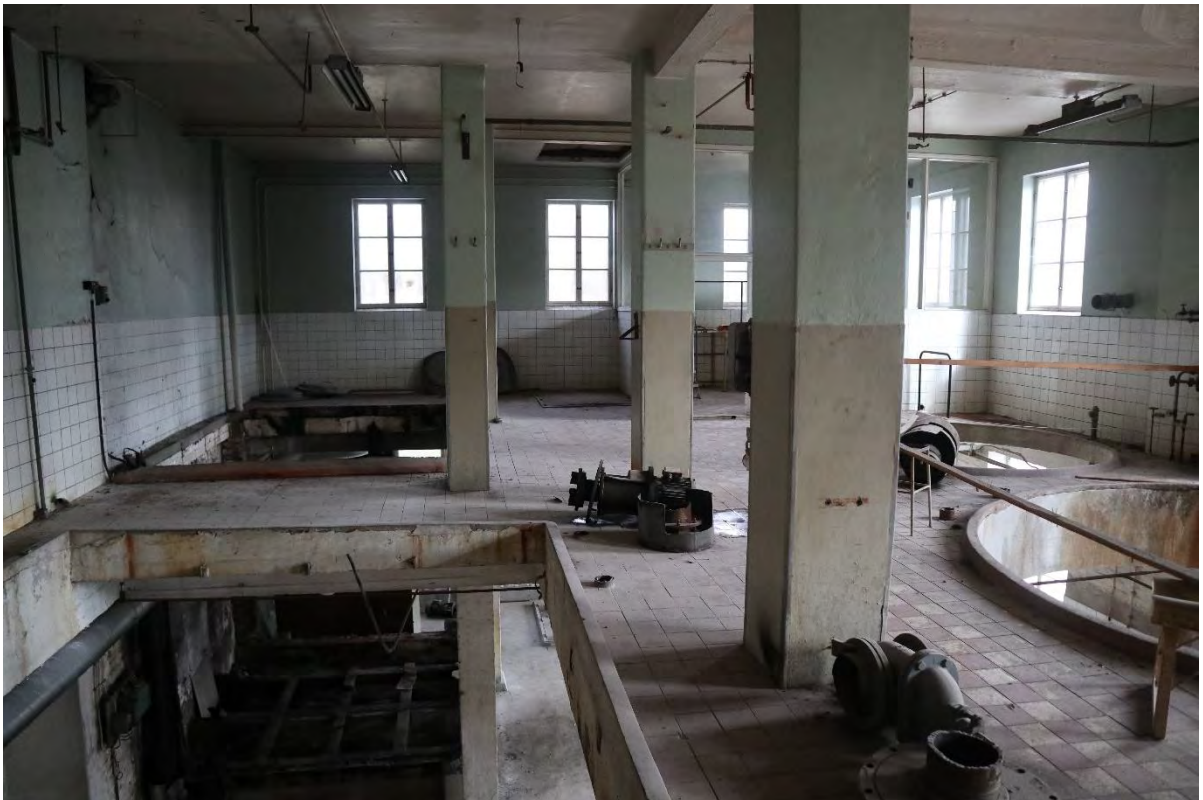
Kuva 119. Hiivatehtaan kolmas kerros. Oikealla näkyy pyöreiden sillojen paikat ja etualalla kaksi suorakulmaista aukkoa välipohjassa.
