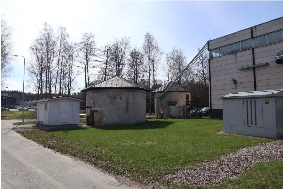
Kuva 18. Jätevesipumppaamo "Olavinlinna" korjaamorakennuksen nurkalla.
