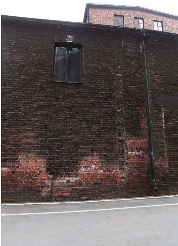
Kuva 92. (vasemmalla) Kattilahuoneen eteläjulkisivussa näkyy tummentumaa tiilipinnassa sekä viitteitä vanhoista, umpeen muuratuista aukotuksista. Lisäksi julkisivussa näkyy pystysuuntainen, seinästä indikoiva muuraus.
