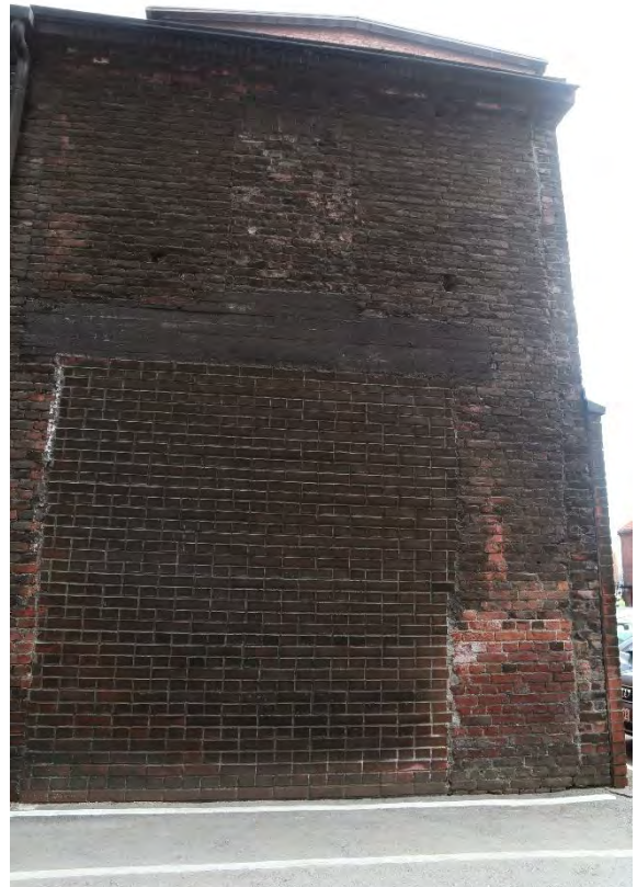
Kuva 92. (vasemmalla) Kattilahuoneen eteläjulkisivussa näkyy tummentumaa tiilipinnassa sekä viitteitä vanhoista, umpeen muuratuista aukotuksista. Lisäksi julkisivussa näkyy pystysuuntainen, seinästä indikoiva muuraus.
