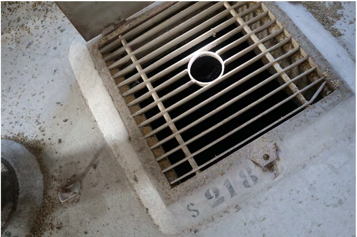
Kuva 154. Siilon numero S218 huoltoluukku avattuna.
