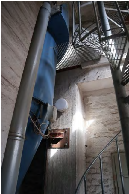
Kuva 145. (vasemmalla) S1:n välitasossa näkyy sininen säiliö sekä kerrokset yhdistävät kierreportaat ja huoltotasot.
