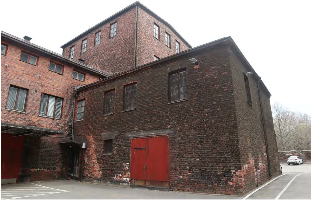
Kuva 94. Kattilahuoneen ja hiivatehtaan länsijulkisivua. Julkisivussa näkyy aukotusmuutoksia: punainen pariovi sekä sen viereinen ikkuna eivät ole alkuperäisiä aukkoja.
