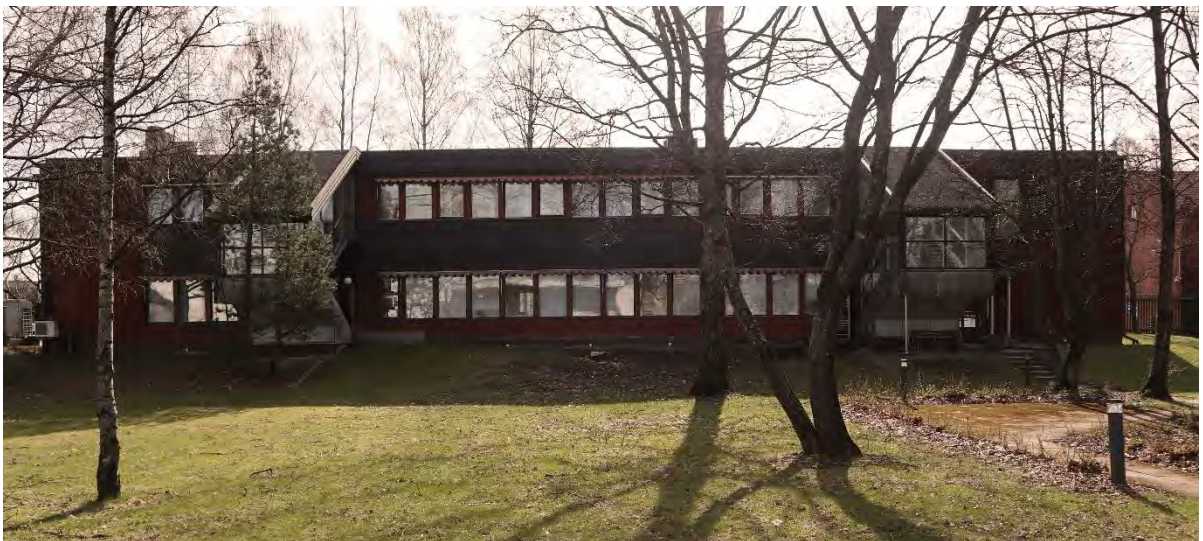
Kuva 13. Polttimon pääkonttori on valmistunut 1960-luvulla ja sitä on korotettu toisella kerroksella 1980-luvulla.
