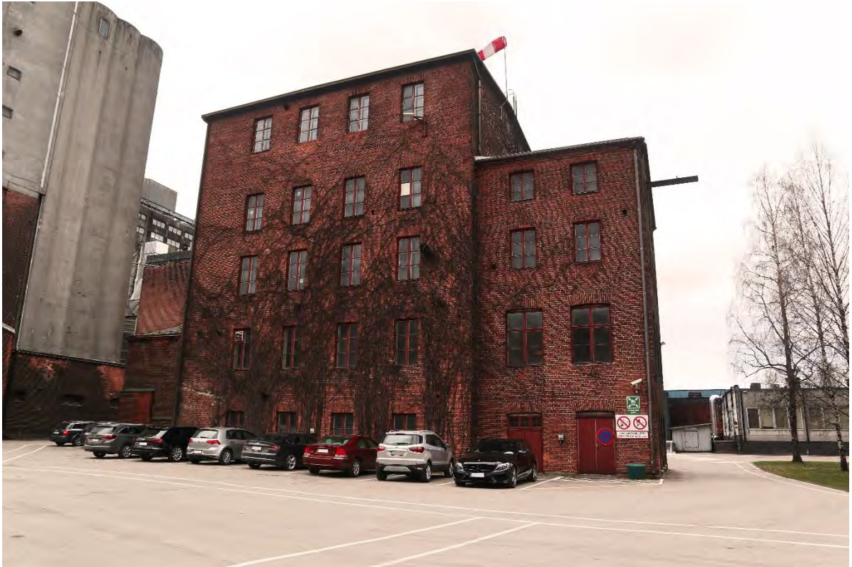
Kuva 90. Vanhan hiivatehtaan itäjulkisivu. Taustalla oikealla näkyy sillo S2 ja vasemmalla matala korjaamorakennus.
