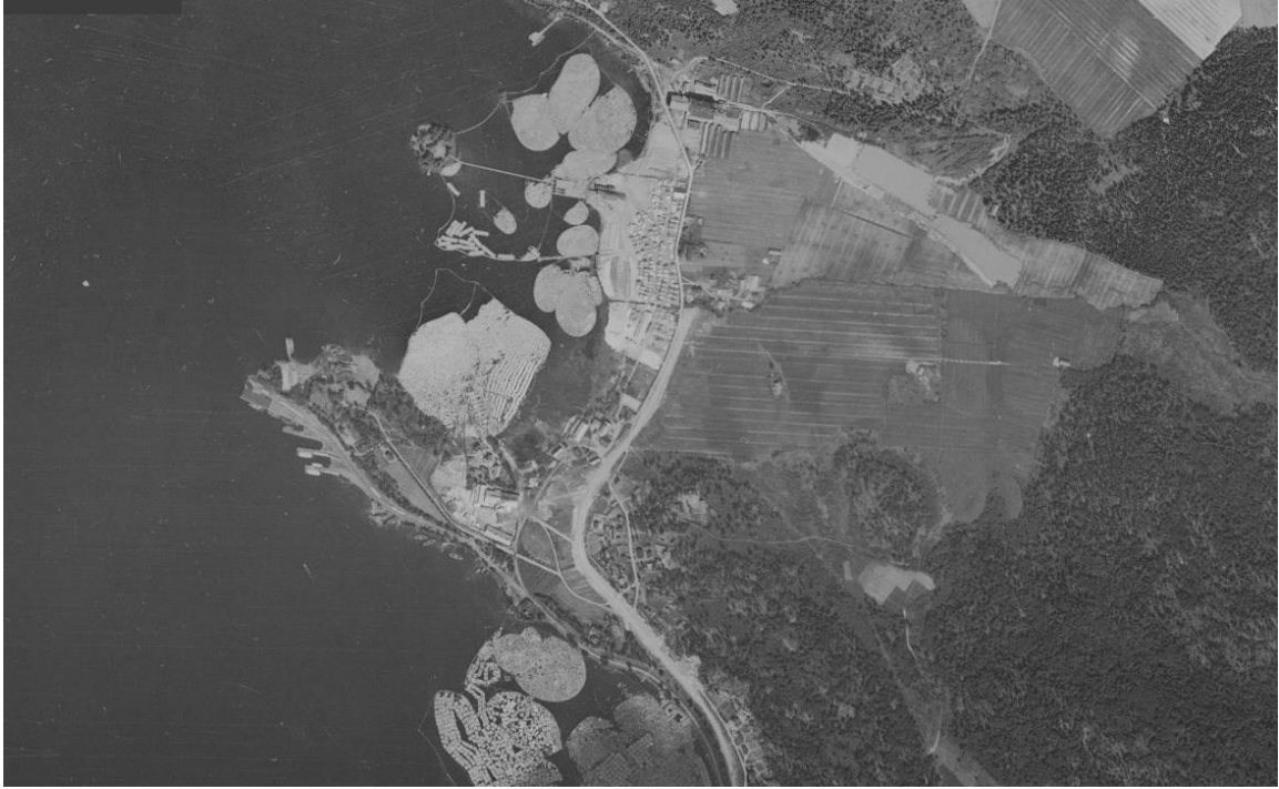
Kuva 54. Ilmakuva vuodelta 1933. Kuvassa aluetta leimaa sahateollisuuteen liittyvät tukkilautat ja lautatapulit. Lähde: Maanmittauslaitos. Paikkatietoikkuna.
