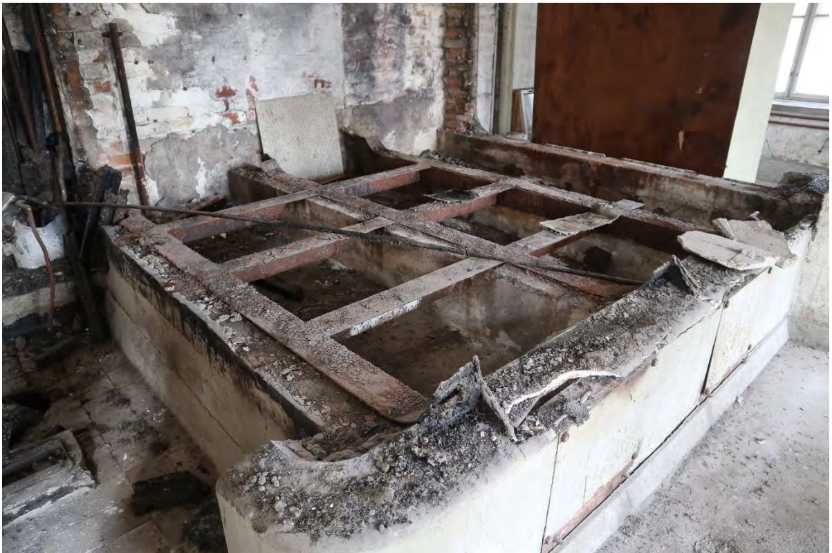
Kuva 112. Toisen kerroksen peitettyjä aukkoja.
