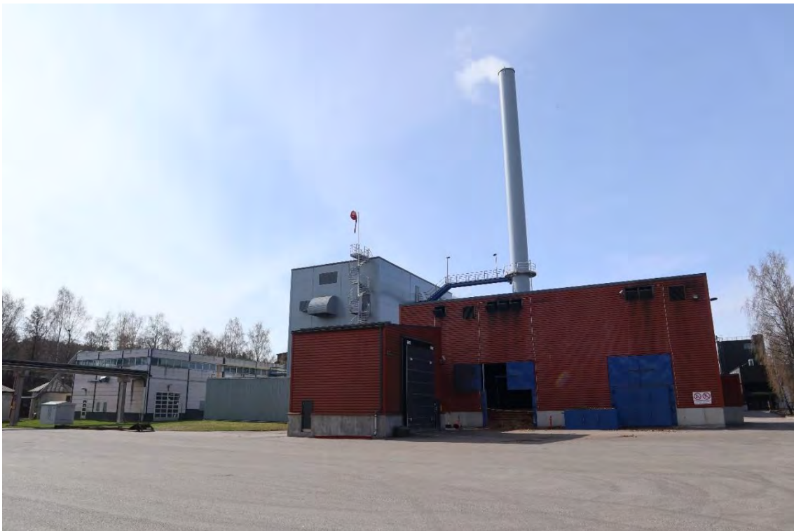
Kuva 17. Lämpölaitos on rakennettu 2000-luvulla. Taustalla näkyy korjaamorakennusta.
