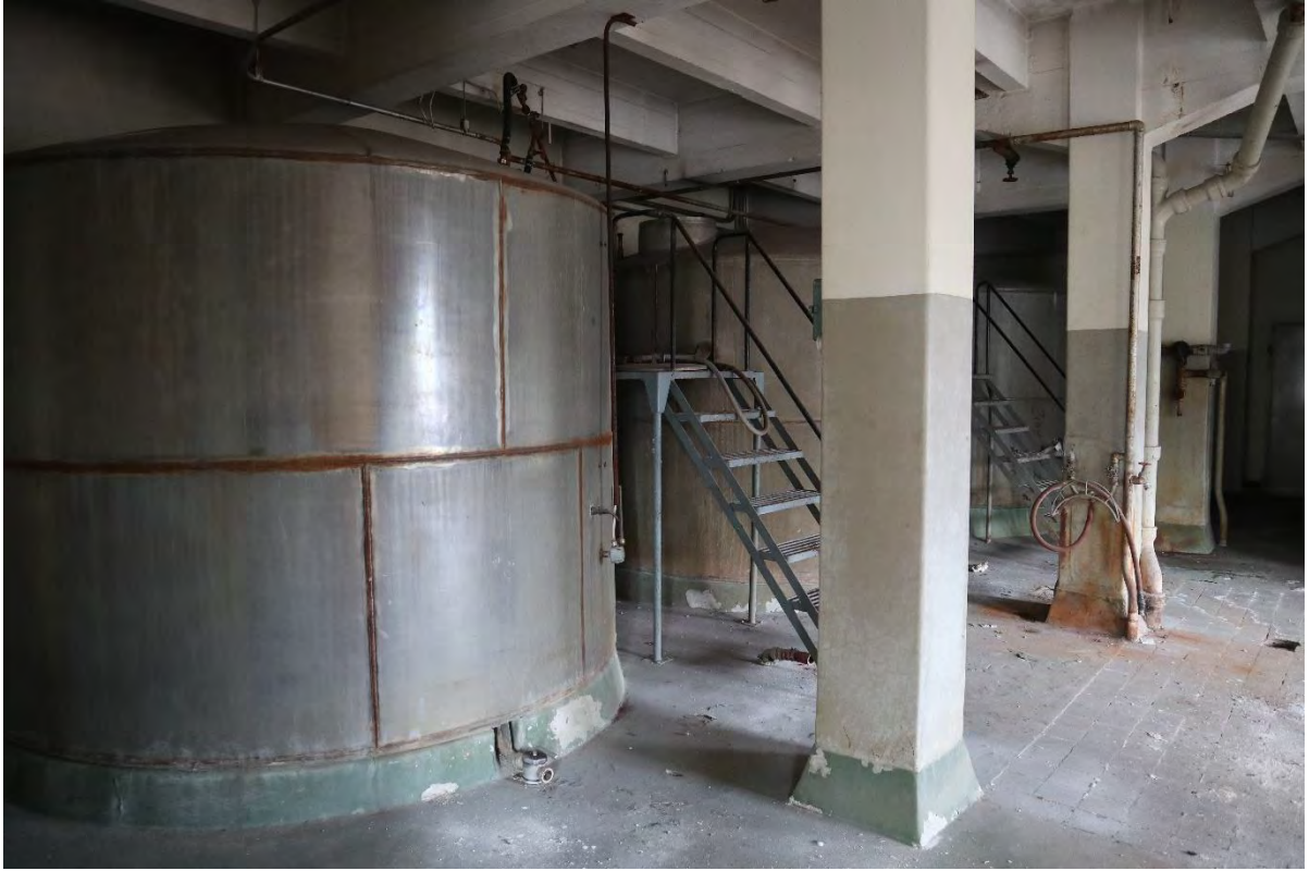
Kuva 122. Hiivatehtaan neljäs kerros. Katossa näkyvät betoniset kattopalkistot.
