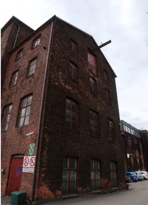
Kuva 98. (vasemmalla) Vanhan hiivatehtaan pohjoisjulkisivua. Ylimmässä kerroksessa on nostovinssi.
