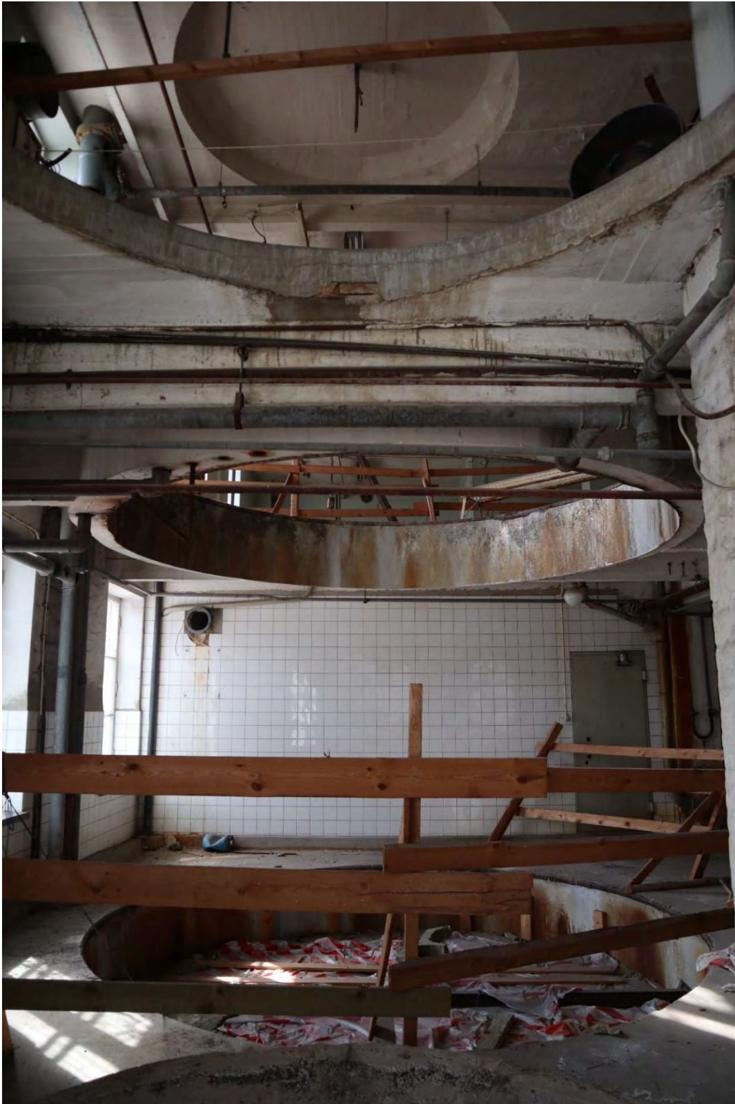
Kuva 114. Kuva hiivatehtaan toisesta kerroksesta. Aukoissa on ollut siilot. Kuvassa näkyy villoilla umpeen laitettu aukko sekä edustalla toinen, umpeen valettu aukko. Kolmannessa kerroksessa näkyy kaksi avonaista aukkoa sekä yläpohjan syvennys.
