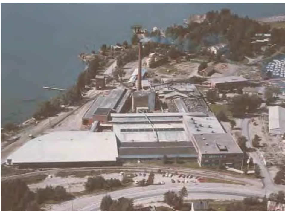
Ilmakuva Asko-Upo Oy:n Fennia vaneri-tehtaasta 1970. (Tehtaan arkisto)
