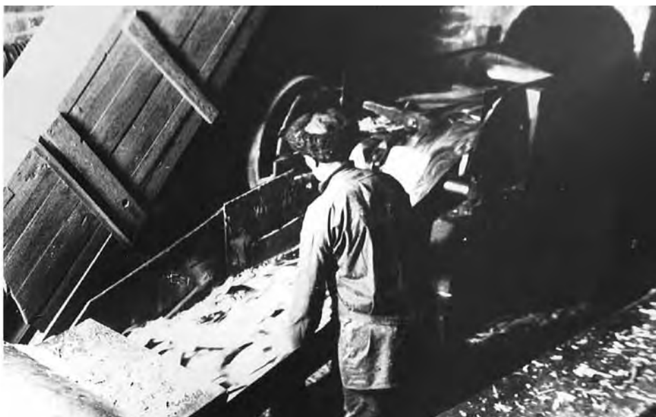
Hakkurilinjan pää 1930-luvulla. (Tehtaan arkisto)
