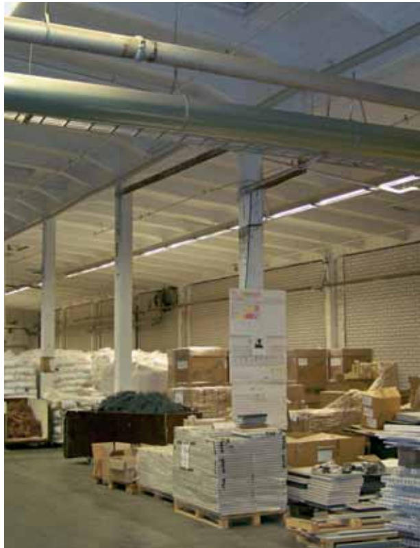
Laajennusosan kauniita betonirakenteita vuodelta 1949. (JLL 2010).
