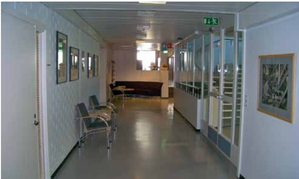
Liittymä laajennukseen. (JL 2010)
