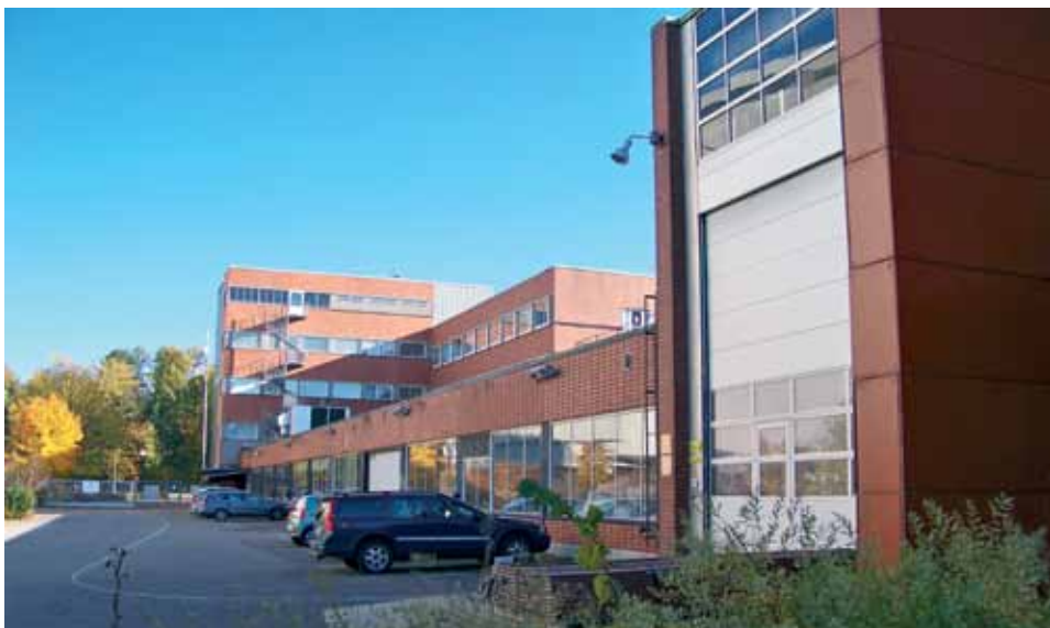
Pohjoispuolen julkisivua. (JL 2010)
