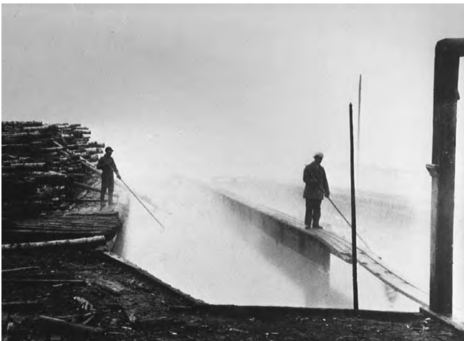
Hautoma-allas 1950-luvulla. (Tehtaan arkisto)
