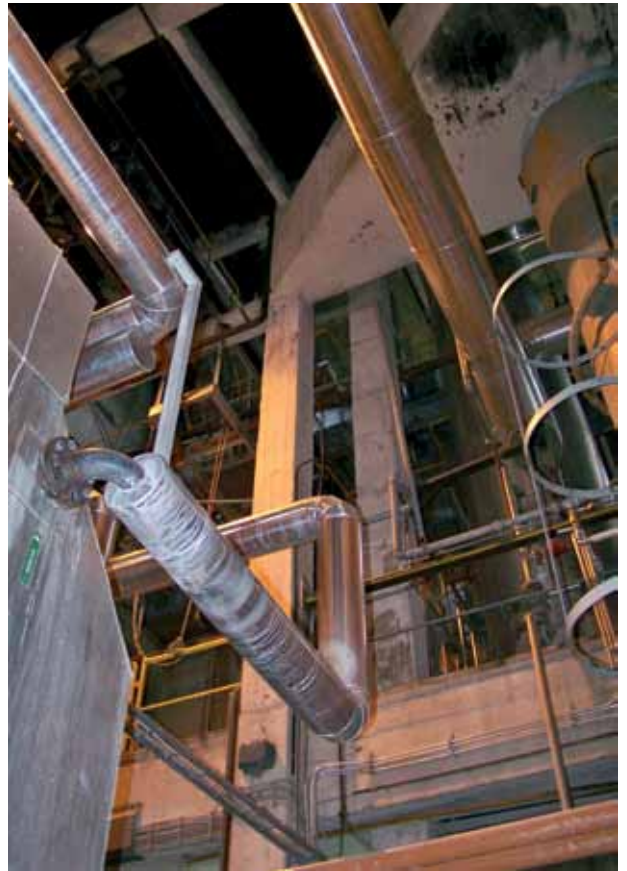
Kattilahuoneen korkeutta (JL 2010).
