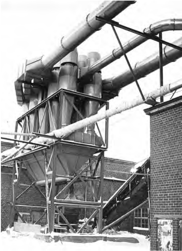
Sykloonilaitos purukopin katolla (Tehtaan arkisto).
