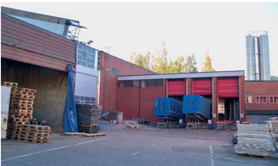
Uudempi hakkuritila tehtaan pohjoisivulla. (JL 2010)
