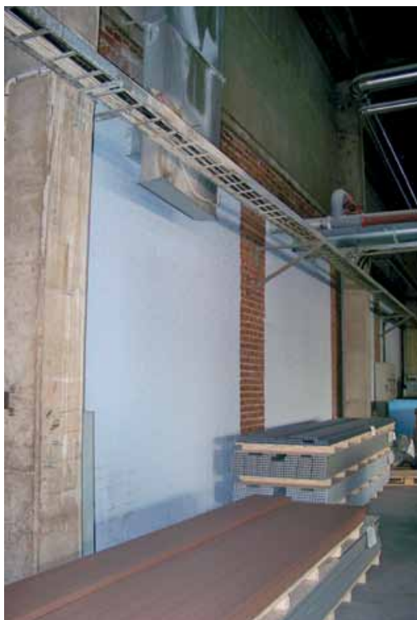
Uuden ja vanhan hallin väliseinä (JL 2010).
