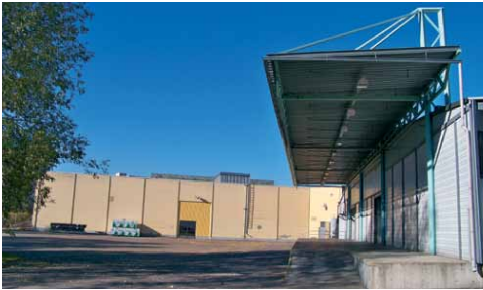
Lastauskatos 1994 ja jalostusosaston itäseinä. (JL 2010)
