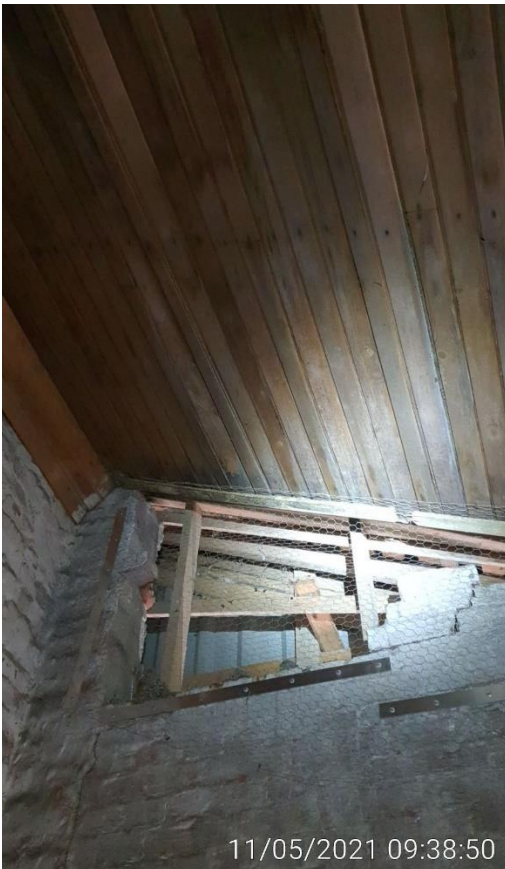
KUVA 48. Siilo 1 -rakennuksen vesikatto
