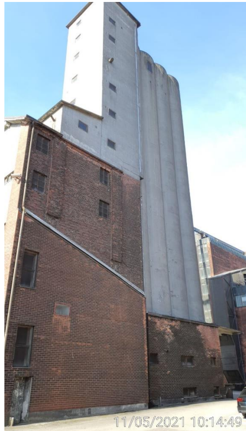
KUVA 2. Rakennuksien julkisivu pohjoissivu.
