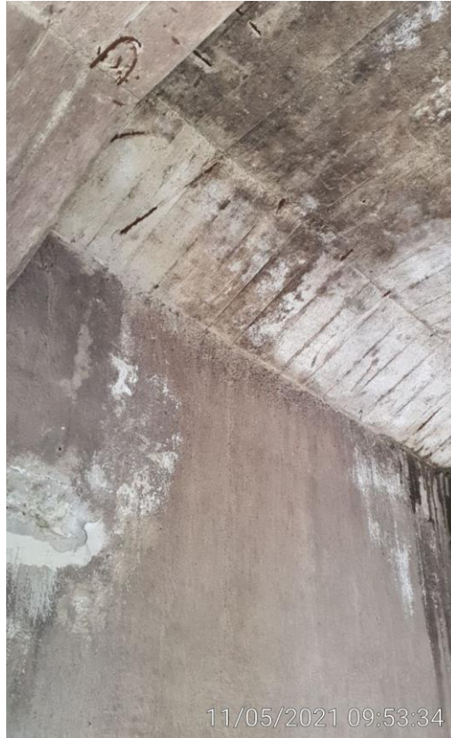
KUVA 35. Siilo 2 -rak. ylimmän tason yläpohjan alapinta
