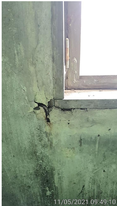
KUVA 23. Siilo 2 -rakennuksen porrastornin ikkuna-aukko
