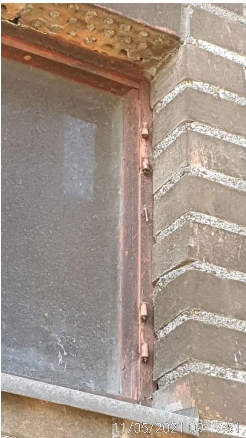
KUVA 44. Siilo 2 -rakennuksen ikkuna
