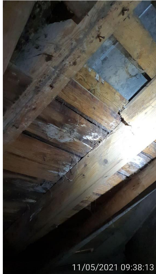
KUVA 47. Siilo 1 -rakennuksen vesikatto
