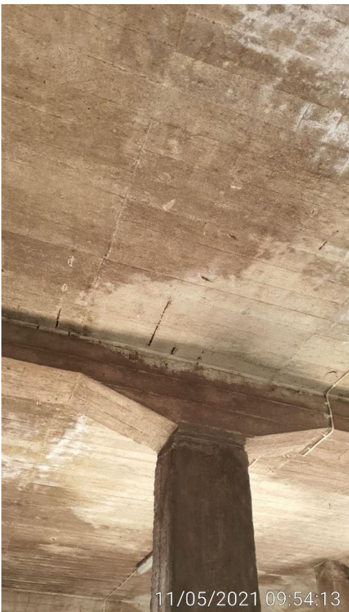
KUVA 40. Siilo 2 -rak. ylimmän tason yläpohja
