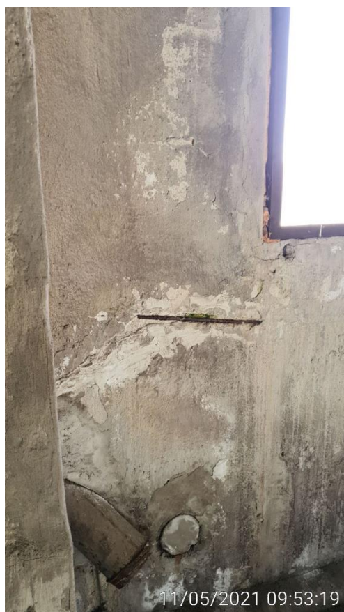
KUVA 33. Siilo 2 -rak. ylimmän tason julkisivun sisäpinta
