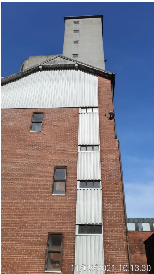
KUVA 3. Rakennuksien julkisivu itäsiivu.
