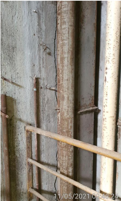
KUVA 36. Siilo 2 -rak. porrastornin ja sillojen välinen seinä
