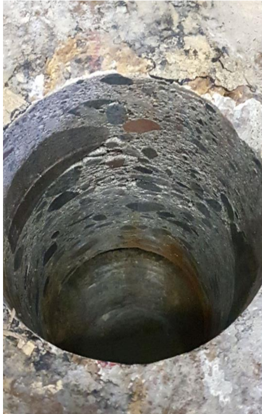
KUVA 6. Siilo 2 -rakennuksen pohjaveden korkeuden tutkiminen
