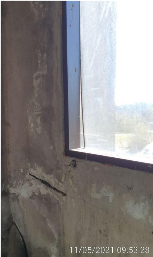
KUVA 28. Siilo 2 -rak. ylimmän tason uusittu ikkuna-aukko
