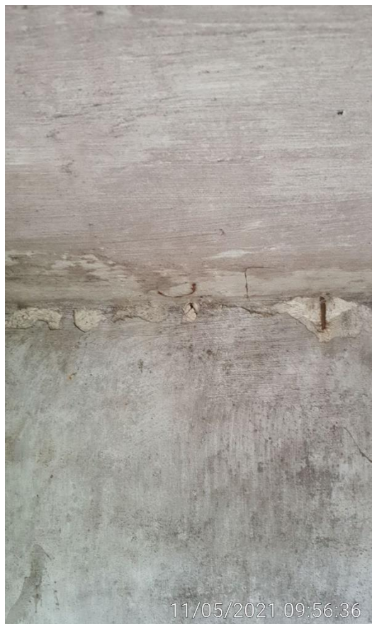
KUVA 41. Siilo 2 -rak. ylimmän tason yläpohja
