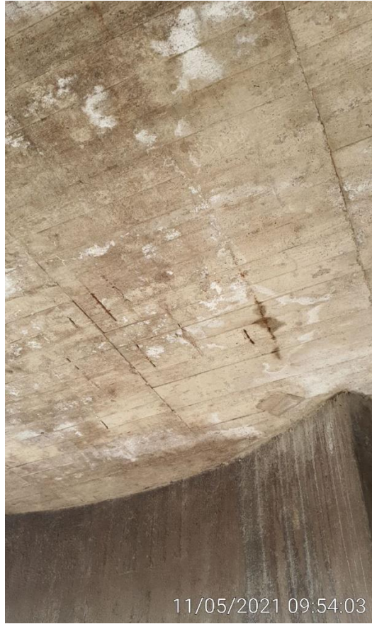
KUVA 39. Siilo 2 -rak. ylimmän tason yläpohja
