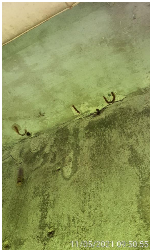
KUVA 31. Siilo 2 -rak. porrastornin julkisivun sisäpinta
