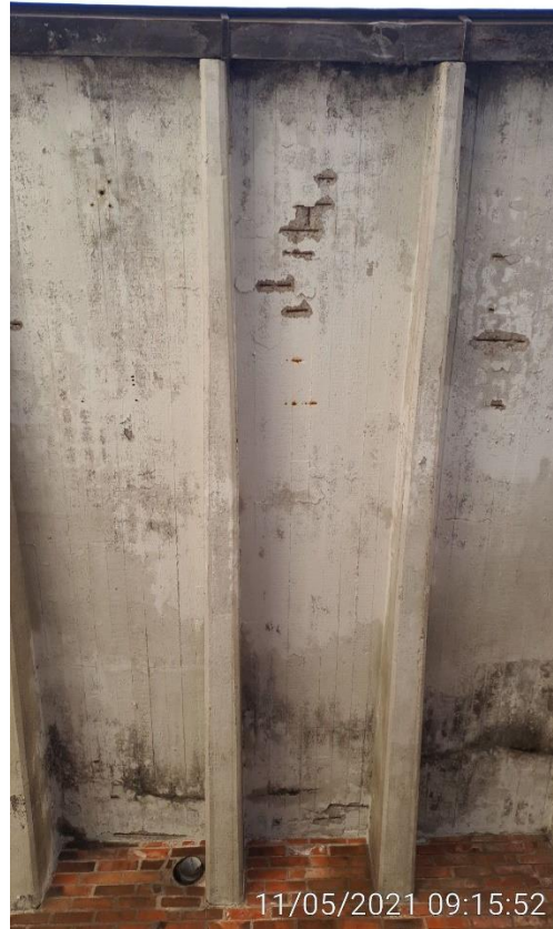
KUVA 43. Siilo 2 -rakennuksen lastauslaiturin katos
