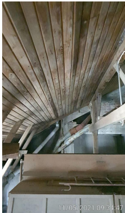
KUVA 45. Siilo 1 -rakennuksen vesikatto
