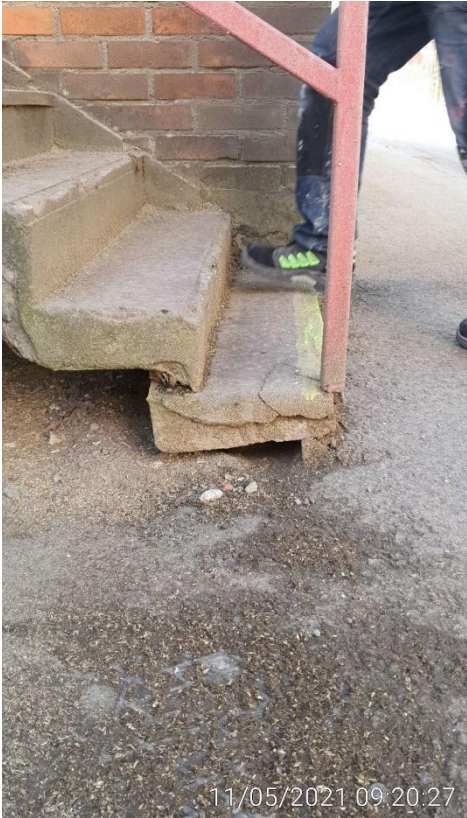
KUVA 5. Siilo 2 -rakennuksen lastauslaiturin portaat
