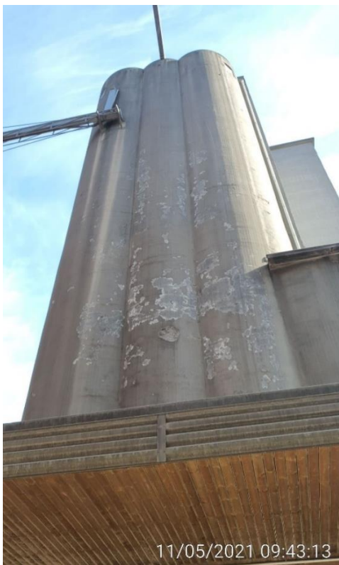
KUVA 10. Siilo 2 -rakennuksen julkisivu
