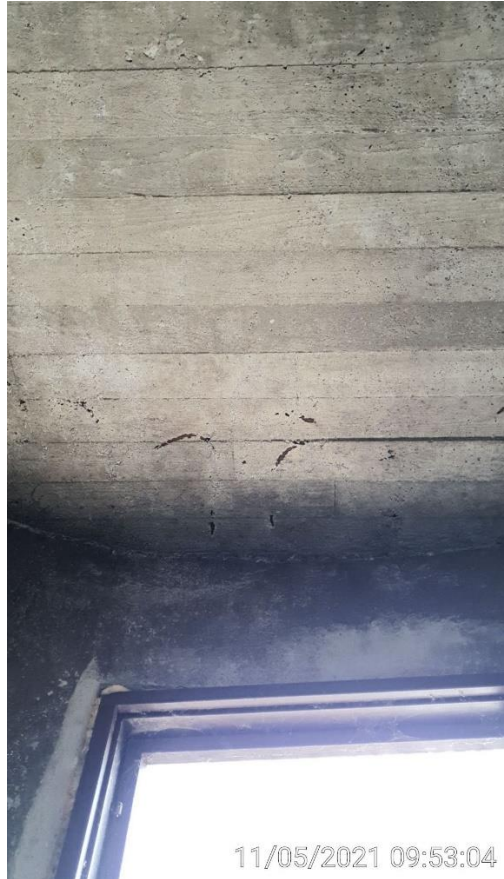
KUVA 33. Siilo 2 -rak. porrastornin julkisivun sisäpinta
