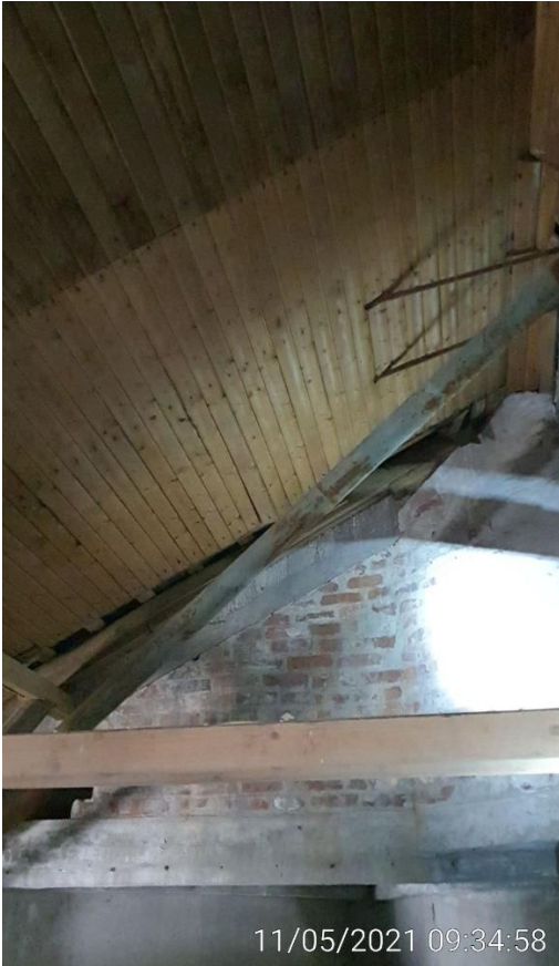
KUVA 46. Siilo 1 -rakennuksen vesikatto
