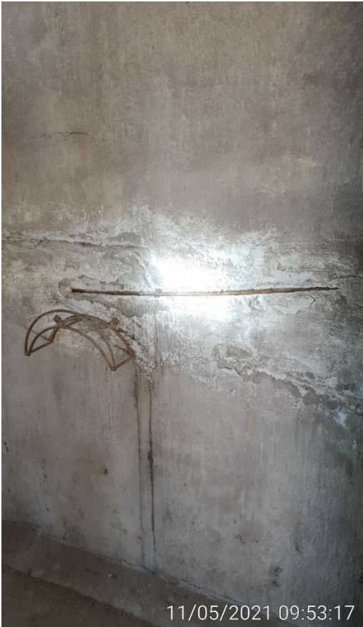
KUVA 34. Siilo 2 -rak. ylimmän tason julkisivun sisäpinta
