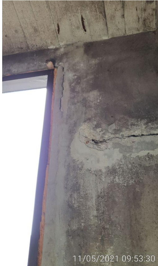
KUVA 29. Siilo 2 -rak. ylimmän tason uusittu ikkuna-aukko
