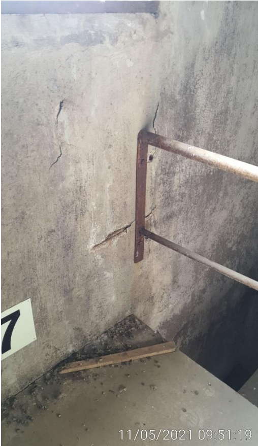
KUVA 32. Siilo 2 -rak. porrastornin julkisivun sisäpinta
