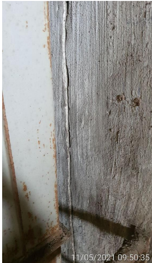
KUVA 37. Siilo 2 -rak. porrastornin ja sillojen välinen seinä
