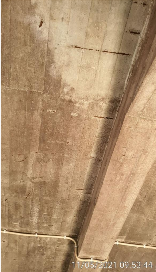
KUVA 38. Siilo 2 -rak. ylimmän tason yläpohja
