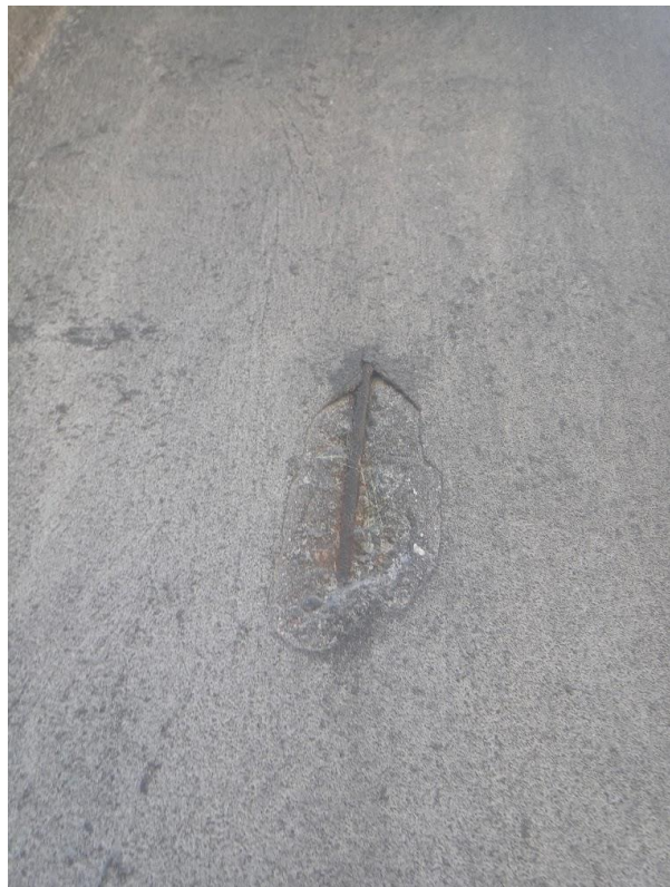
KUVA 15. Siilo 2 -rakennuksen julkisivuvaurio.
