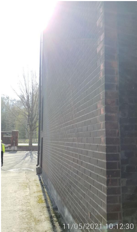
KUVA 1. Silo 2 -rakennuksen julkisivu pohjoissivu
