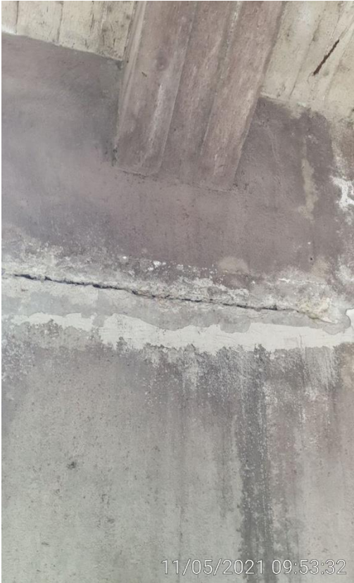
KUVA 34. Siilo 2 -rak. ylimmän tason julkisivun sisäpinta
