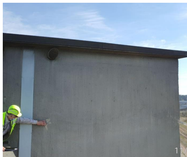
KUVA 11. Siilo 2 -rakennuksen porrastornin julkisivu.
