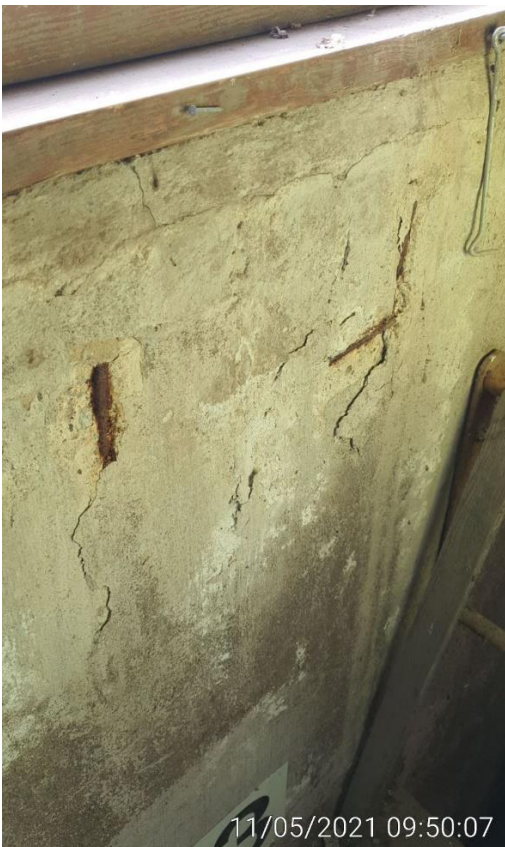
KUVA 30. Siilo 2 -rak. porrastornin julkisivun sisäpinta
