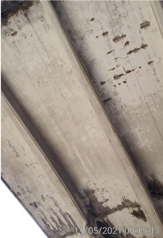
KUVA 42. Siilo 2 rakennuksen lastauslaiturin katos
