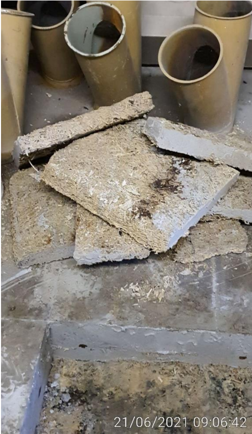
KUVA 50. Siilo 2 -rakennuksen alapohjan toja-levy
