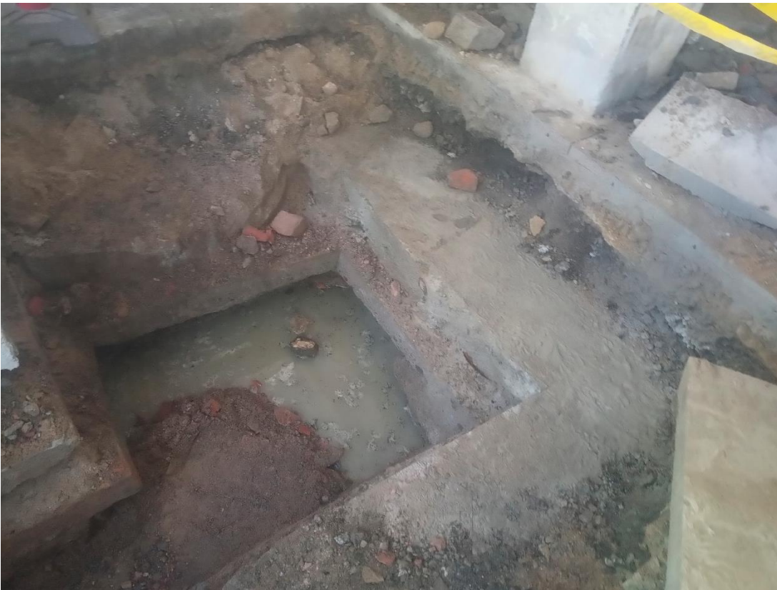
KUVA 30. Alapohjan pohjaveden korkeuden tutkiminen.
