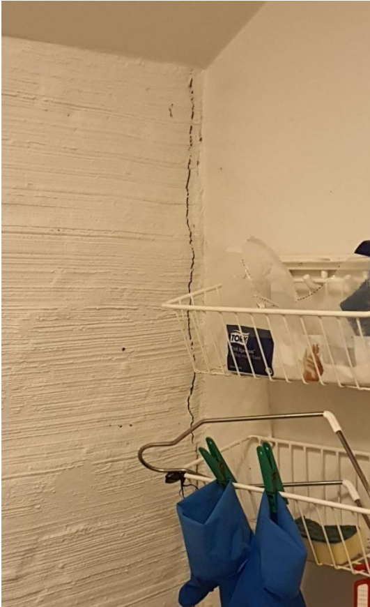
KUVA 12. Siivouskomeron pitkittäishalkeama.
