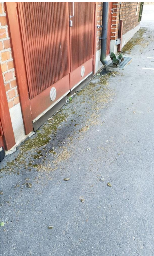
KUVA 10. Asfaltoinnin painuminen.
