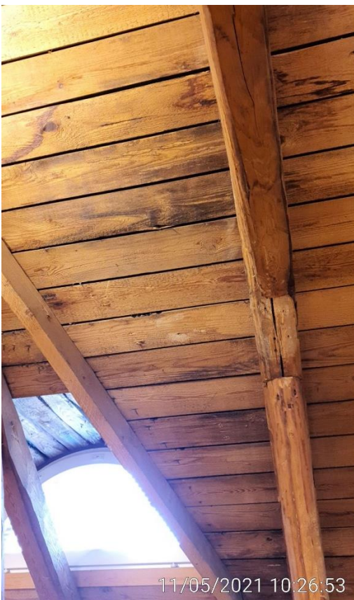
KUVA 7. Vesikaton yläpohjan umpilaudoitus.
