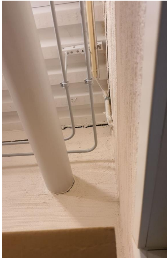
KUVA 13. Varaston poikittaishalkeama.
