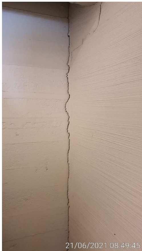
KUVA 15. Varaston pitkittäishalkeama.
