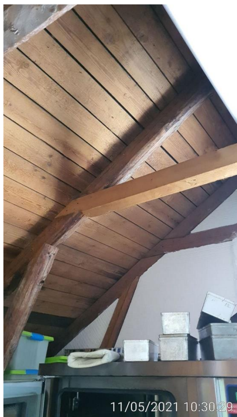
KUVA 8. Vesikaton yläpohjan umpilaudoitus.
