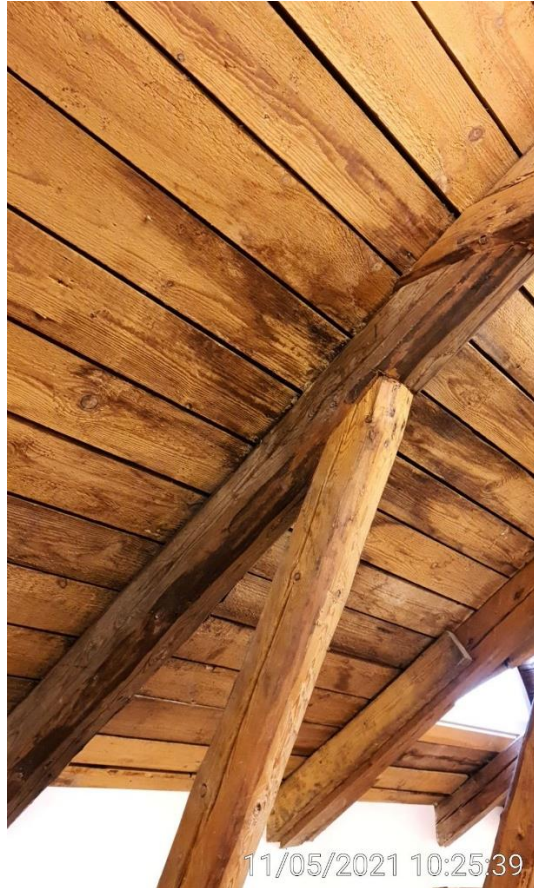
KUVA 6. Vesikaton yläpohjan umpilaudoitus.
