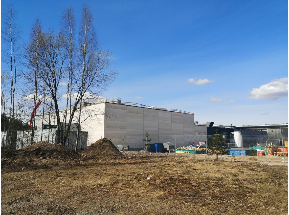
Wipakin laajennusosa rakenteilla huhtikuussa 2021.
