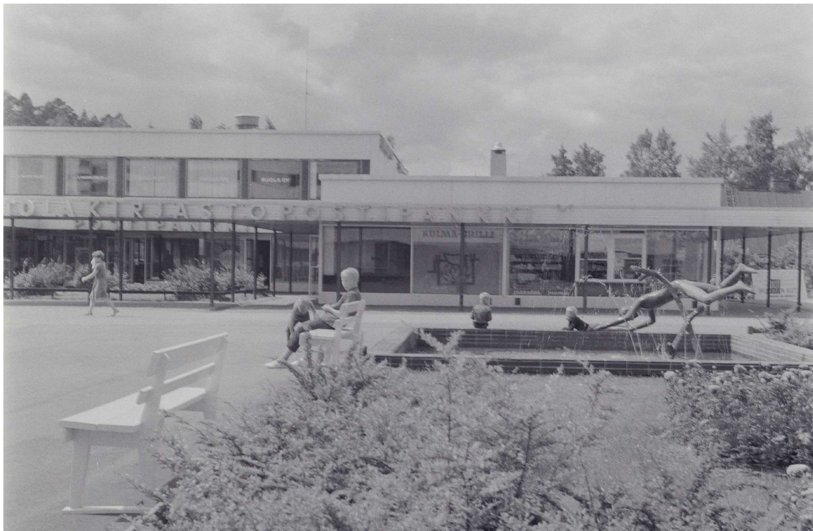
Ruolan ostoskeskus. Kuva vuodelta 1967. Työväen arkiston valokuvakokoelmat. Toisessa kerroksessa Rakennustoimisto Ruola Oy:n toimistotila.
