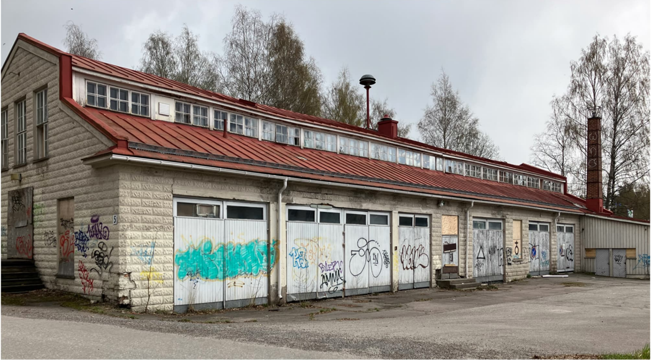
Kuva 6. Näkymä idän puoleiselle rakennukselle Möysänkadulta.
