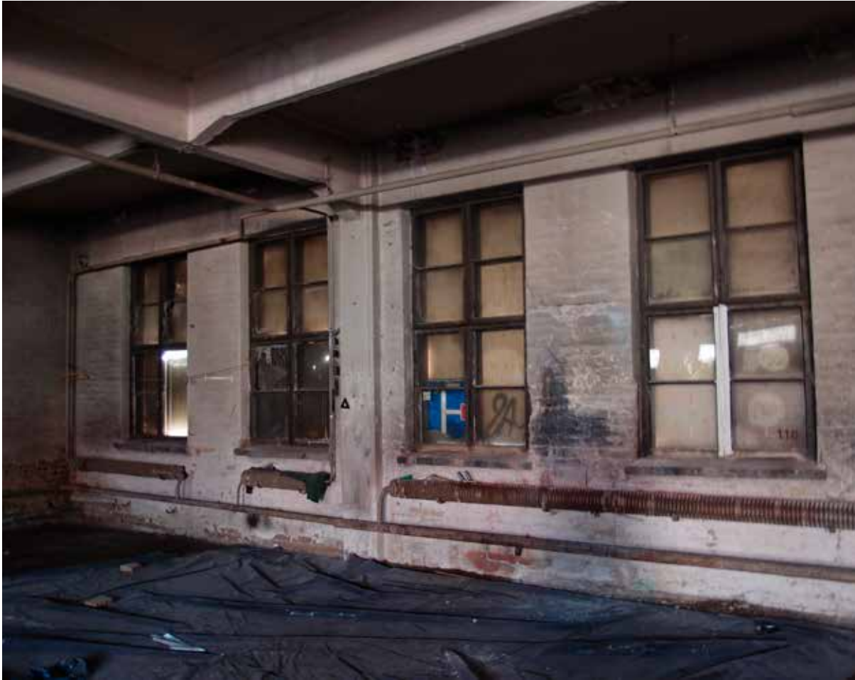
Kuvat 58-59: (edellisellä sivulla): Sisäkuvia Möysänkatu 5 1.kerroksesta. Entiset autohallitilat ovat pinnoiltaan kehnossa kunnossa, mutta välipohjan ylälaattapalkisto vaikuttaa hyväkuntoiselta. Valokuvattu kohdekäynnillä 06.05.2024.
