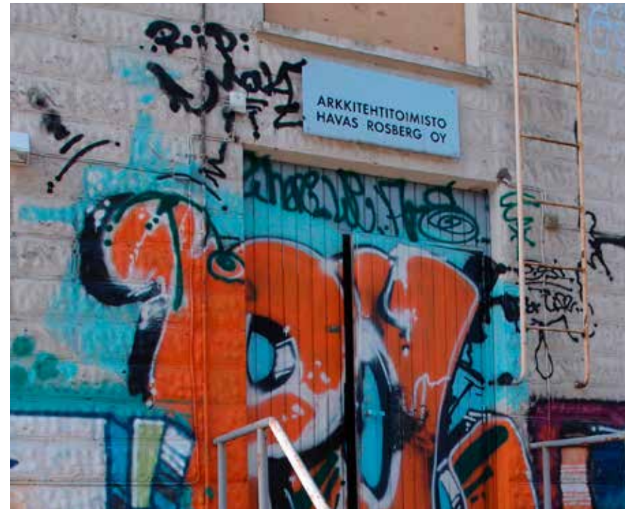
Kuva 37: Möysänkatu 3 pohjoispääty nykyasussaan, arkkitehtitoimiston jo muutettua kiinteistöstä. Valokuvattu 06.05.2024.
