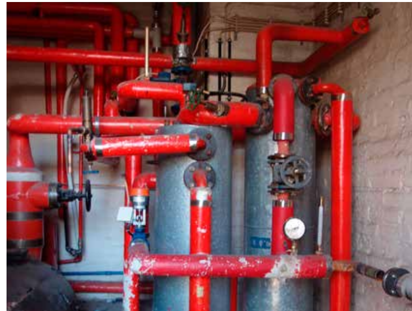
Kuva 79: Möysänkatu 5 vanhaan lämmitysjärjestelmään liittyvää putkiston "käärmepesää" eteläpäädyn kattilahuoneessa. Valokuvattu kohdekäynnillä 06.05.2024.
