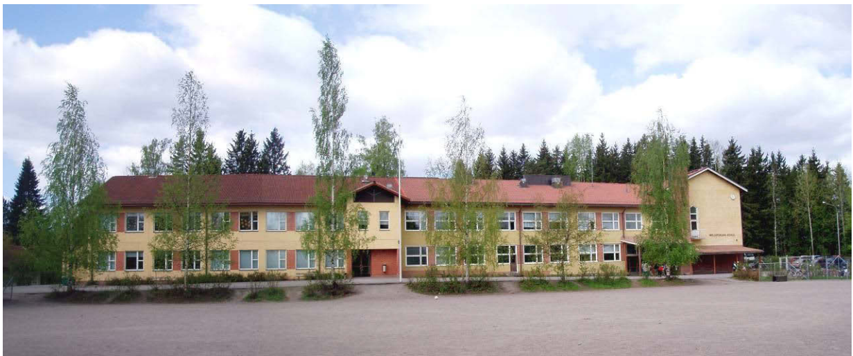
Myllypohjan koulu piirroskuvana ja valokuvana. Vasemmanpuoleinen pääty on rakennettu koulun jatkeeksi vuonna 1987. (Piirroskuva: Myllypohjan koulun kotisivut)
