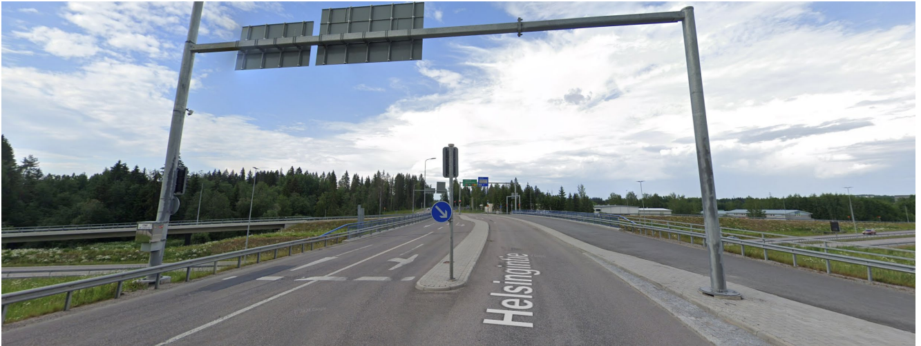
Kuva x Näkymä Eteläisen Kehätien eritasoristeyksen kohdalta pohjoiseen.
