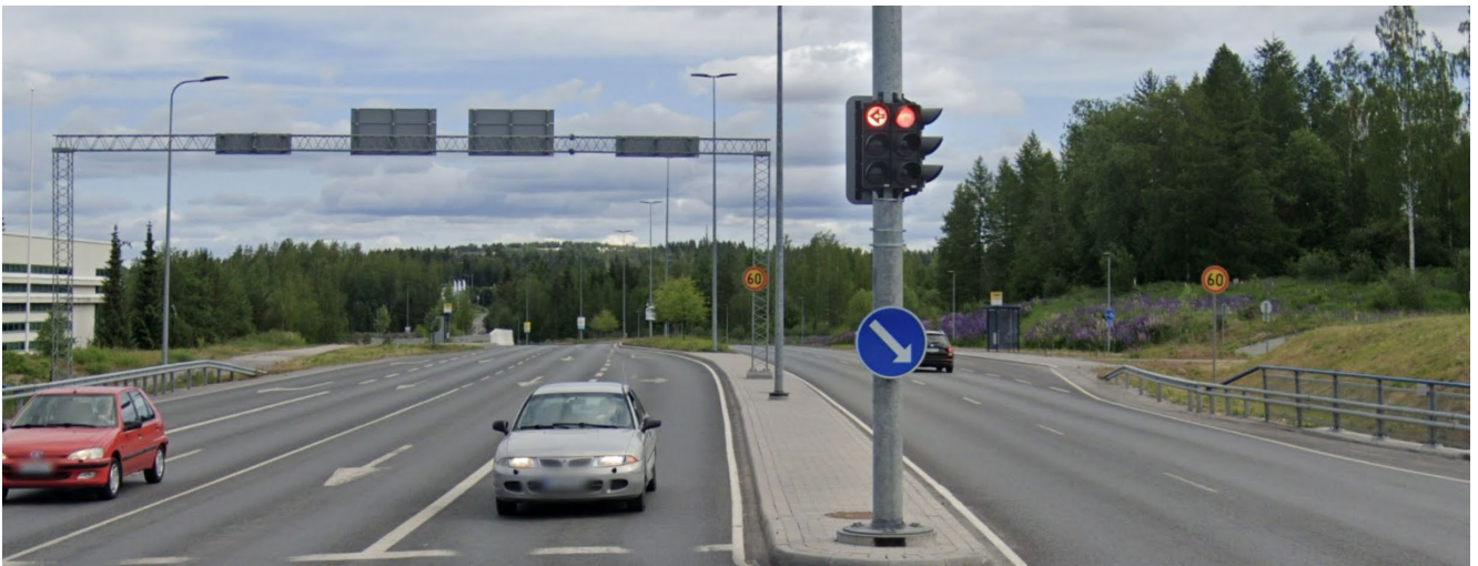
Kuva 3 Kuva Orimattilankadun ja Uudenmaankadun risteyksestä pohjoiseen.
