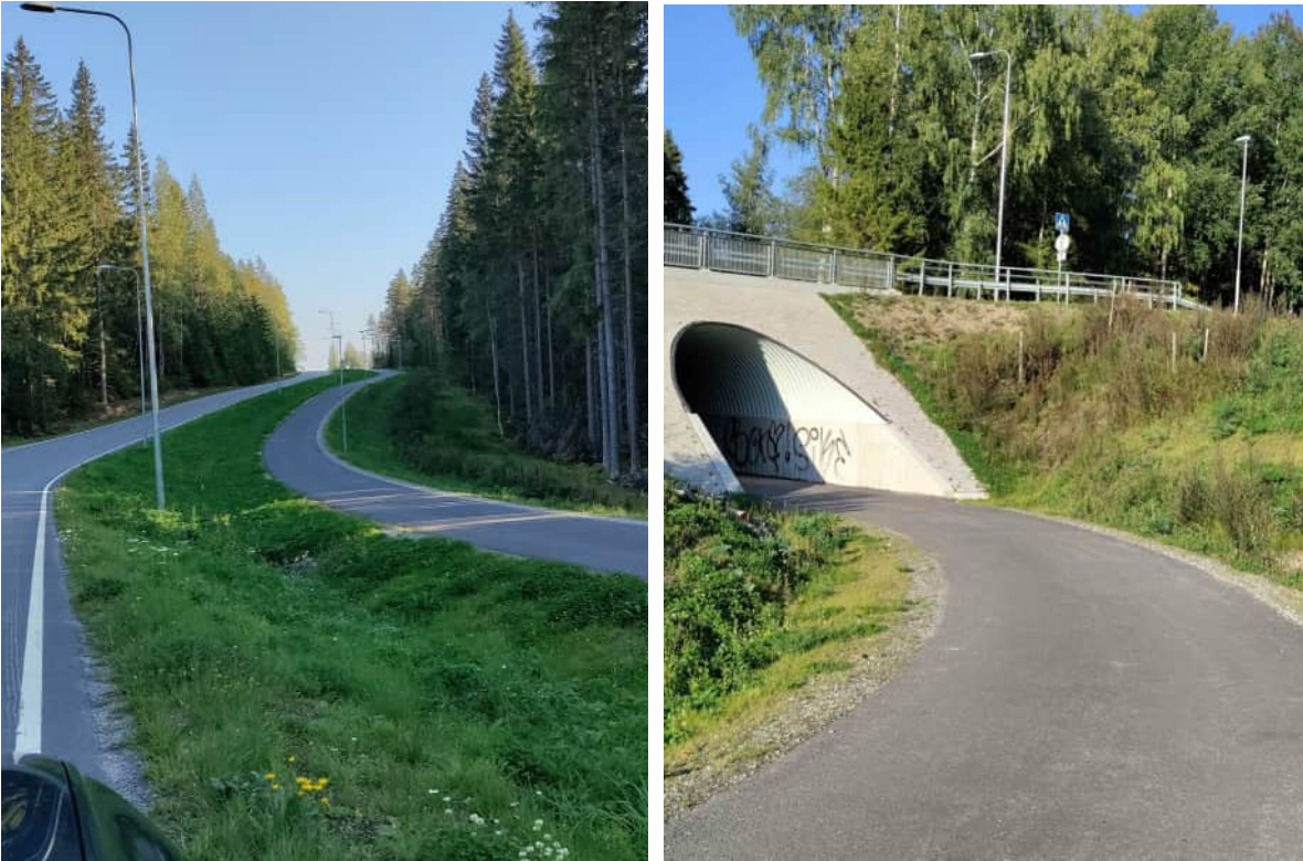
Kuva 5. Sipurantien varrella kulkee yhdistetty pyörätie ja jalkakäytävä, joka ulottuu Viuhasta länteen Suuntopolun risteykseen asti. Kuvassa oikealla uusi kevyen liikenteen alikulkutunneli Sipurantien länsiosassa. Uusi rakennettu kevyen liikenteen väylä parantaa kevyen liikenteen turvallisuutta ja palvelutasoa.
