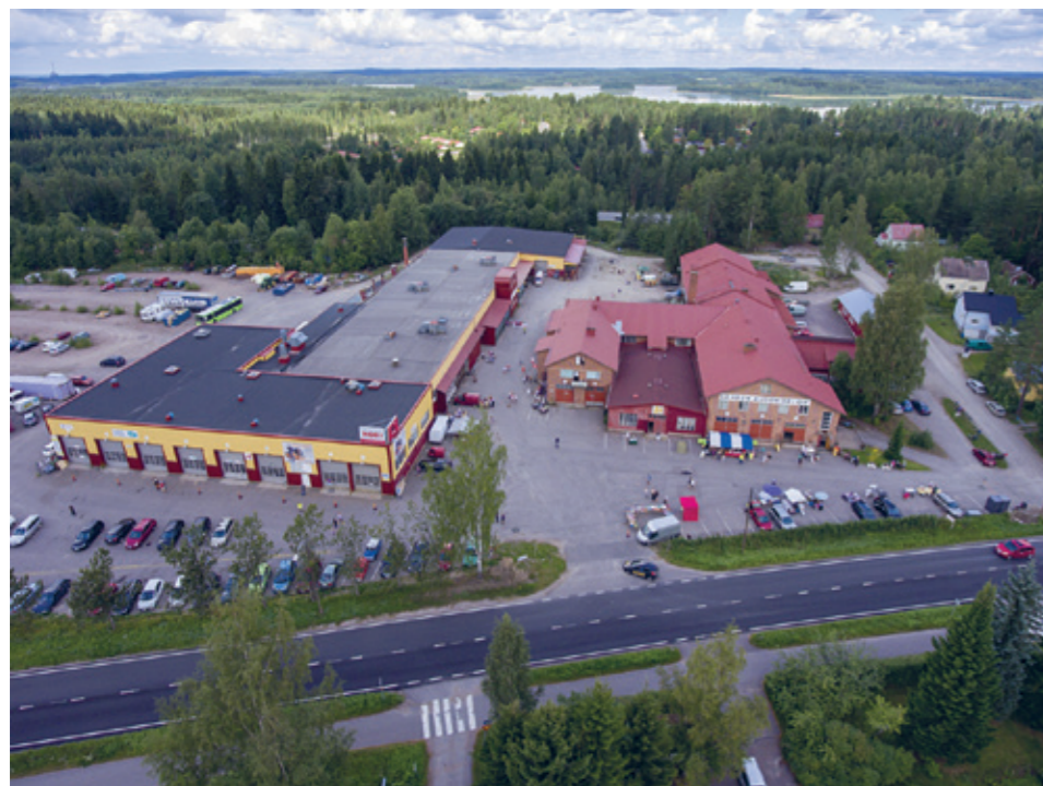
Liike- ja yrityskeskus KORI Villähteellä. Entisissä Lahden Autokori Oy:n tiloissa toimii nykyisin yli 40 eri alojen yrittäjää.
