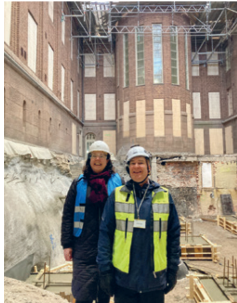
Lahden kaupungintalon laaja peruskorjaus alkoi kesäkuussa 2021. Kaupungintalo on tarkoitus ottaa käyttöön keväällä 2023. Tarkastaja Maija Hyppölä ja tarkastusjohtaja Reijo Ollikka työmaakatselmuksessa huhtikuussa 2022.
