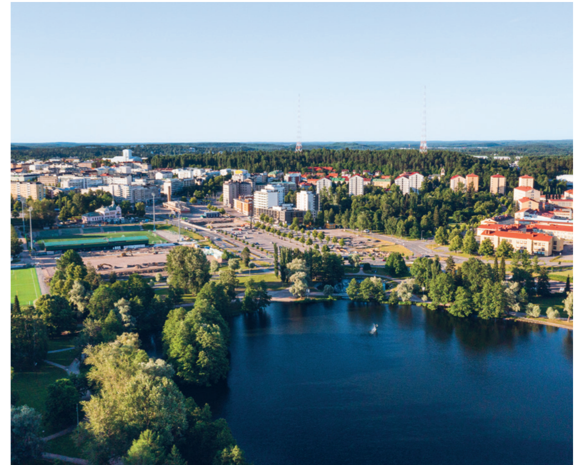
Kisapuisto ja Rantakartano uudistuvat rakennustöiden edetessä.
