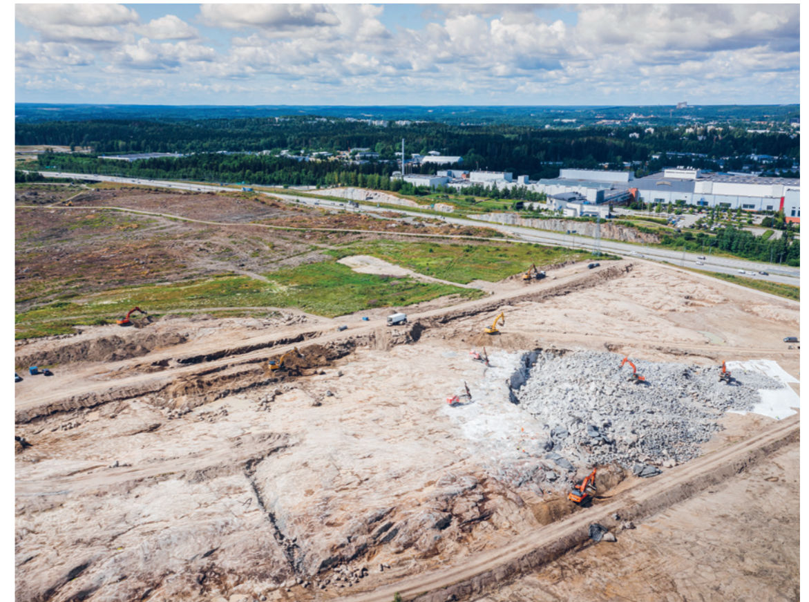
Fazerin makeistehtaan tontin esirakentamistyöt valmistuvat vuoden 2023 loppuun mennessä.
