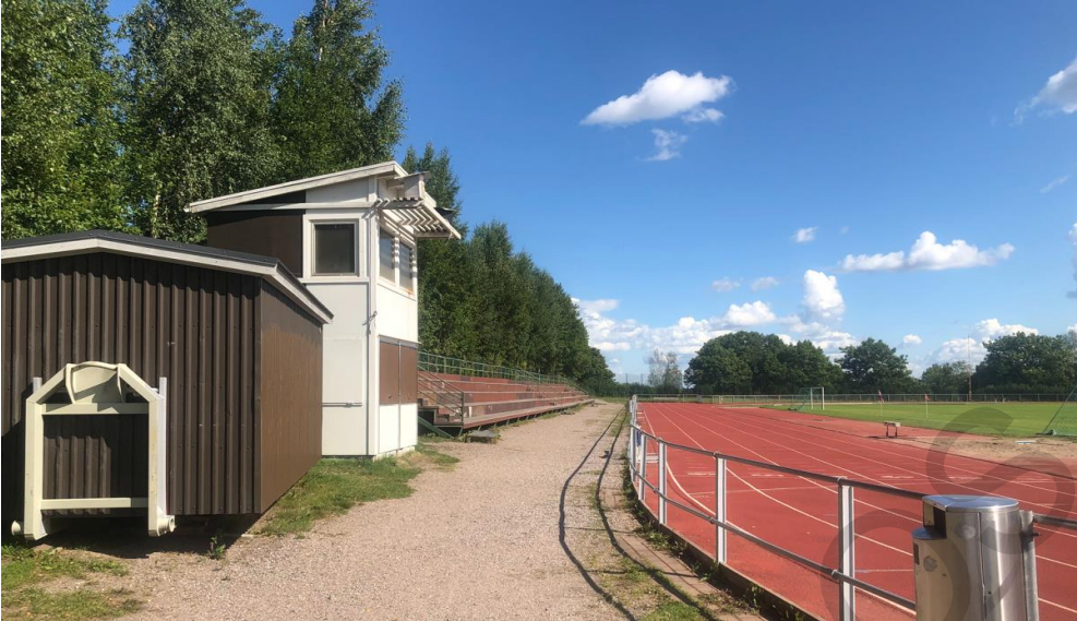
Kuva 7. Nykyinen kuuluttamo ja varastokontti
