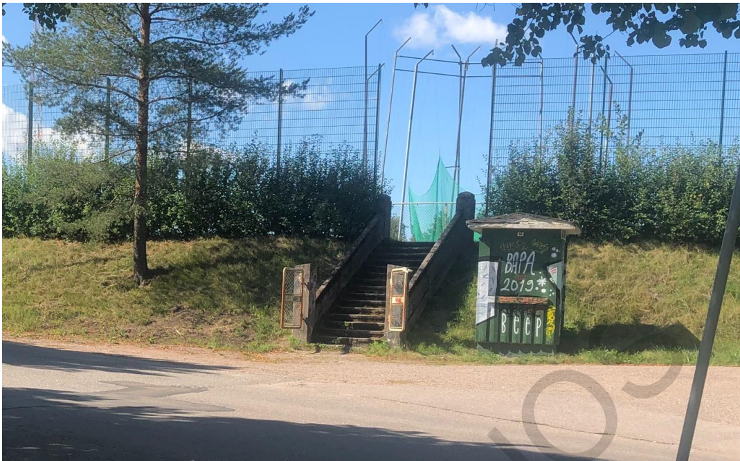
Kuva 12. Itäpäädyn kunnostettavat portaat
