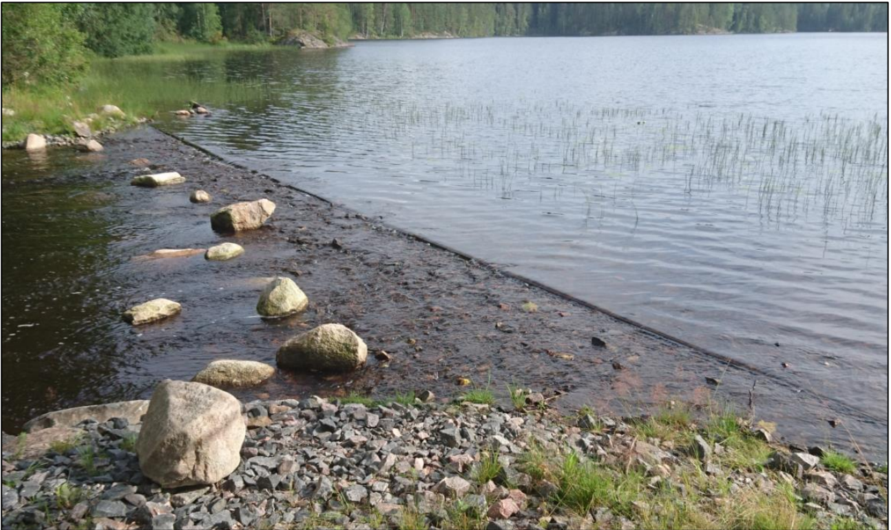
Kuva 9. Pohjakynnys Virtain Havanganjärvellä alivirtaamatilanteessa.
