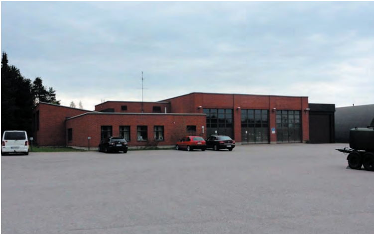
Rakennus 100, autohuoltola, oikealla rakennus 51.
