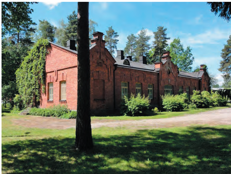
Rakennus 8, entinen rykmentin komentajan asuinrakennus.
