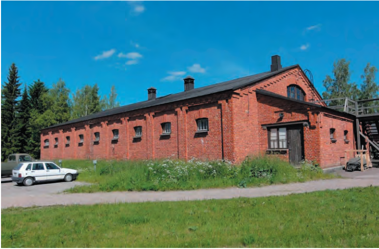
Rakennus 41, varasto, entinen talli.
