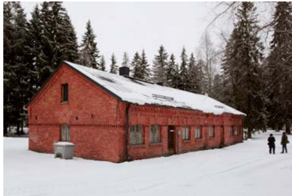
Sosiaalirakennus / korjaamo (15) on peräisin venäläisten ajalta.
