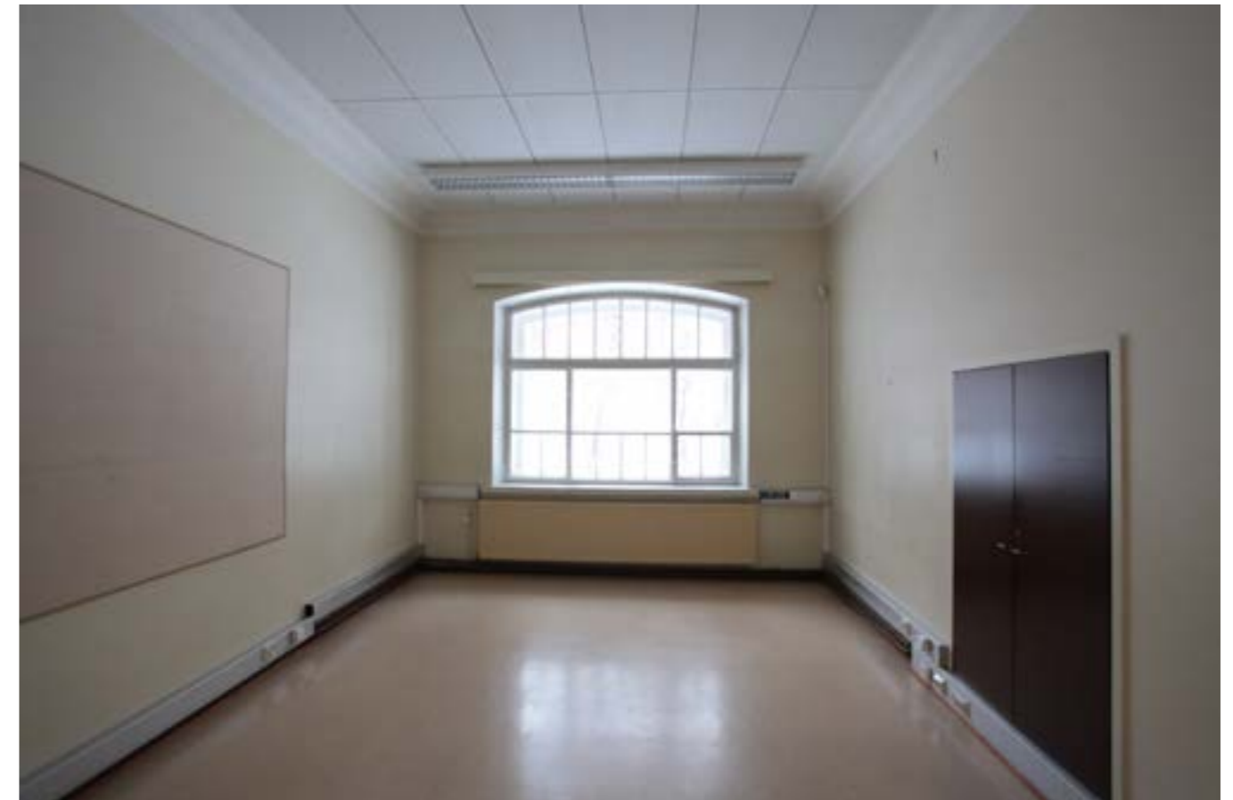
Toimistohuone laskettuine alakattoineen.
