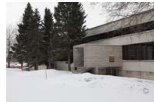
Muonituskeskuksen (30) betoninen sisäänkäyntikatos.
