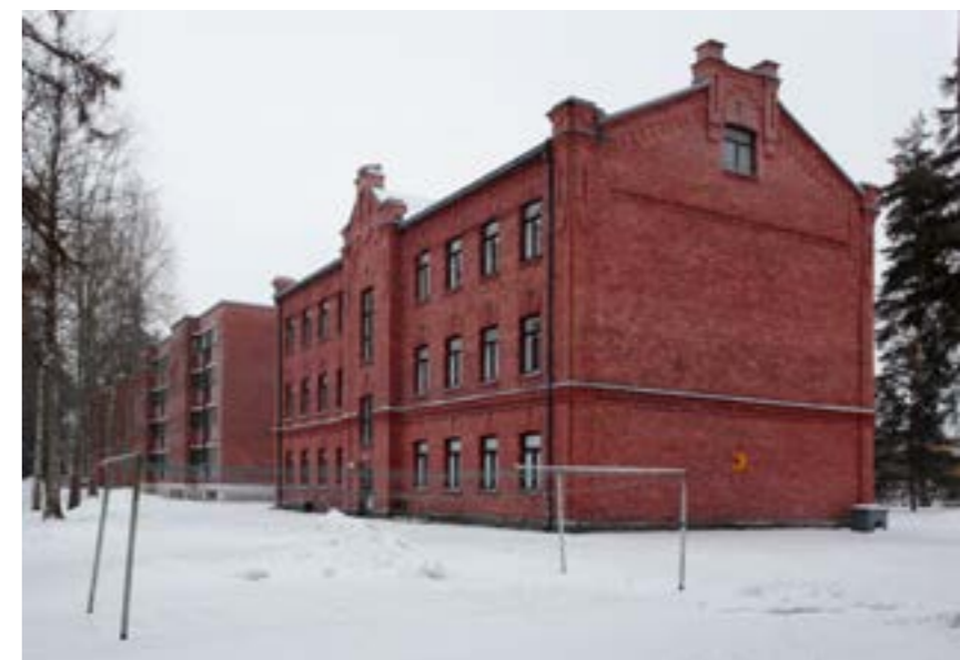
Koillisosan asuinrakennukset 4 ja 91.
