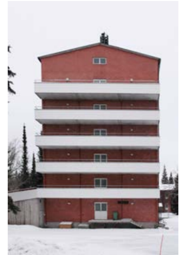
Sairaalan laajennus (V26) ottaa paikan alueen maamerkinä.
