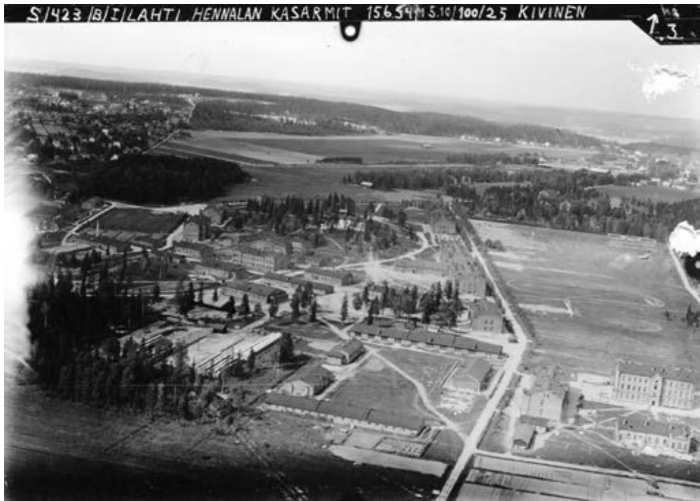
Vuoden 1934 ilmakuva etelästä.
