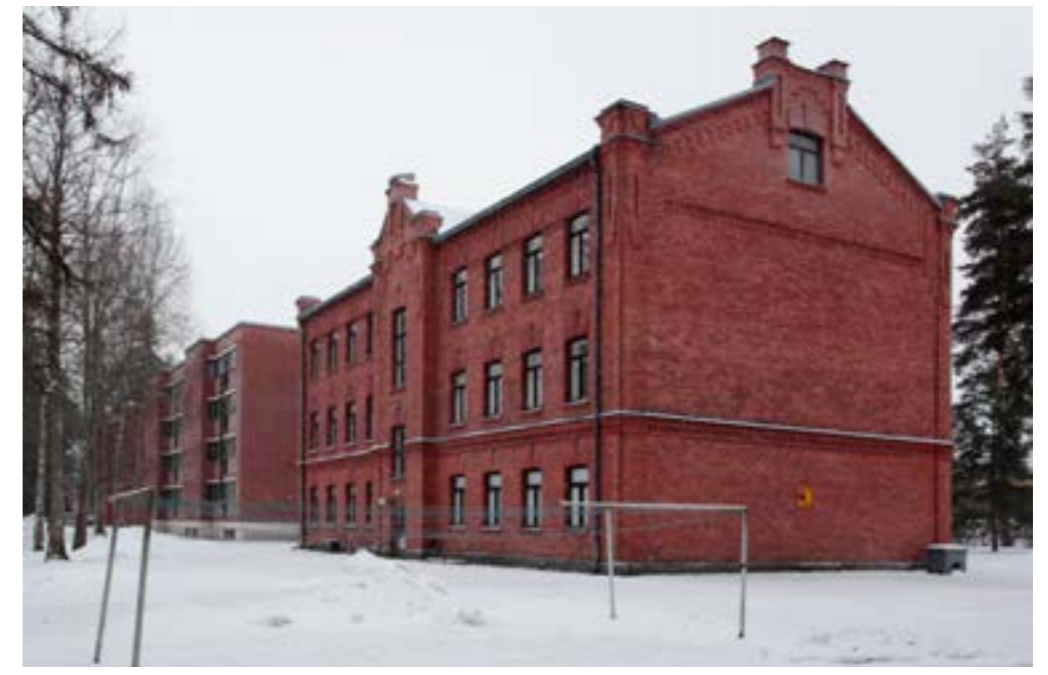
Asuinrakennus (4) edessä ja (91) takana.
