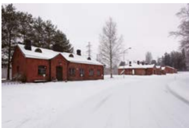
Sosiaalirakennus (33) ja kaalikellari (31).
