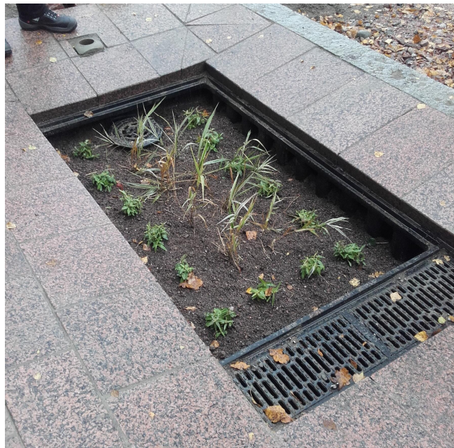
Kuva 3. Ranta-Kartanon alueelle asennettu kokeellinen hulevesielementti.
