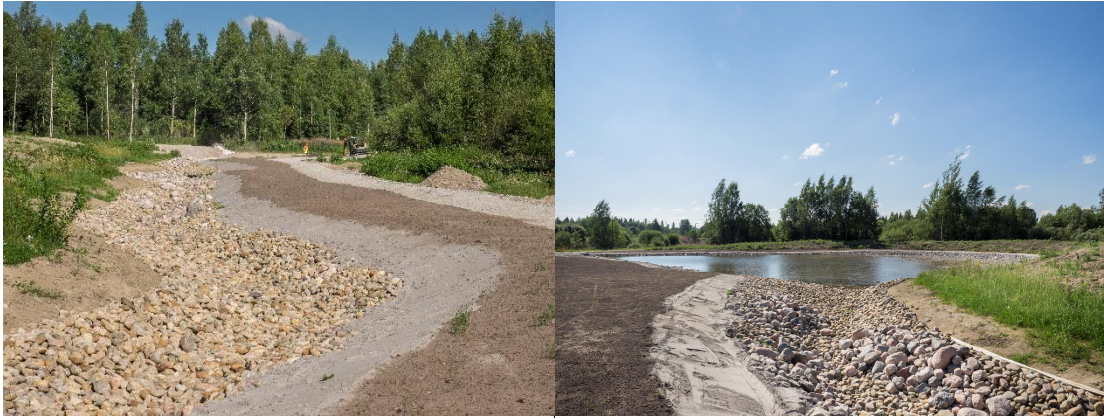
Kuva 10. Länsi-Hennalaan kesällä 2018 rakennettu luonnonmukaisia menetelmiä hyödyntävä hulevesien käsittelyjärjestelmä, joka toimii myös kehittyvän alueen lähivirkistysalueena.
