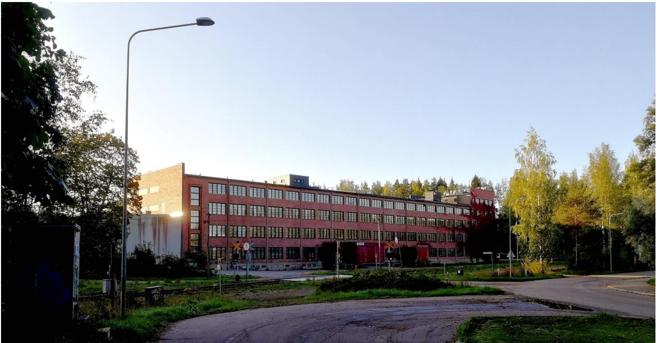
Kuva 26. Merivaaran teollisuusrakennus. (kohde 11)
