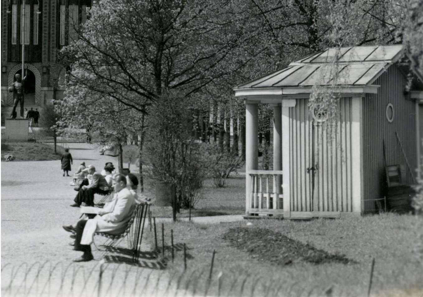
Harjupuiston länsipäässä 1920-luvun lopulta 1950-luvulle sijainnut puinen, klassistinen kioski. Yksityiskohta valokuvasta sivulla 46.
