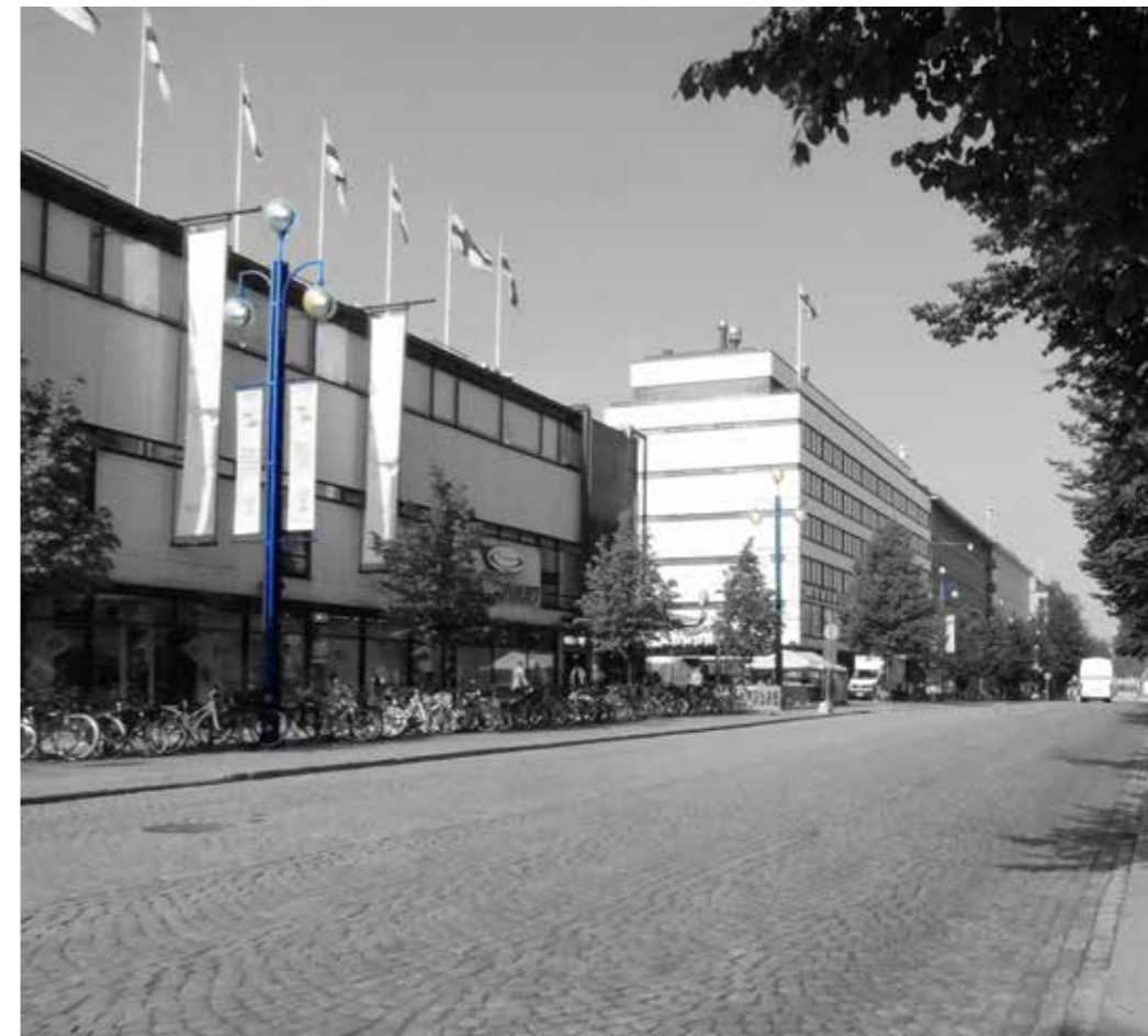
Kuva 4.5: Aleksanterinkadun valaisinpylväät säilytetään ennallaan, mutta sisäinen tekniikka uusitaan.
