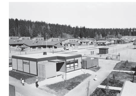
9 Osa Riihelän asuntomessualueen rakennuksista koottiin DOMINO-elementeistä. Alueen suunnittelussa ja toteutuksessa kiinnitettiin huomiota erityisesti asuinalueen viihtyisyyteen.
