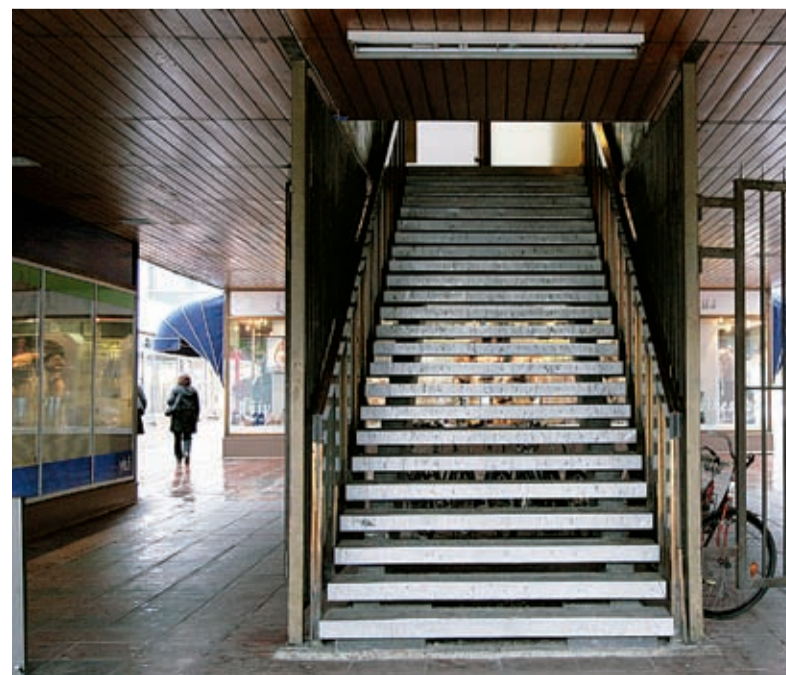
46 Unto Ojosen suunnittelema Tuomitilo valmistui 1963. Siinä on ajan lahtelaiselle kaupunkisuunnittelulle tyypillinen valopiha.
