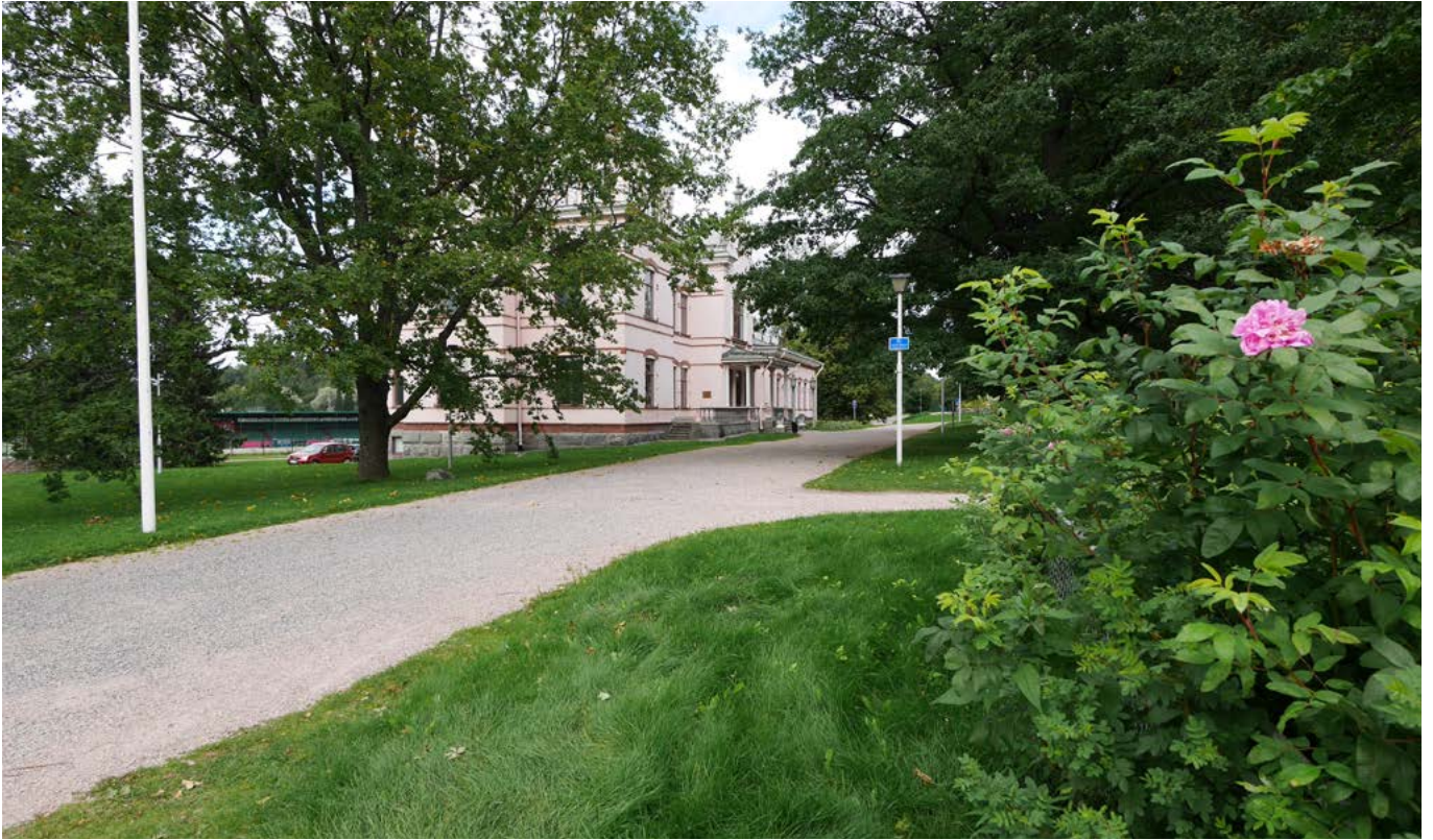
Suora käytävä myötäilee pitkänomaista päärakennusta.
