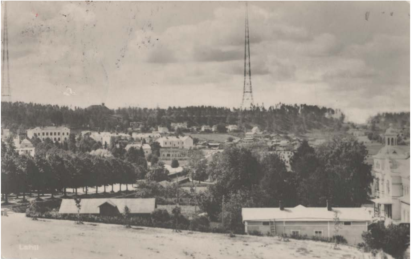
Kuva n. 1930 Lahden rakentaminen jatkui -kirjasta. Lyseon terassin päästä katsottuna puutarha on kuin rehevä keidas. Vasem- malla Lahdenkadun lehmusrivi. Etuallalla pengerryksen alla ovat vielä jäljellä puutarhurien rakennus ja kartanon henkilökunnan asuintalo / LKM
