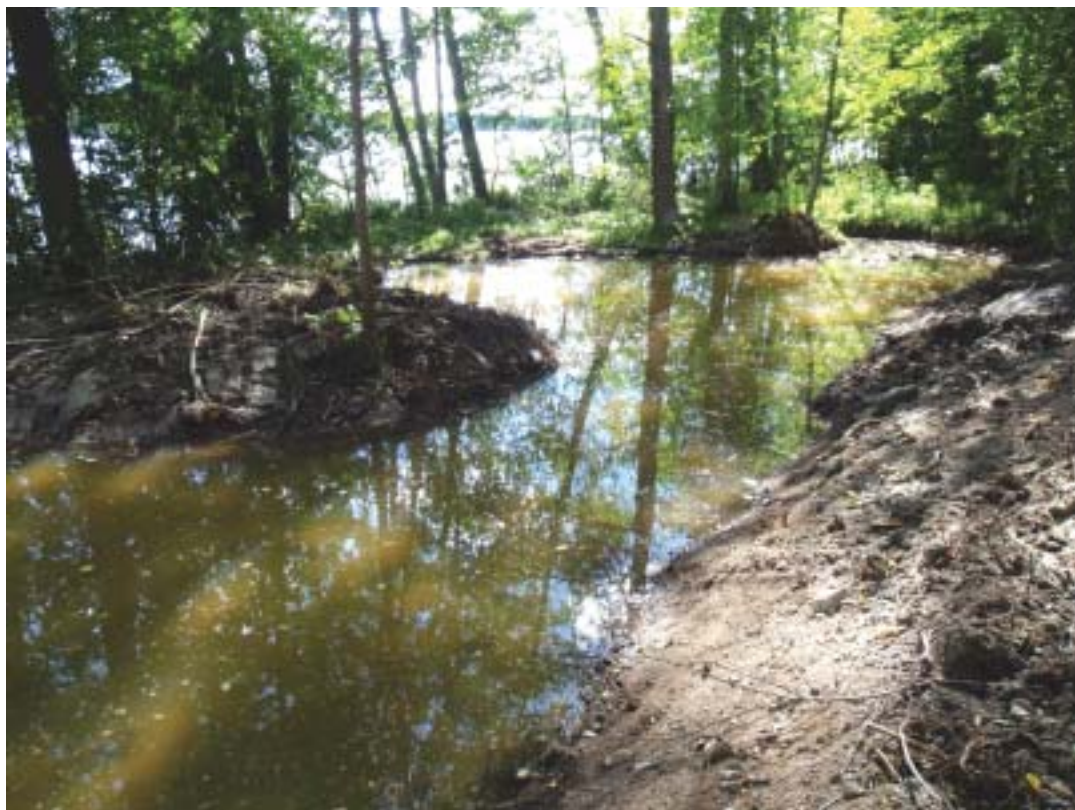
Kuva 6. Kosteikot hidastavat veden virtausta, laskeuttavat kiintoainesta ja sitovat ravinteita. Kuvassa on vastakaivettu kampakosteikko Takkulassa Alasenjärven rannalla elokuussa 2010.
