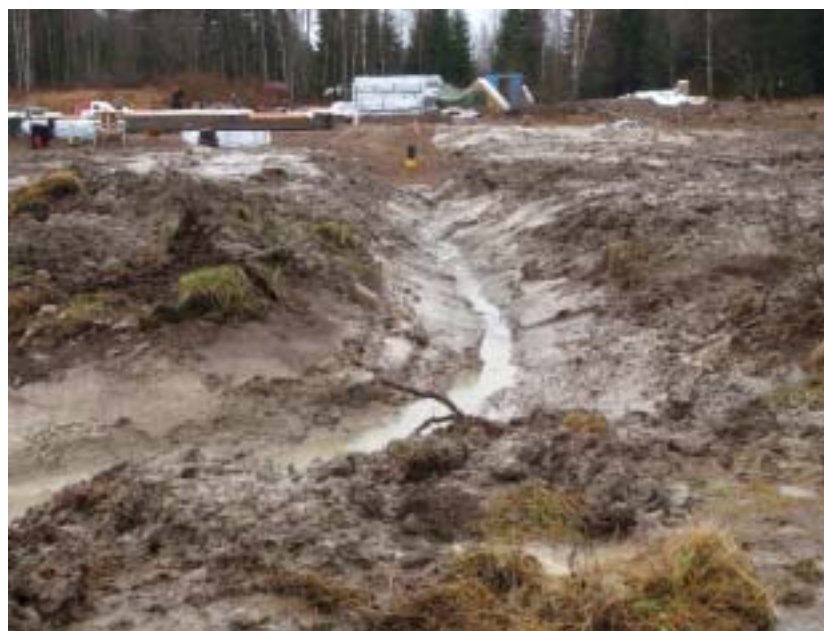
Kuva 5. Rakentamisen aikana maaperä on laajoilla alueilla paljaana kasvillisuudesta ja näin alttiina huuhtoutumaan sateiden mukana vesistöihin. Kuvassa on rakennustyömaa Nastolassa marraskuussa 2008.
