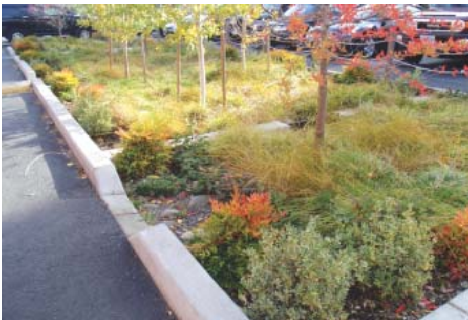
Kuva 3. Huleveden käsittelyä parkkialueella. Katkokset reunakiveyksissä mahdollistavat huleveden virtauksen hajautettuun imeytysrakenteeseen. Portland, USA marraskuussa 2009.
