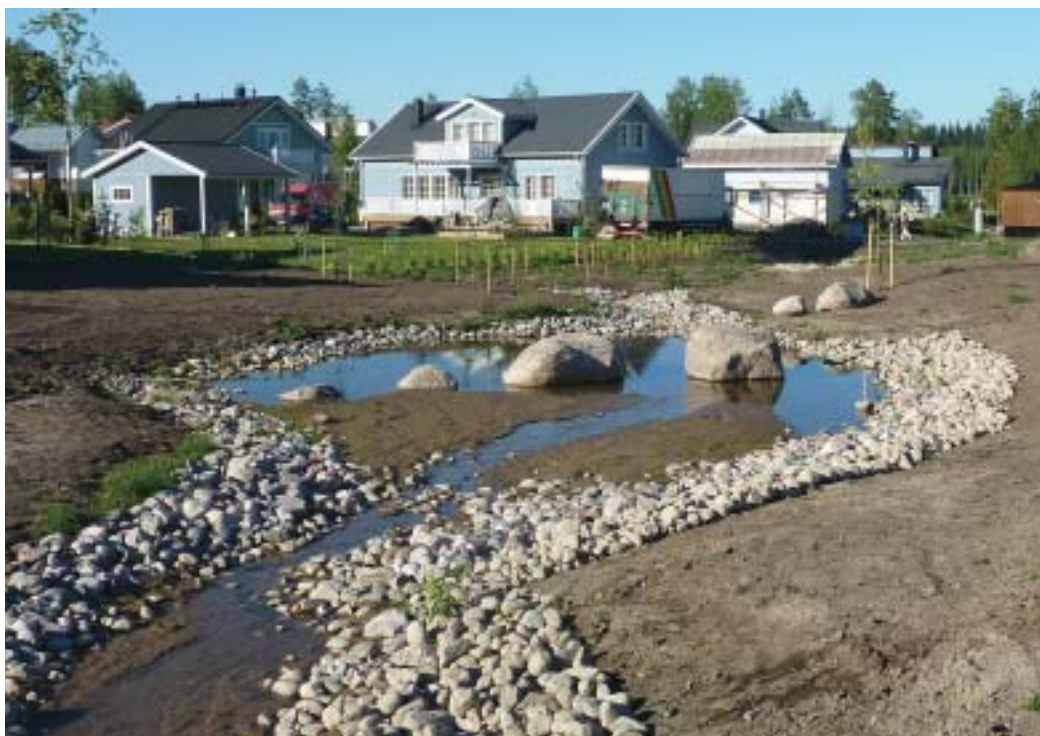
Kuva 15. Vastarakennettu avoin huleveden johtamisjärjestelmä Karistossa heinäkuussa 2010. Järjestelmä hidastaa veden virtausta ja puhdistaa vettä, kun kasvillisuus on levittäytynyt alueelle.
