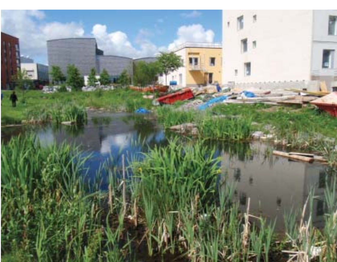
Kuva 12. Hulevesien käsittelyjärjestelmällä saadaan pienennettyä rakentamisen aikana tulevaa kuormitusta. Kuvassa on hulevesiallas Helsingin Viikissä kesäkuussa 2010.
