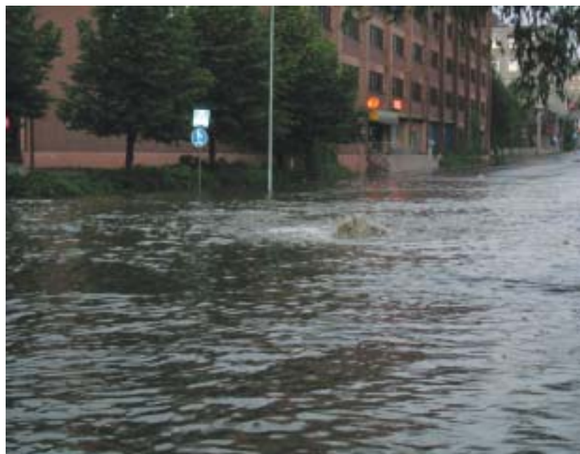
Kuva 2. Perinteinen hulevesiputkisto ei ole mitoitettu poikkeuksellisia vesisateita varten. Kauppakatu elokuussa 2004.
