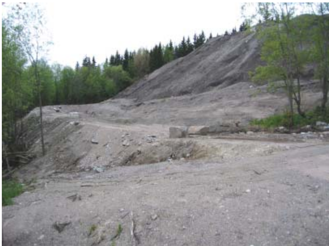
Kuva 13. Lumenkaatopaikan sulamisvedet tulee käsitellä ennen vesistöön johtamista. Kuvassa on Lahden Vanhantien lumenkaatopaikan suodatusallas toukokuussa 2008.
