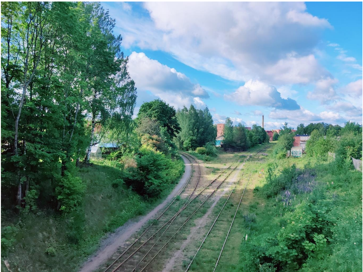
Kuva 21.1. Vanhaa rataverkkoa Sopenkorven alueella.
