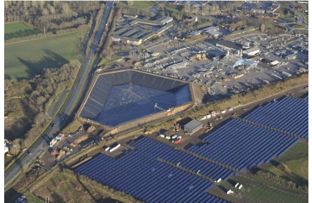
Lämmön kausivarasto Vojens, Tanska. Tilavuus 200 000 m 3 Pinta-ala 30 000 m 2 Aurinkolämmönkeräimiä 70 000 m 2 Lämmönvarastointi 12 GWh
