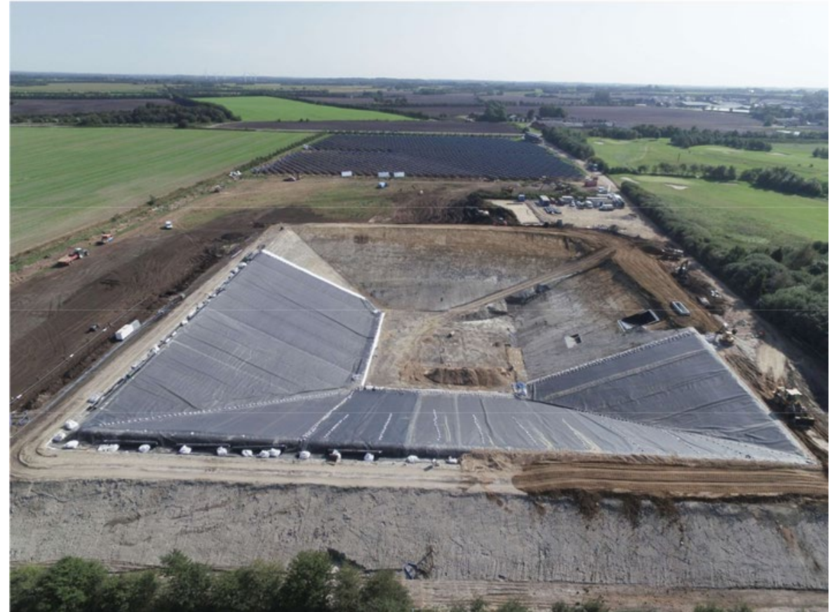
Lämmön maakuoppakaushavarasto Toftlund, Tanska. Tilavuus 85\,000\text{ m}^3
