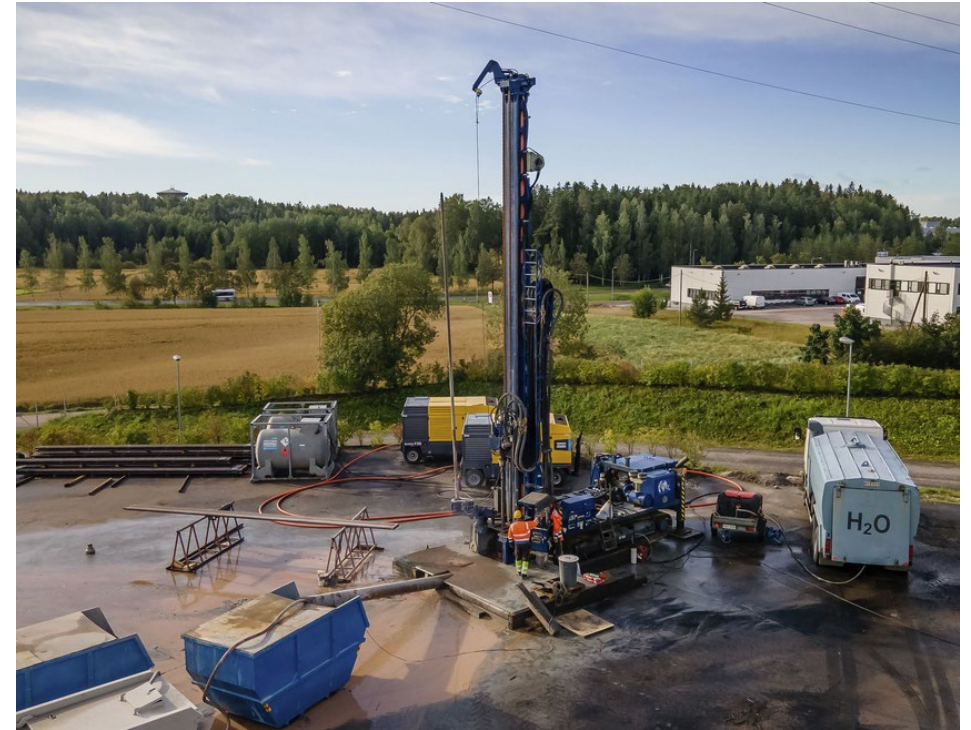
Kuva: Variston geotermisen lämpölaitoksen työmaa. Lähde
