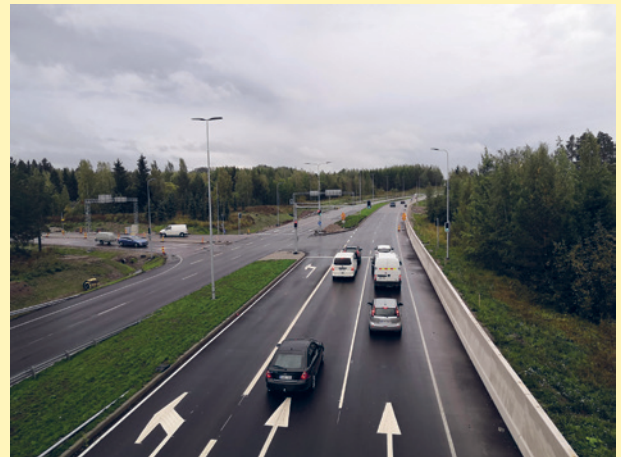
Suomen suurin käynnissä oleva tiehanke – 275 miljoonaa euroa maksava Vt 12 Lahden eteläinen kehätie -hanke – eteni hyvin vuoden 2019 aikana. Eteläisen kehätien ensimetrejä otettiin liikenteelle kesän 2019 aikana ja sisääntuloväylän parantaminen jatkui läpi vuoden. Lahden kaupungin rahoitusosuus hankkeesta on kaikkiaan noin 70 M€, josta maksettiin vuonna 2019 24,5 M€. Kuva: Väylävirasto
