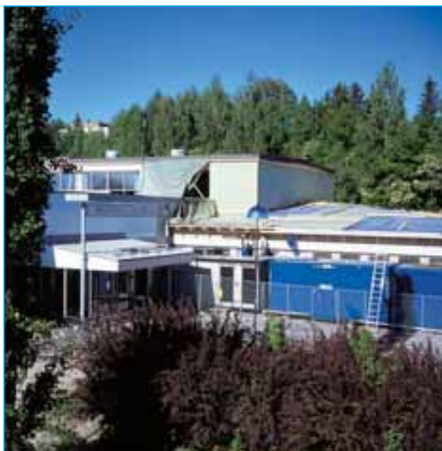
Mukkulan koululla suoritettiin vuonna 2002 laajat saneeraustyöt kosteus- ja homevaurioiden vuoksi. Korjauksen alla ovat olleet myös mm. Lounaanpuiston ja Kiveriön koulut ja Liipolan ala-aste sekä useat päiväkodit ja kaupungintalo.
