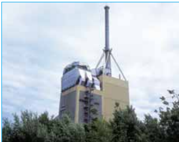
Kymijärven voimalaitoksessa tuotetaan sähköä ja lämpöä myös energiajätteestä.
