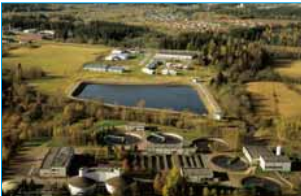
Ali-Juhakkalan jätevedenpuhdistamo valmistui 1961.
