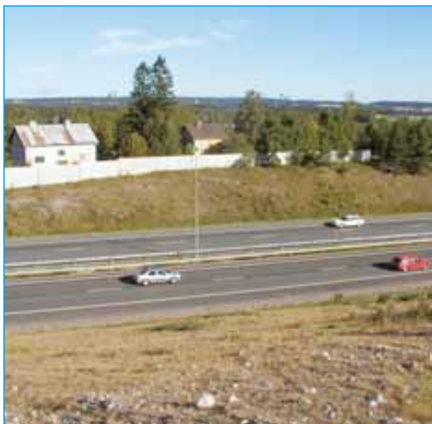
Lahdessa on tarvetta lisätä asukkaiden melusuojausta. Kuvassa Tielaitoksen rakentamaa meluseinää Helsinki-Lahti -moottoritien varressa.
