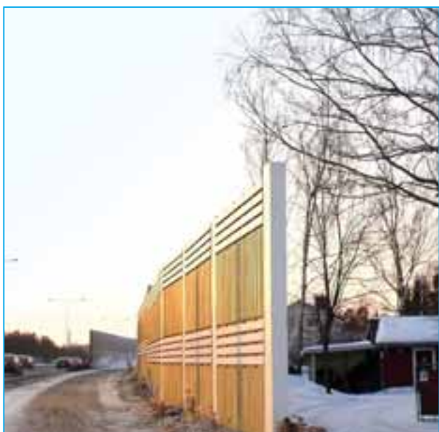
Tiehallinnon rakentama meluseinä valtatie 12:n varrella Pirttiharjussa lisää satojen omakotiasukkaiden elinympäristön viihtyisyyttä.
