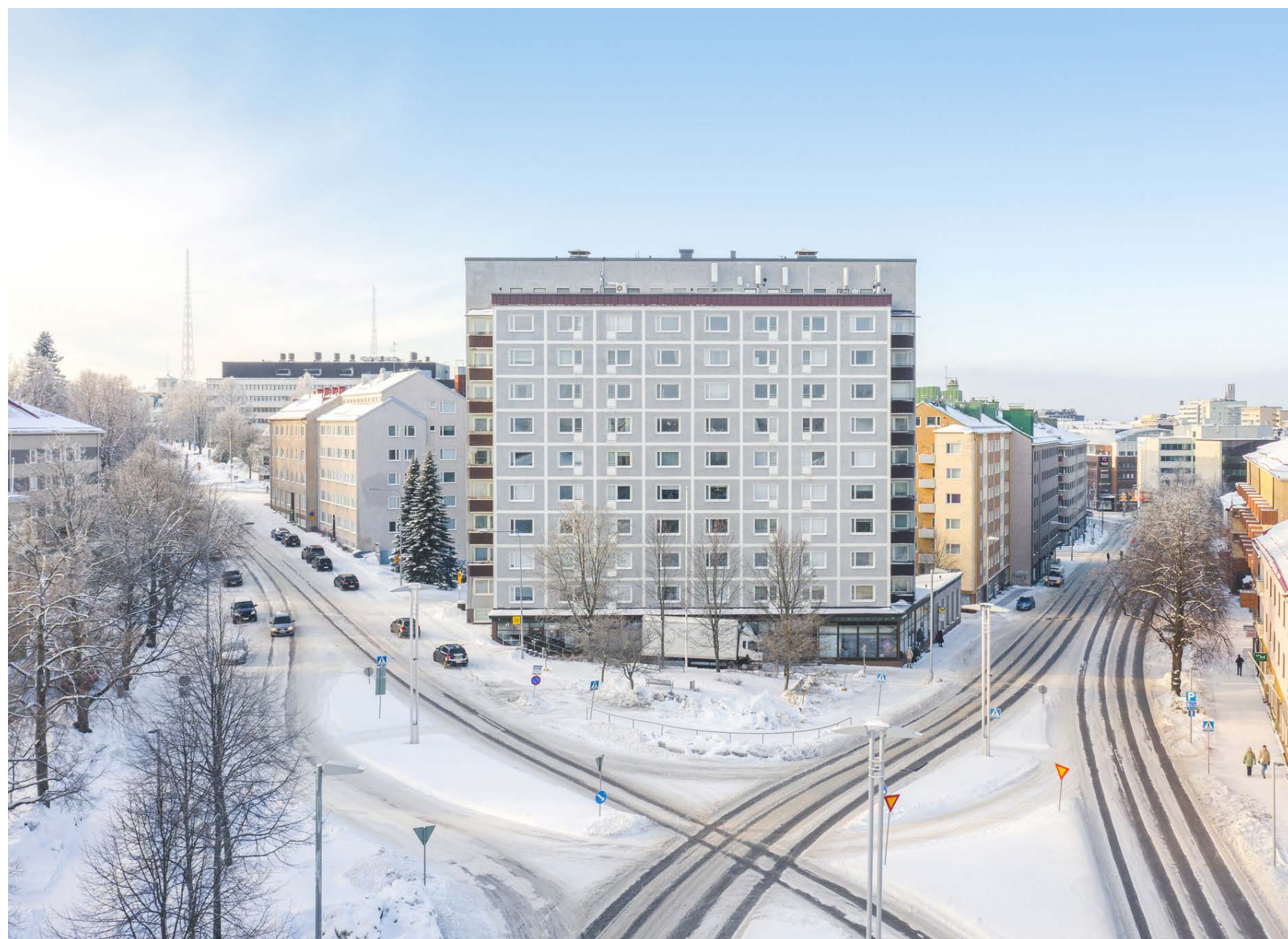
Karjalankadun pääteaiheeksi valmistui 1957 arkkitehti Unto Ojosen suunnittelema 11-kerroksinen asuin- ja liikerakennus Oikoportti. Kuva: Juha-Pekka Huotari
