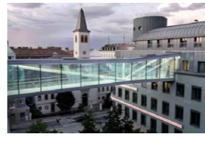
Sillan primäärirakenteet saadaan suojaan lämpimään tilaan. Skywalk Renweg, Wien.
