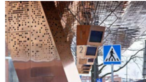
Perforoitua metallipintaa Lahden matkakeskuksessa.
