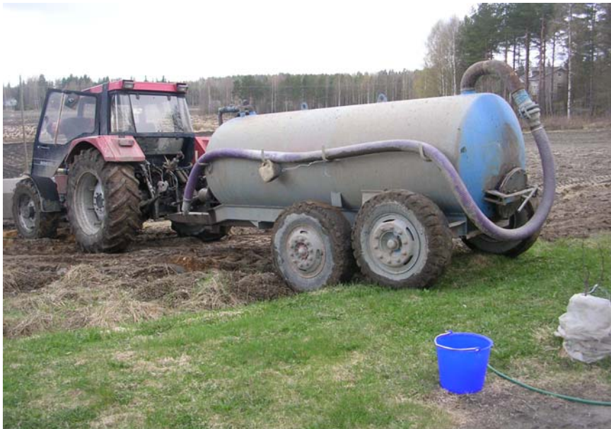
Kuva 2. Maataloudessa käytettävä imupainevaunu soveltuu hyvin kalkkistabiloinnin suorittamiseen
