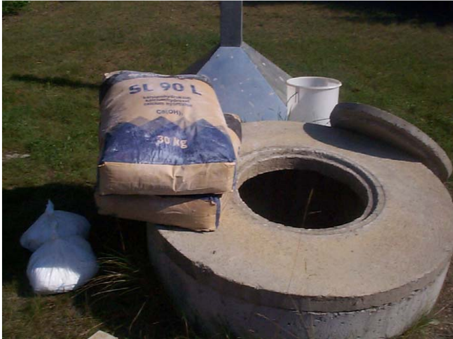
Kuva 1. Varaa kalkkistabilointia varten riittävä määrä sammutettua kalkkia
