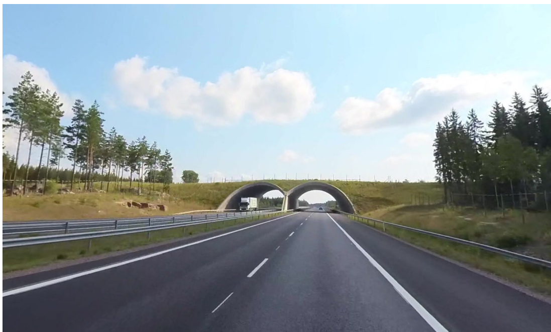
KUVA 5. Vihersilta Koskenkylä-Kotka -moottoritieellä (GoogleMaps).
