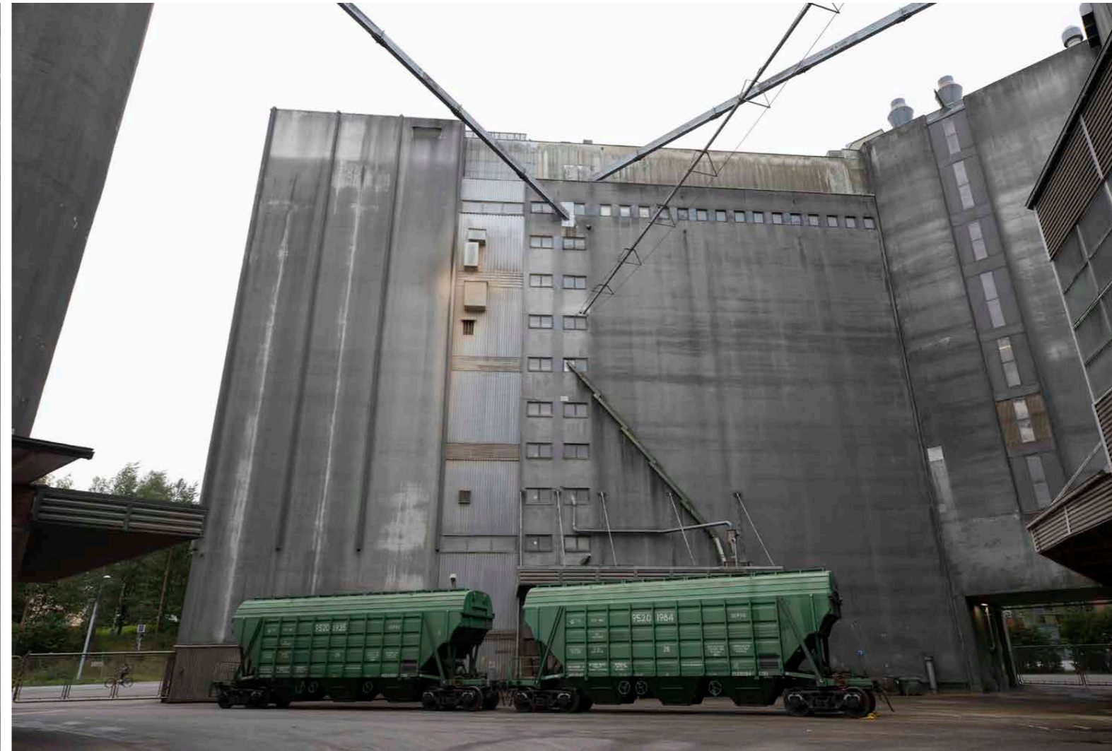
Uuden siiloston seinämä Polttimon sisäpihan suuntaan.
