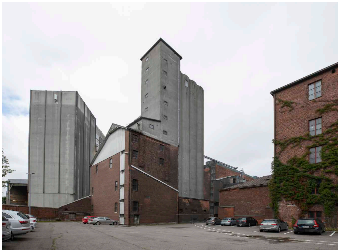
Vanha siilorakennus on keskellä uuden siilon ja vanhan hiivatehtaan välissä.
