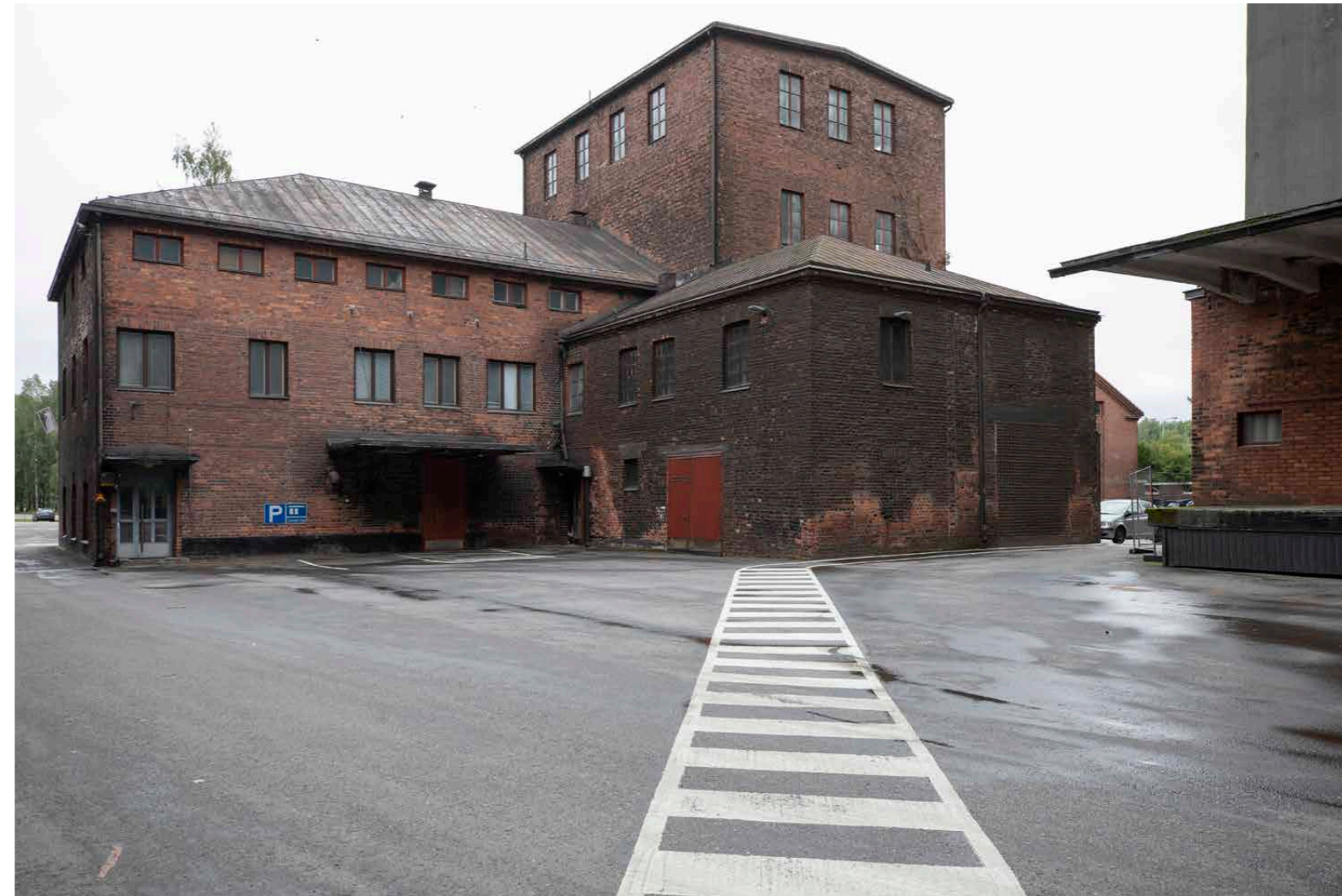
Vanha hiivatehdas etelään. Etualalla matalassa osassa on vanha kattilahuone.
