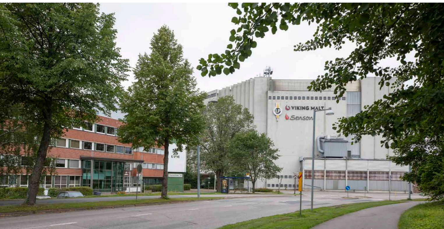
Näkymä Niemenkadun mutkassa pohjoiseen. Vasemmalla on UPM:n konttorirakennus ja oikealla näkyy voimakkaana maamerkinä maisemassa kohoava Viking Malt:n viljasiilorakennus.
