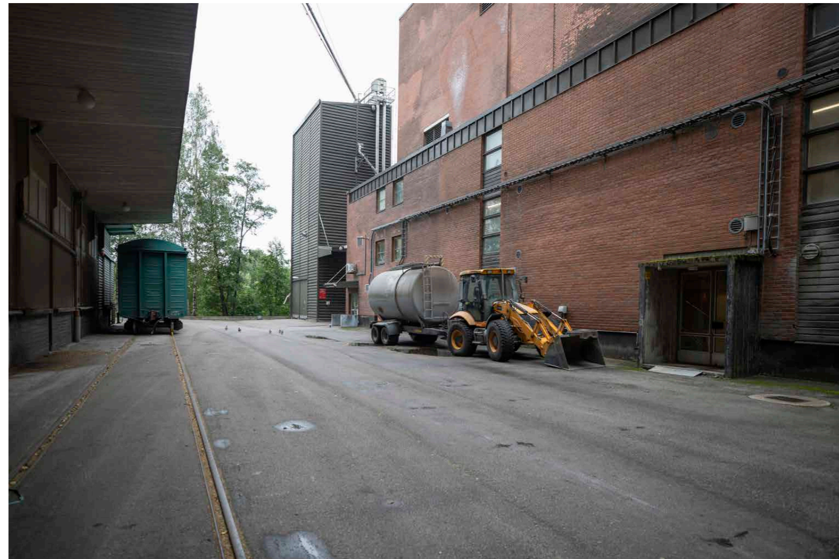
Näkymä mallastamon ja uuden siilon välistä rantaan.
