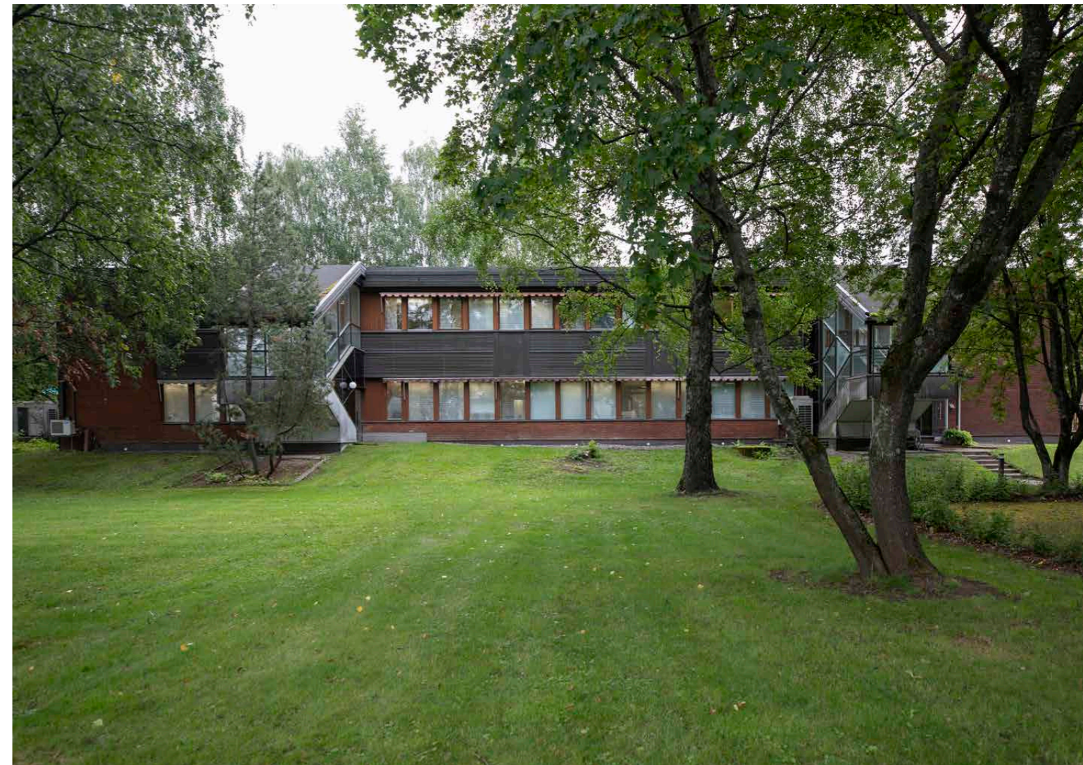
1960-luvulla rakennettua konttorirakennusta on korotettu 2. kerrokselle 1980-luvulla.
