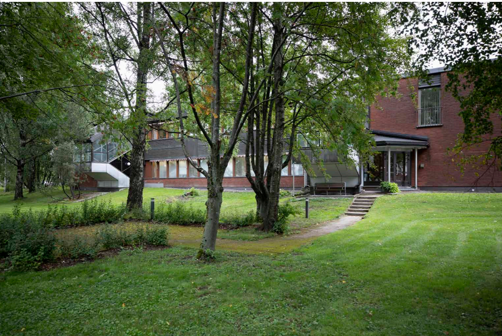
Jälkikäteen lisätyt portaikot konttorirakennuksessa näkyvät sisäpihan puolella.
