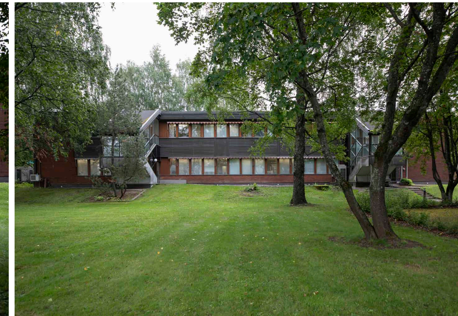
1960-luvulla rakennettua konttorirakennusta on korotettu 2. kerroksella 1980-luvulla.
