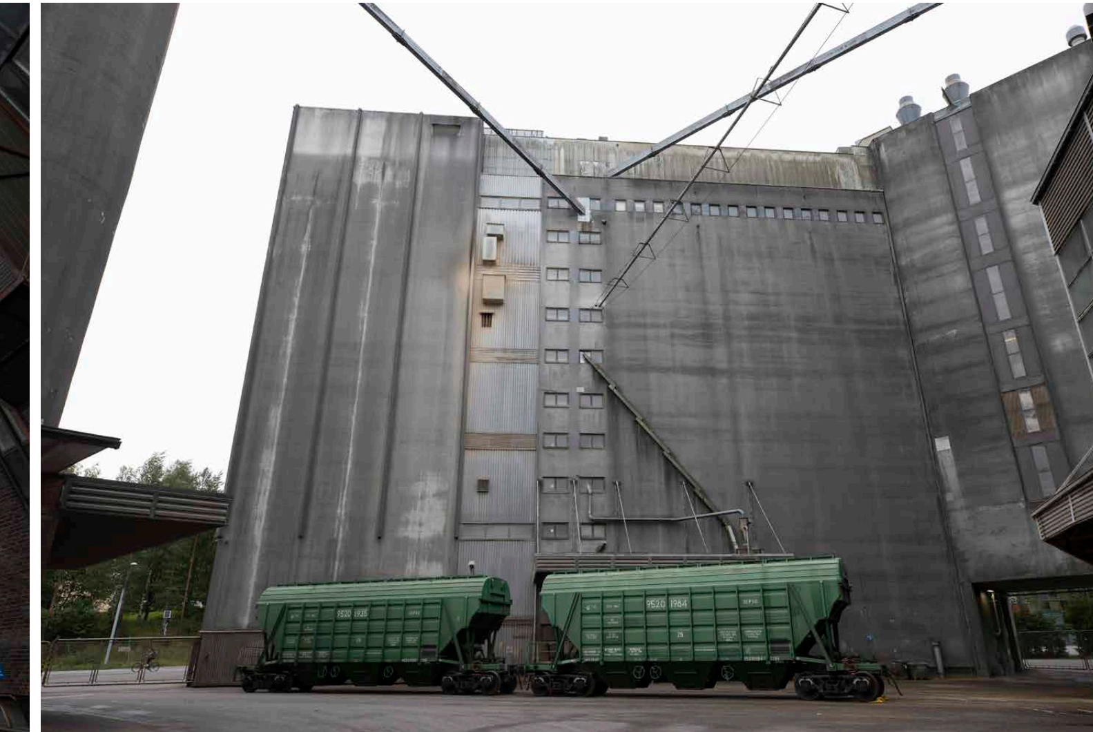
Uuden siiloston seinämä Polttimon sisäpihan suuntaan.
