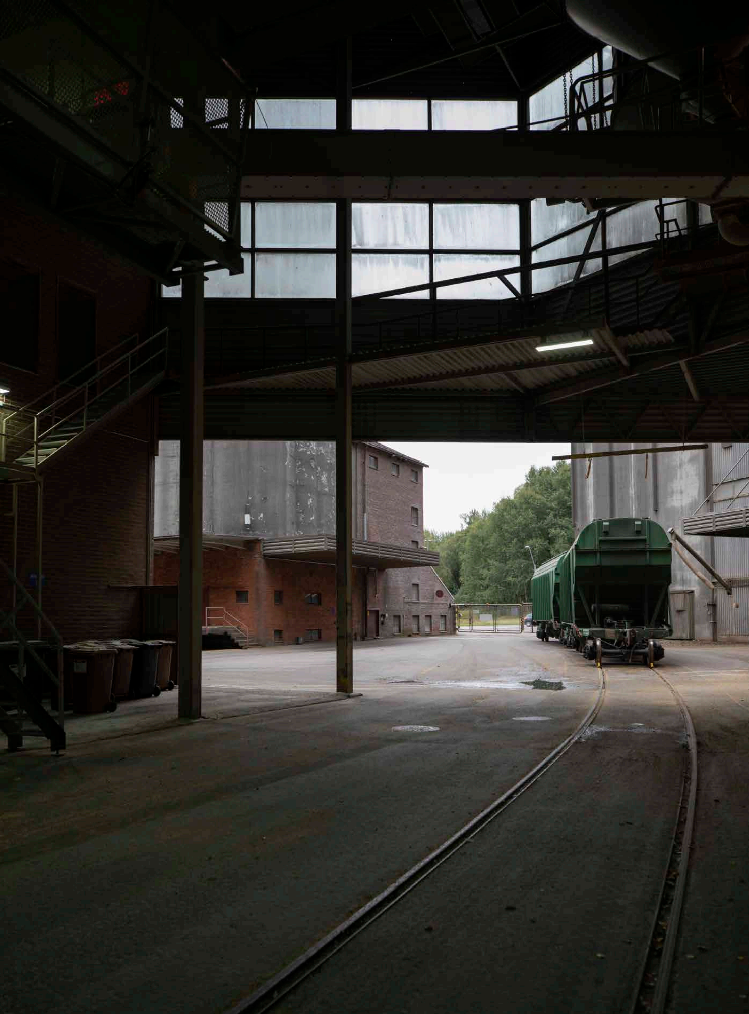
Näkymä mallastamon ja uuden siilon välistä Niemenkadulle.
