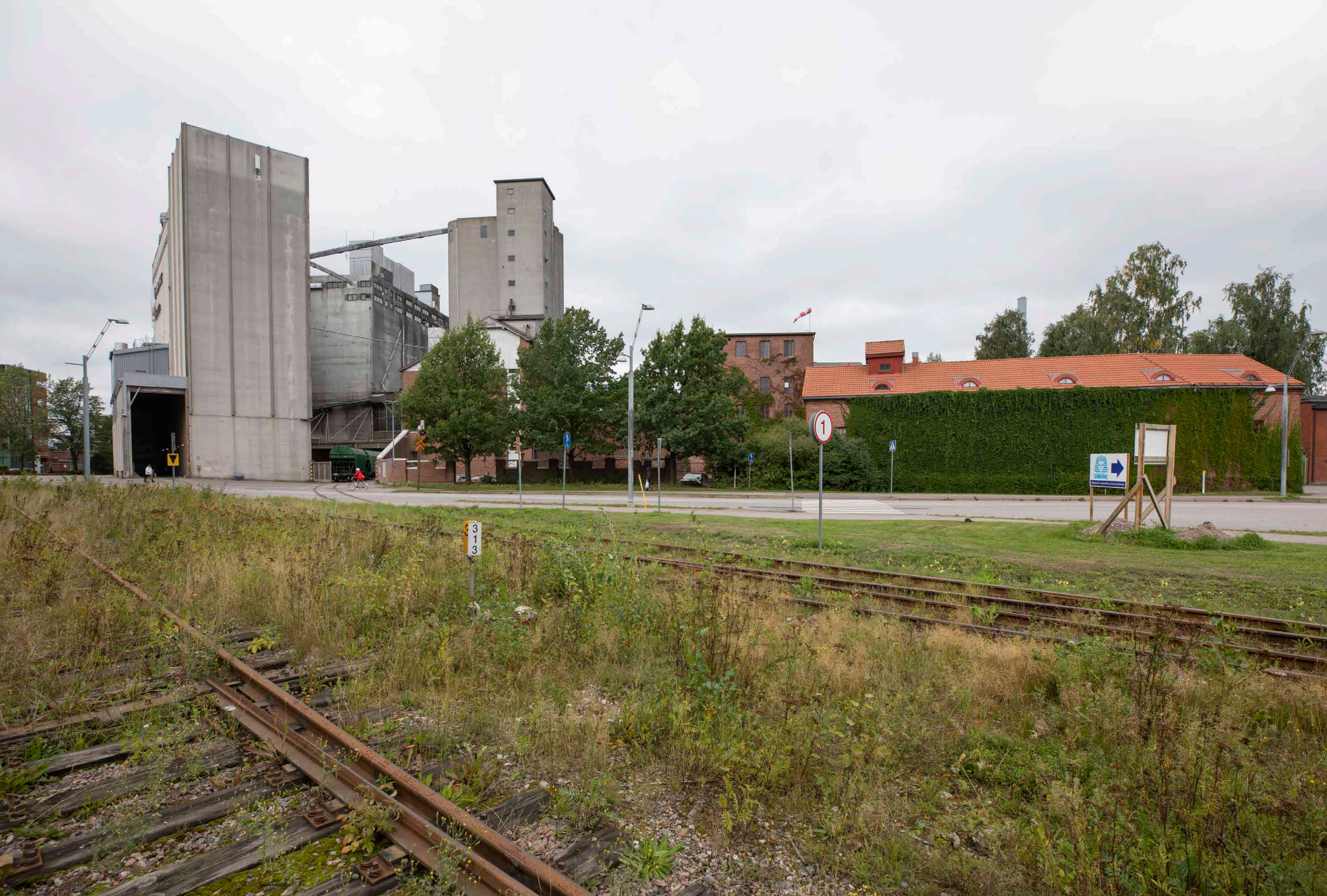
Vasemmalla näkymä teollisuusraiteelta Niemenkadun yli Polttimon alueelle. Uusi ja vanha viljasilo kohoavat alueen maamerkkeinä.
