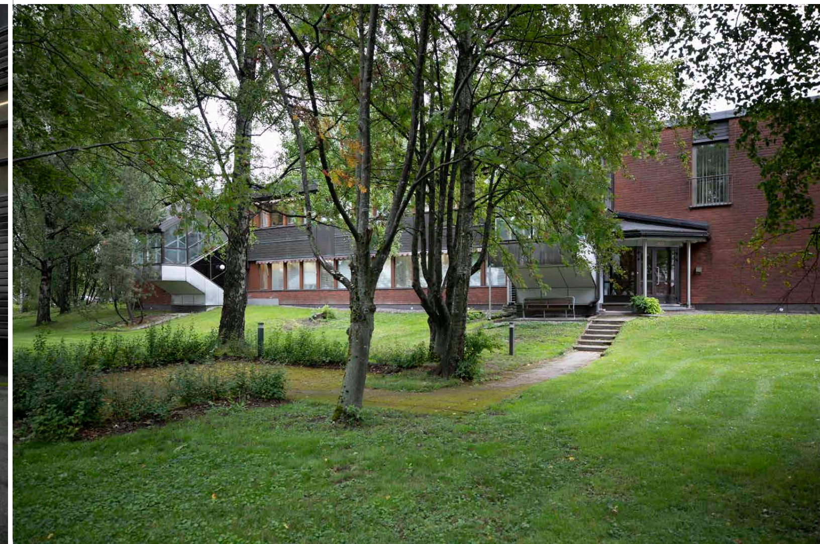
Jälkikäteen lisätyt portaikot konttorirakennuksessa näkyvät sisäpihan puolella.
