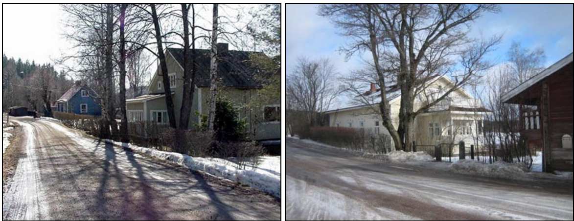
Kuvat 37 ja 38. Olemassa olevaa rakentamista: Lintulantieltä ja Askolan talo. (Carita Uronen 2002.)
