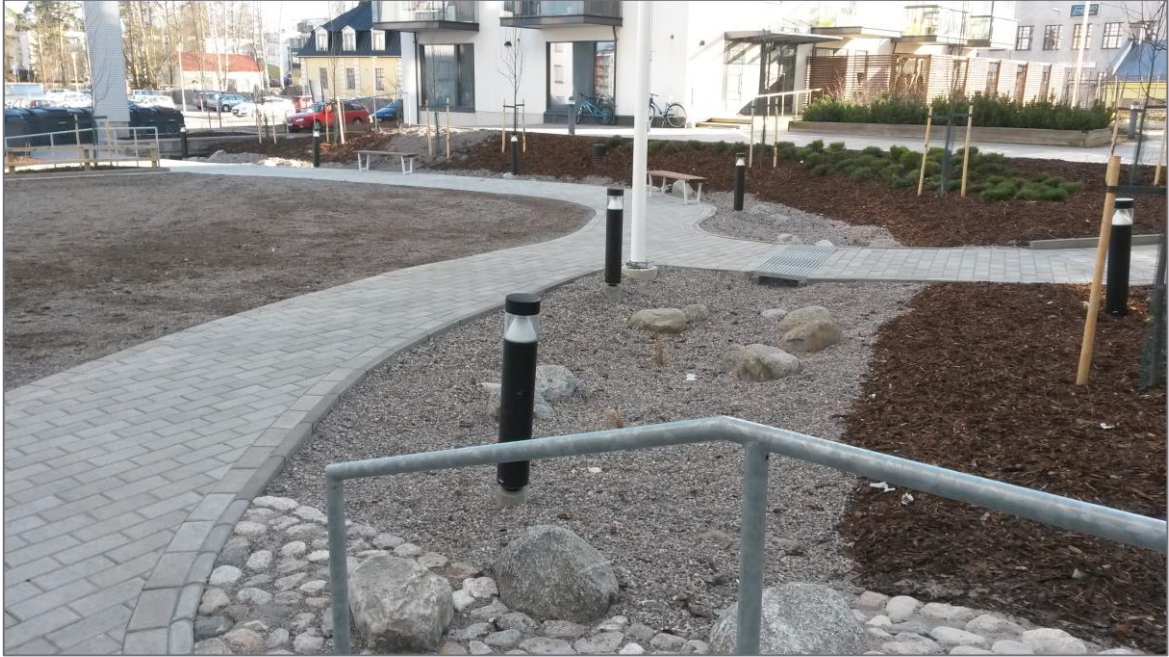
Kuva 2. Rakennusliikelähtöinen rakennustyömaa. Katto- ja pintavedet ohjataan suodatuspainanteeseen, joka rakennettiin rakennustyön alkuvaiheessa kertaalleen ja jonka suodatusrakenne ja pinnoite istutuksineen uusittiin viimeistelyvaiheessa (kuva: Sitowise Oy).
