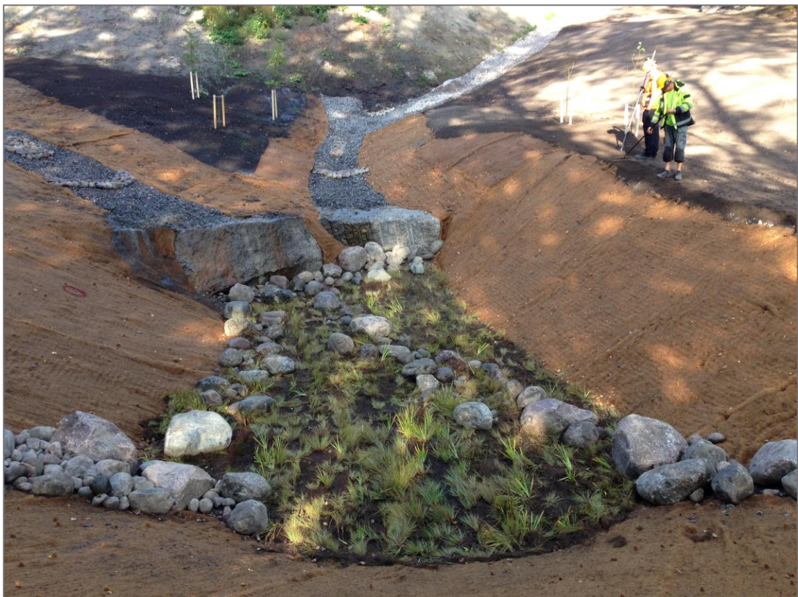
Kuva 8. Hulevesien imeytysrakenteen luiskat on suojattu siemeneroosiokankaalla ja imeytysrakenteen pohja vesikasvimatolla (kuva: Sitowise Oy).
