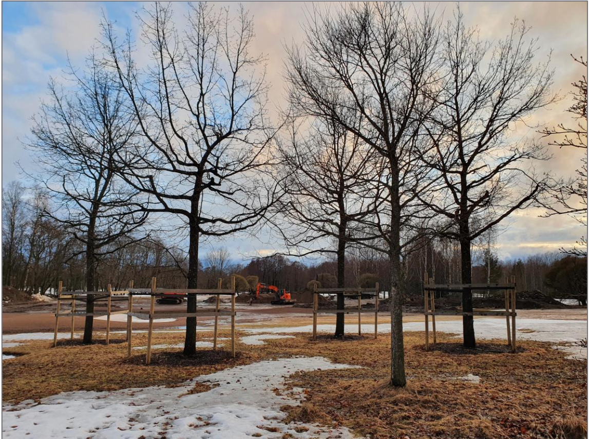
Kuva 6. Puistopuut on suojattu aitaamalla (kuva: Sitowise Oy).
