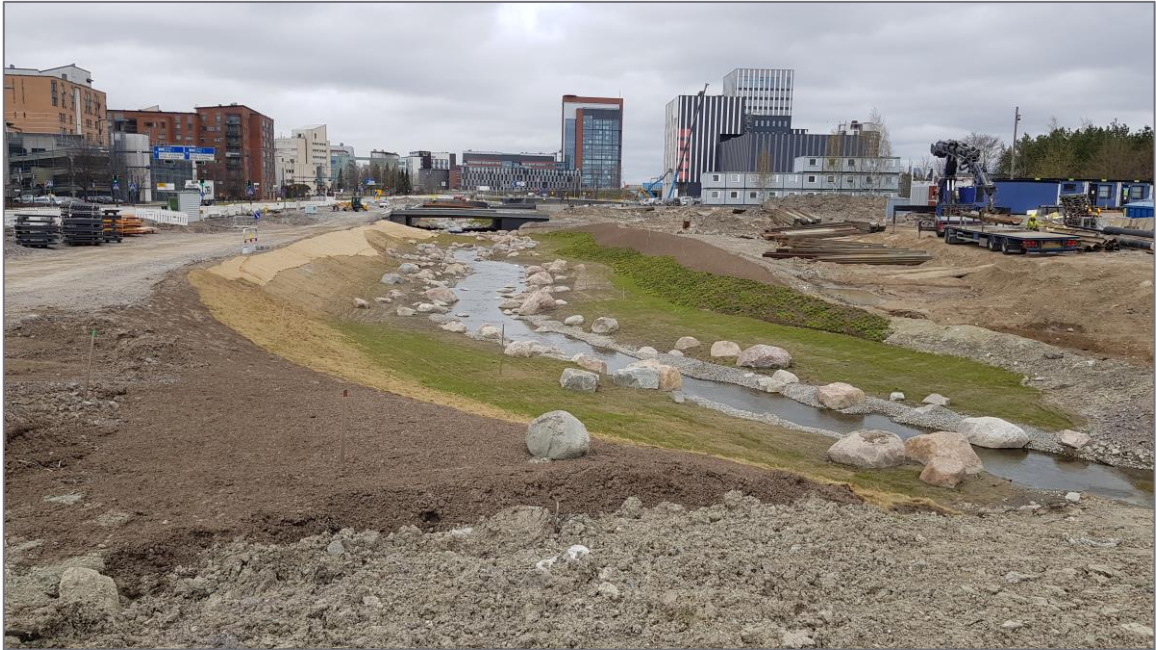
Kuva 7. Uoman luiskat on eroosiosuojattu heti niiden muotoilun jälkeen (kuva: Harri Aulaskari).
