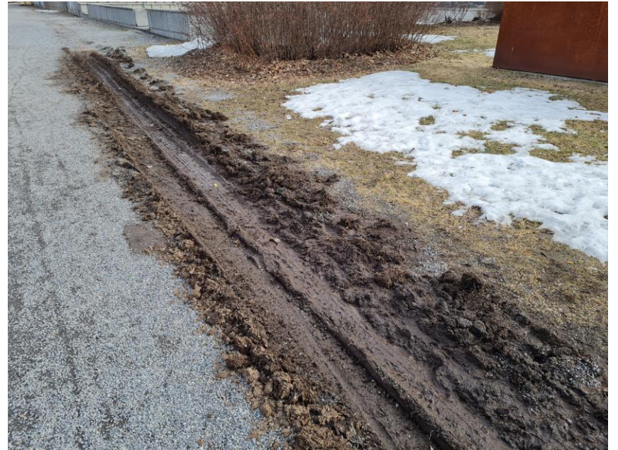
Työmaareittien sijoittaminen kantaville alustoille on tärkeää, sillä pehmeillä alustoilla liikennöinti muuttaa pintakerroksen eroosioherkäksi
