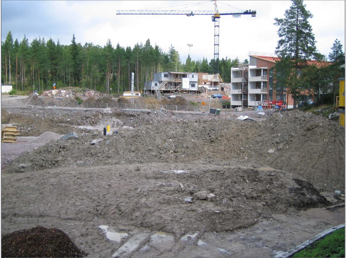
Kuva 1. Tyypilliseen taajaman ulkopuoliseen rakennuskohteeseen voi liittyviä laajoja, ylijäämämaiden läjitykseen ja säilytykseen käytettyjä alueita. Sitomattomilta maapinnoilta kulkeutuu merkittäviä määriä kiintoainepitoisia hulevesiä, jollei työmaalla ole toteutettu eroosiota ja kiintoaineen kulkeutumista vähentäviä toimenpiteitä (kuva: Nora Silanpää).
