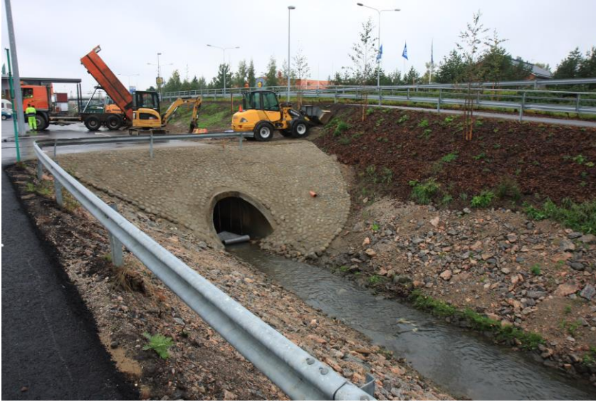
Kuva 4. Lahden Paskurinojan penkereitä eroosiosuojataan rakentamisen loppuvaiheessa.
