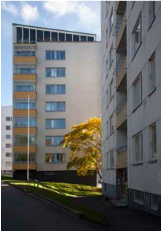
Yrjönkatu edustaa 1960-luvun uutta keveää arkkitehtuuria.
