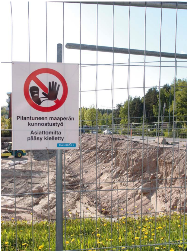
Kuva 12. Pilaantuneen maaperän kunnostustyömaa Lahden Sopenkorvessa (kuva Riikka Mäyränpää).
