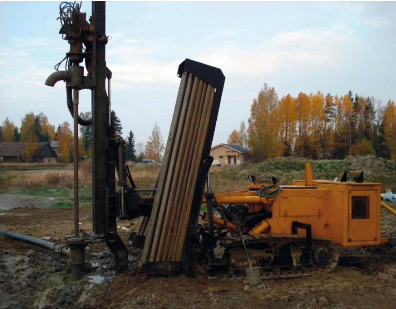
Kuva 5. Maalämpökaivon porausta (Uurtamo 2011).
