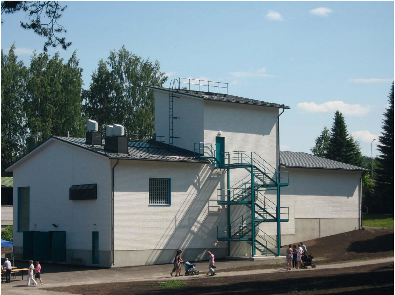
Kuva 2. Lahti Aquan Jalkarannan vedenottamolla vietettiin avoimien ovien päivää kesällä 2011 (kuva Riikka Mäyränpää).
