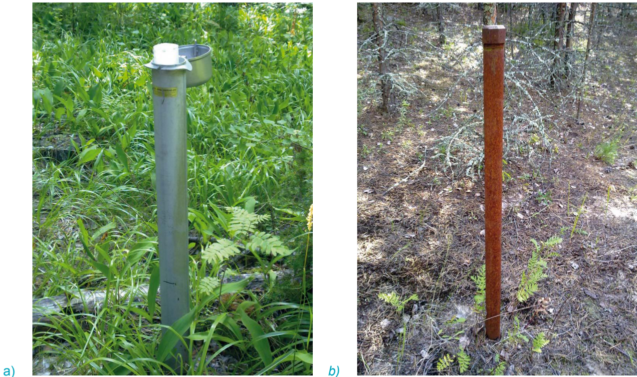
Kuva 13. a) Suojaputkellinen, muovinen havaintoputki, b) Vanha rautainen havaintoputki, jota voidaan käyttää enää vain pinnankorkeuden seurantaan (kuvat Riikka Mäyränpää).
